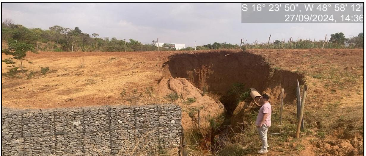
**Figura 15.** Erosão já comprometendo o talude do aterro, mesmo com gabião instalado para contenção.
