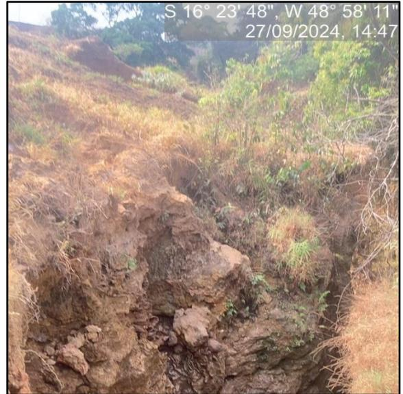
**Figura 17.** Início do solapamento de talude do curso natural no fundo do vale.
