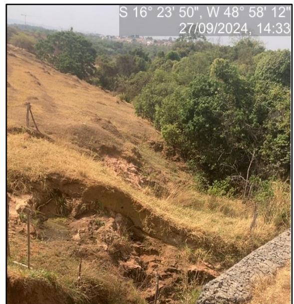
**Figura 14.** Início do processo erosivo na saída d'água do Reservatório 01
