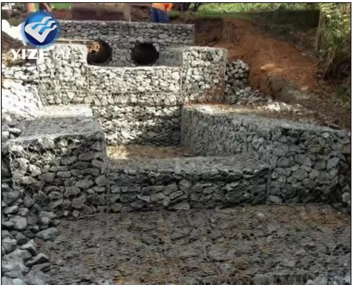
**Figura 24.** Imagem ilustrativa do tipo de estrutura recomendada. Fonte: Yize Metal Products.
