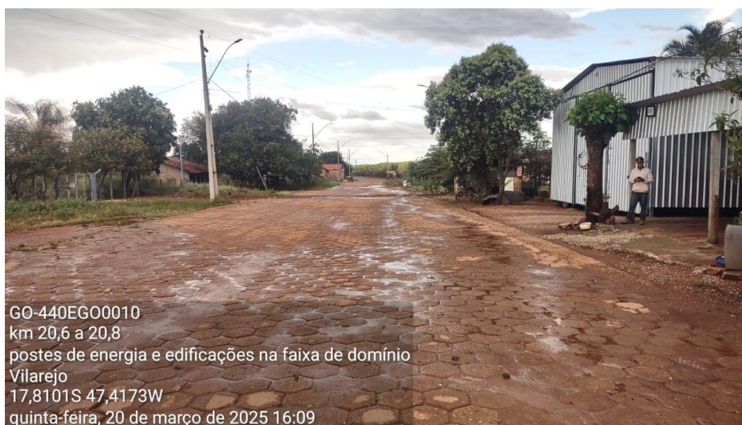
Foto 24 – Continuidade da rodovia ser pavimentada, com segmento coincidente de via urbana do Vilarajo Martírio, identificando possíveis interferências a serem evitadas
