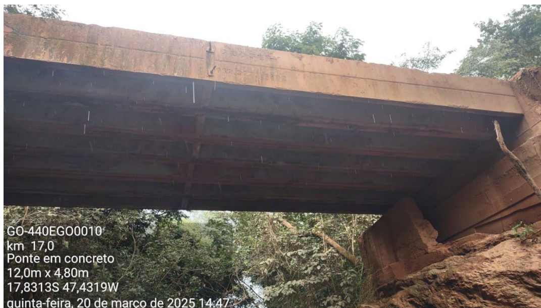
Foto 19 – Continuidade da rodovia ser pavimentada, com identificação de ponte em concreto armado, fora dos padrões para atendimento à via pavimentada
