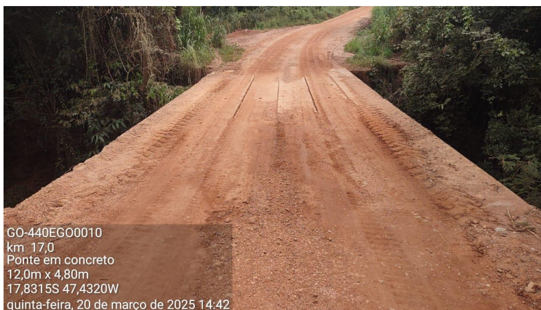
Foto 20 – Continuidade da rodovia ser pavimentada, com identificação de ponte em concreto armado, fora dos padrões para atendimento à via pavimentada
