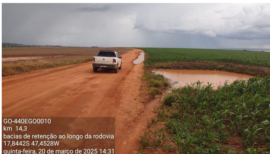
Foto 14 – Continuidade da rodovia ser pavimentada, com identificação de bacia de retenção nas proximidades da via existente
