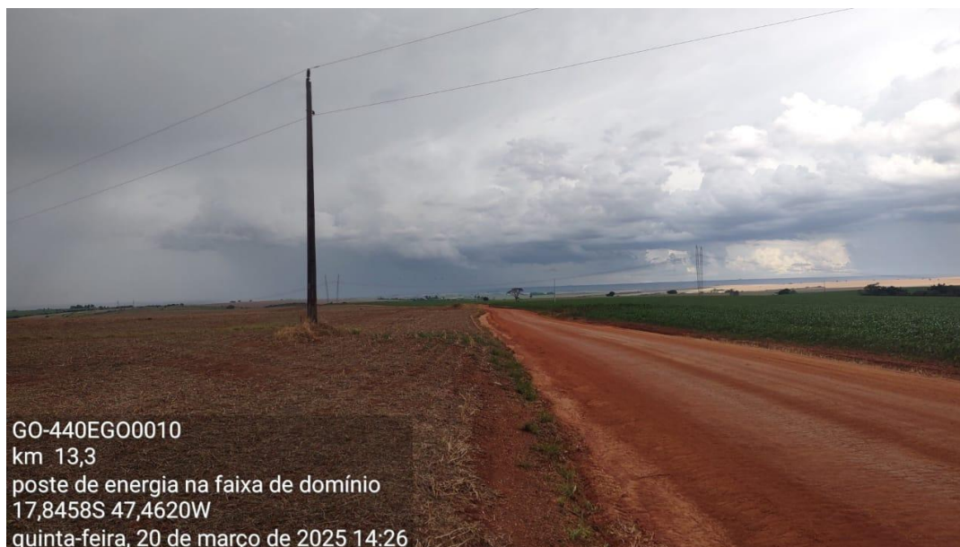
Foto 11 – Continuidade da rodovia ser pavimentada, com identificação de rede elétrica nas proximidades da via existente, podendo ser uma interferência
