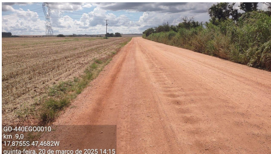
Foto 7 – Continuidade da rodovia ser pavimentada, com identificação de rede elétrica nas proximidades da via existente, podendo ser uma interferência
