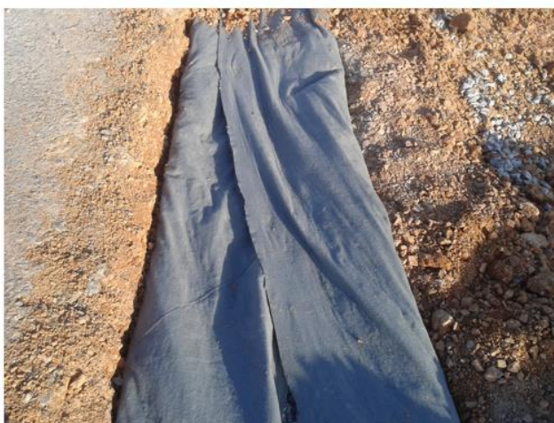
Figura 02 – Cobrimento com a Manta Geotêxtil
