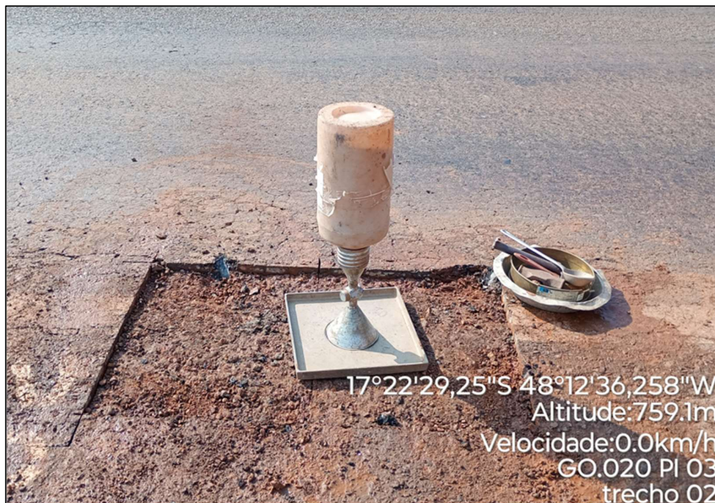
Figura 13 - Ensaio de Densidade In Situ.
