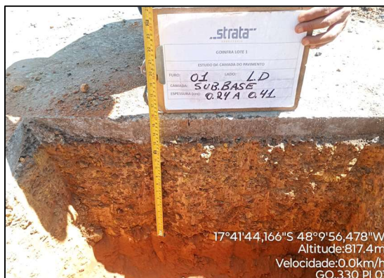
Figura 5 - Identificação das camadas e medição das espessuras.
