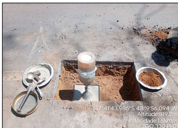
Figura 6 - Execução do ensaio de umidade e densidade in situ.
