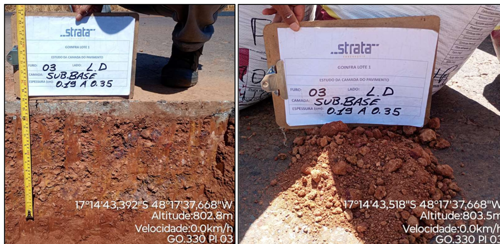
Figura 11 - Registro Fotográfico da Sub-base.
