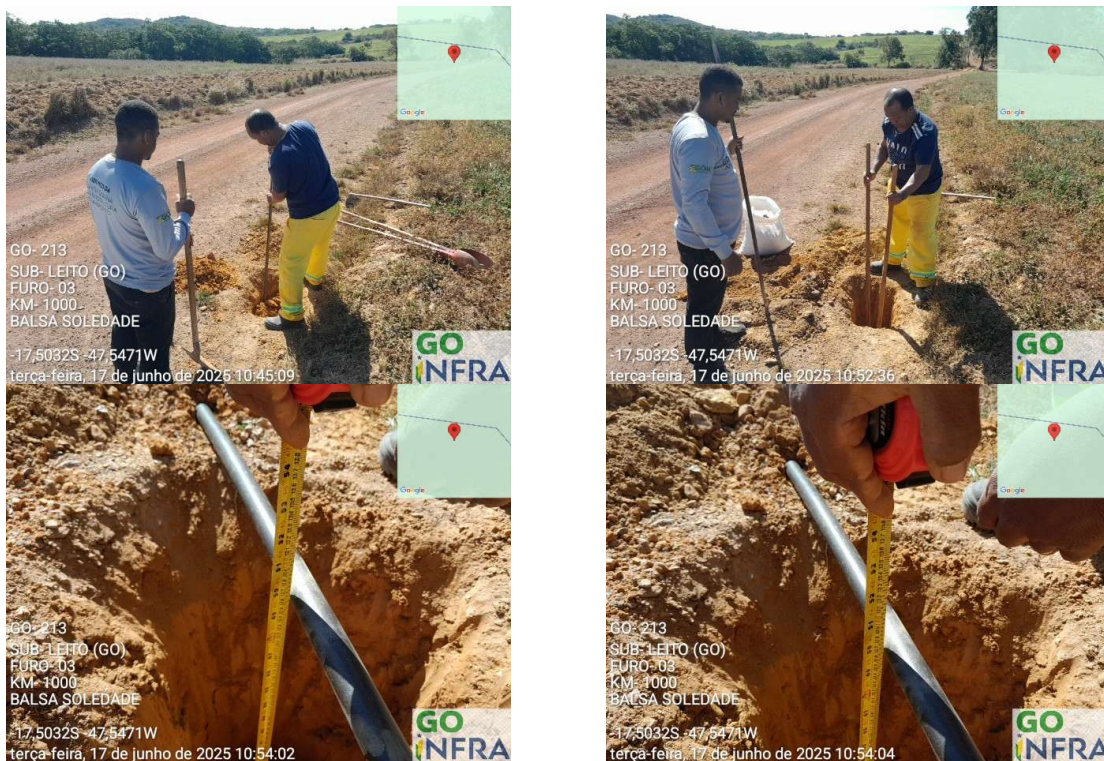
Figura 13 – Furo 03 – Subleito - Jusante Furo 03 – Subleito - Jusante
