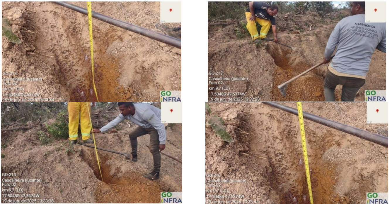
Figura 24 – Furo 02 – Cascalheira - Jusante Furo 02– Cascalheira – Jusante
