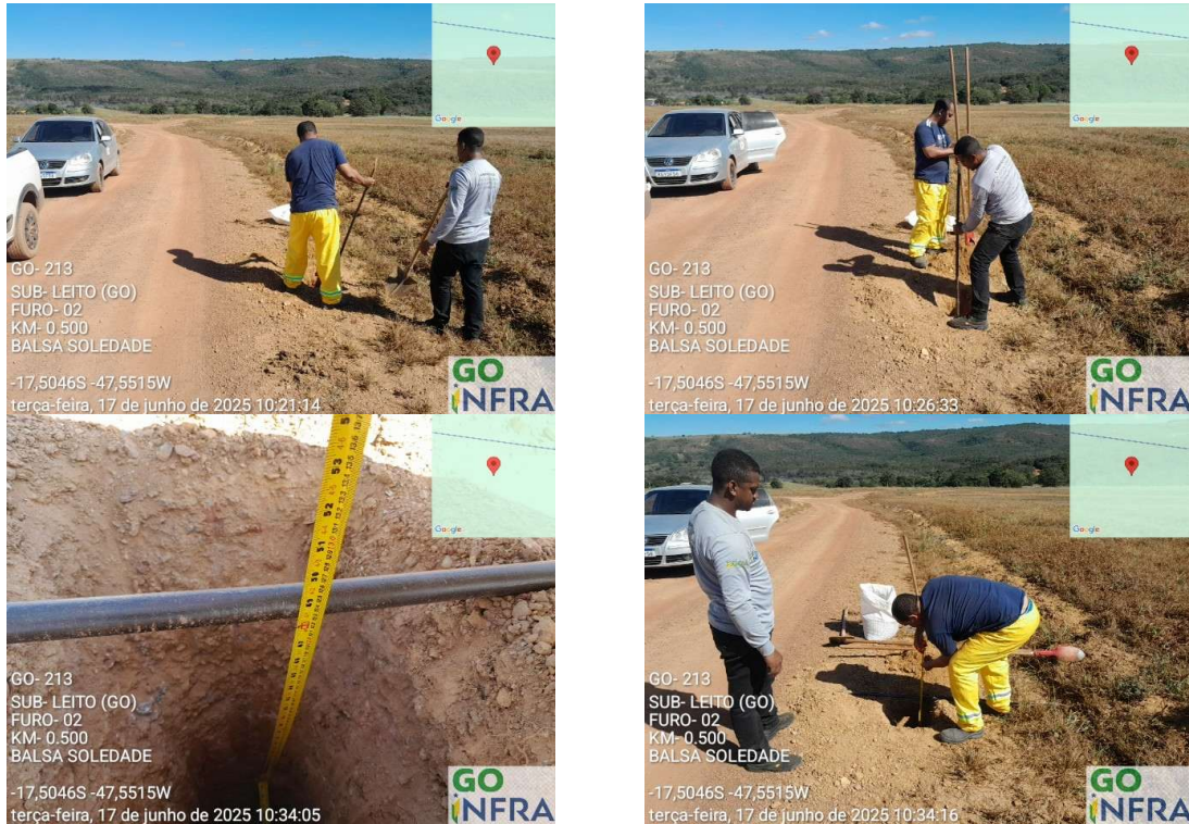
Figura 12 – Furo 02 – Subleito - Jusante Furo 02 – Subleito - Jusante
