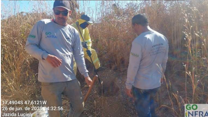
Figura 32 – Furo 05 – Cascalheira – Montante – Jazida Luciely Furo 05– Cascalheira – Montante – Jazida Luciely
