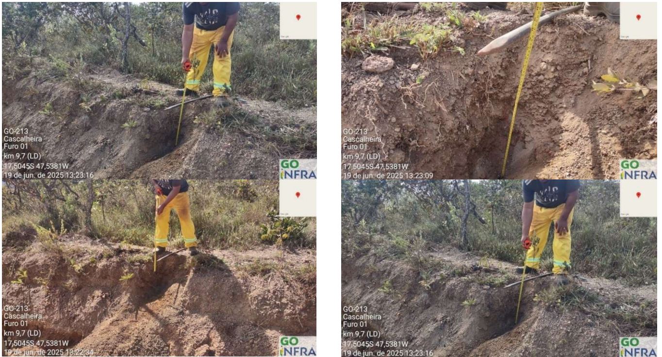
Figura 23 – Furo 01 – Cascalheira - Jusante Furo 01– Cascalheira – Jusante
