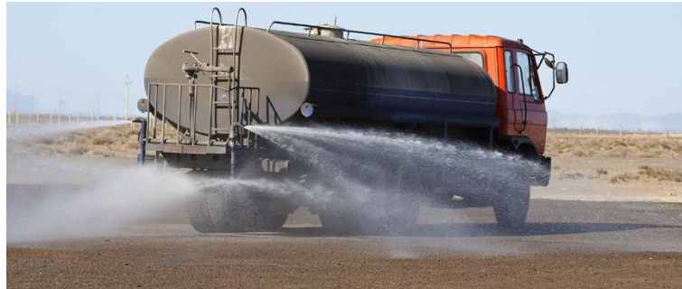
Figura 38 - Umidificação da rodovia para o controle de emissão de poeira.
