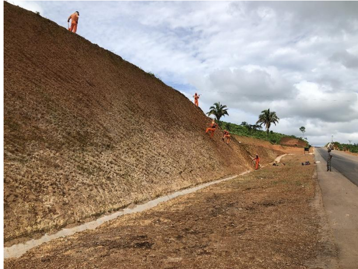
Figura 39 - Aplicação da sementeira manual.
