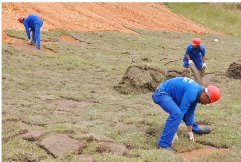
Figura 40 - Aplicação de gramas em placas.
