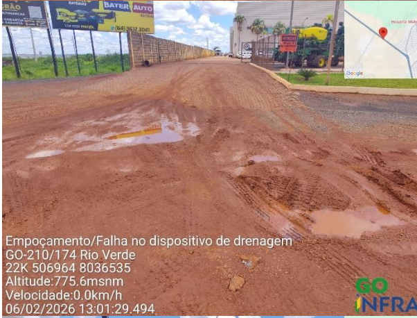
Empoçamento/Falha no dispositivo de drenagem GO-210/174 Rio Verde 22K 506973 8036552 Altitude:773.3msnm Velocidade:0.0km/h 06/02/2026 13:03:03.452
