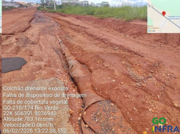
Colchão drenante exposto Falha de dispositivo de drenagem Falta de cobertura vegetal GO-210/174 Rio Verde 22K 506401 8036935 Altitude: 783.7msnm Velocidade: 0.0km/h 06/02/2026 13:21:42.936
