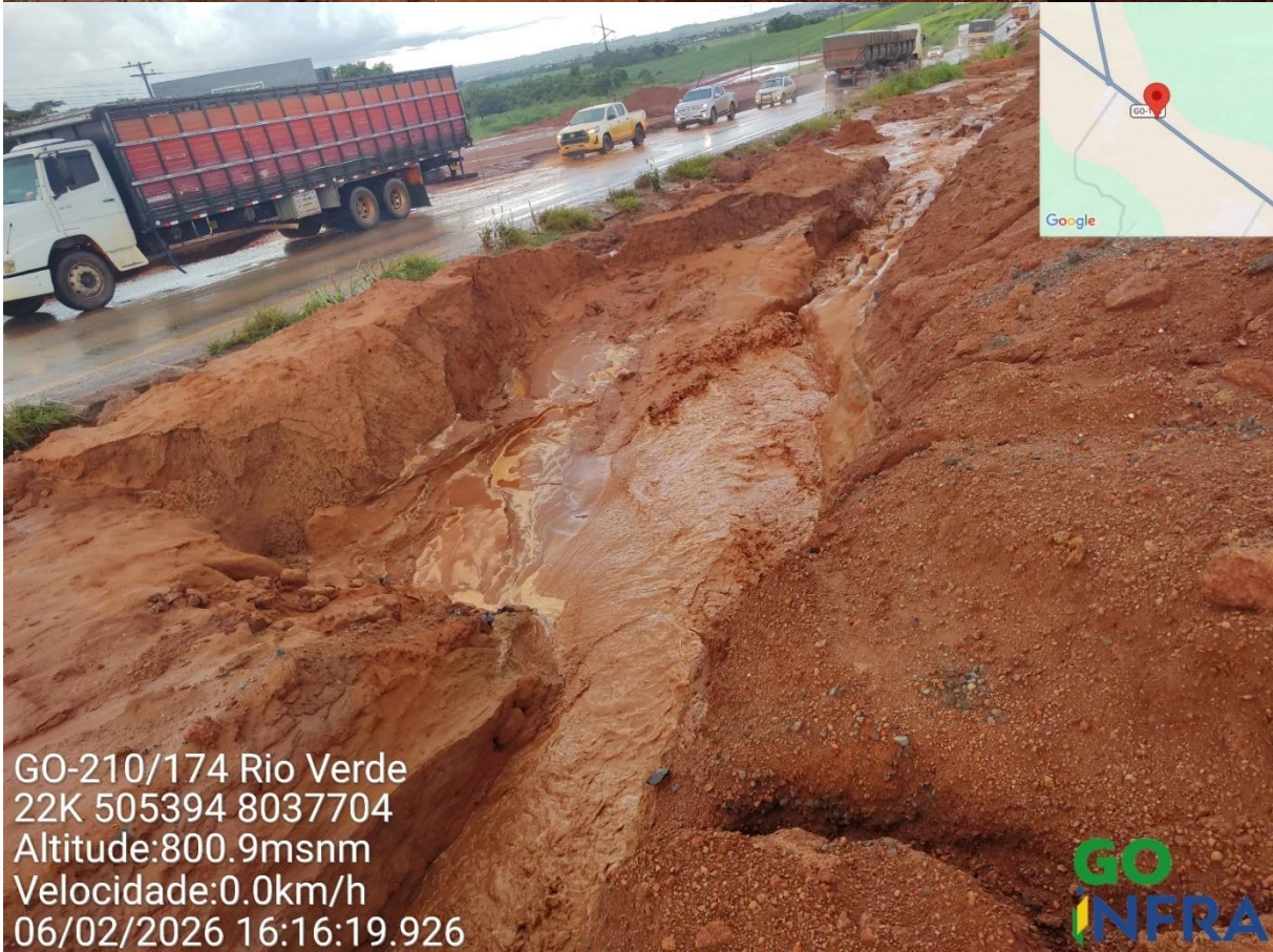
Processo erosivo identificado GO-210/174 Rio Verde 22K 505405 8037705 Altitude:802.8msnm Velocidade:0.0km/h 06/02/2026 14:00:48.297
