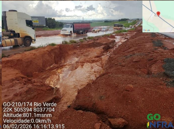
Processo erosivo identificado GO-210/174 Rio Verde 22K 505418 8037700 Altitude:802.2msnm Velocidade:1.0km/h 06/02/2026 14:00:27.677
