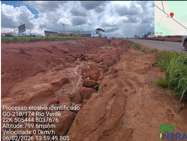
Processo erosivo identificado GO-210/174 Rio Verde 22K 505418 8037700 Altitude:802.2msnm Velocidade:1.0km/h 06/02/2026 14:00:27.677
