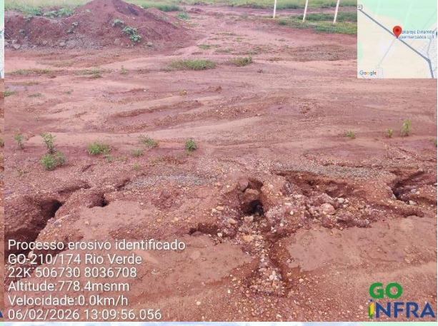
Processo erosivo identificado GO-210/174 Rio Verde 22K 506729 8036707 Altitude:778.8msnm Velocidade:0.0km/h 06/02/2026 13:09:51.535
