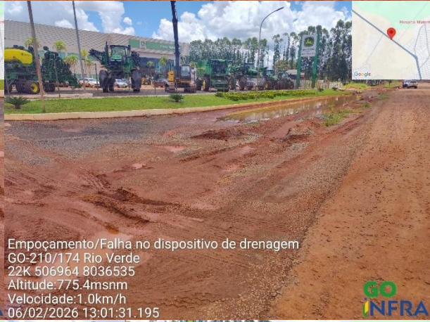
Empoçamento/Falha no dispositivo de drenagem GO-210/174 Rio Verde 22K 506964 8036535 Altitude:775.6msnm Velocidade:0.0km/h 06/02/2026 13:01:26.904
