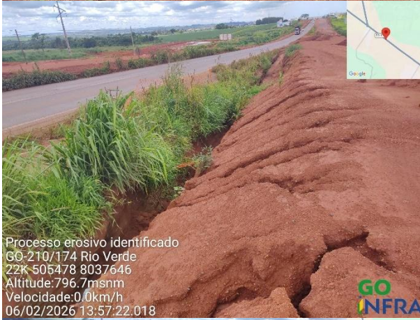
Processo erosivo identificado GO-210/174 Rio Verde 22K 505476 8037648 Altitude:796.4msnm Velocidade:0.6km/h 06/02/2026 13:57:12.461
