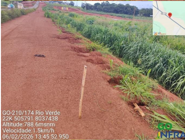
Processo erosivo identificado Empoçamento/Falha no dispositivo de drenagem GO-210/174 Rio Verde 22K 505812 8037422 Altitude:788.6msnm Velocidade:1.0km/h 06/02/2026 13:44:58.153
