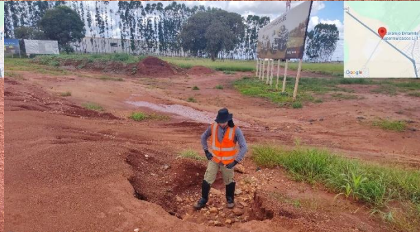
Processo erosivo identificado GO-210/174 Rio Verde 22K 506705 8036728 Altitude:780.5msnm Velocidade:0.0km/h 06/02/2026 13:12:19.789
