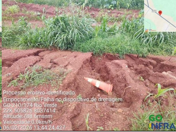
Processo erosivo identificado Empoçamento/Falha no dispositivo de drenagem GO-210/174 Rio Verde 22K 505832 8037412 Altitude:787.6msnm Velocidade:10.4km/h 06/02/2026 13:44:13.325
