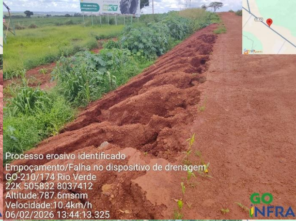
Processo erosivo identificado Empoçamento/Falha no dispositivo de drenagem GO-210/174 Rio Verde 22K 505851 8037396 Altitude:788.5msnm Velocidade:0.0km/h 06/02/2026 13:43:44.210
