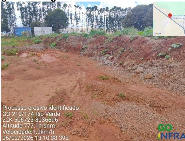
Processo erosivo identificado GO-210/174 Rio Verde 22K 506723 8036698 Altitude:777.6msnm Velocidade:0.0km/h 06/02/2026 13:10:45.585
