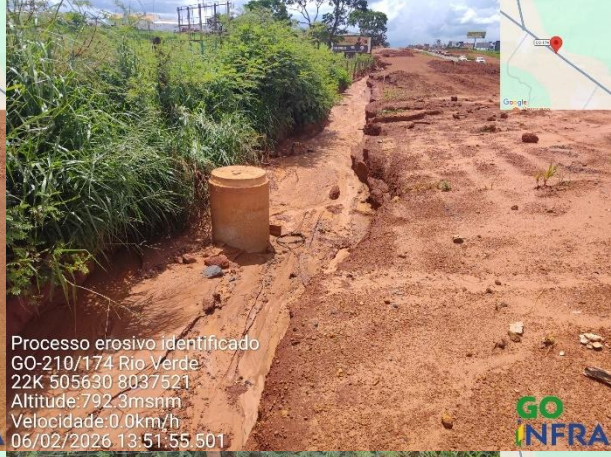
Bueiros obstruídos GO-210/174 Rio Verde 22K 505643 8037513 Altitude:786.4msnm Velocidade:0.0km/h 06/02/2026 13:50:44.491
