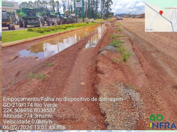
Empoçamento/Falha no dispositivo de drenagem GO-210/174 Rio Verde 22K 506964 8036535 Altitude:775.4msnm Velocidade:1.0km/h 06/02/2026 13:01:31.195
