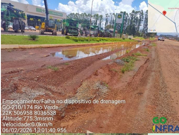
Empoçamento/Falha no dispositivo de drenagem GO-210/174 Rio Verde 22K 506964 8036535 Altitude:775.6msnm Velocidade:0.0km/h 06/02/2026 13:01:29.494
