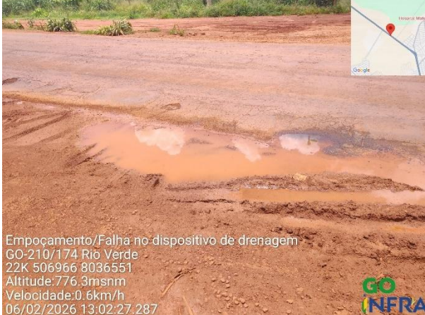
Empoçamento/Falha no dispositivo de drenagem GO-210/174 Rio Verde 22K 506958 8036538 Altitude:775.3msnm Velocidade:0.0km/h 06/02/2026 13:01:40.956
