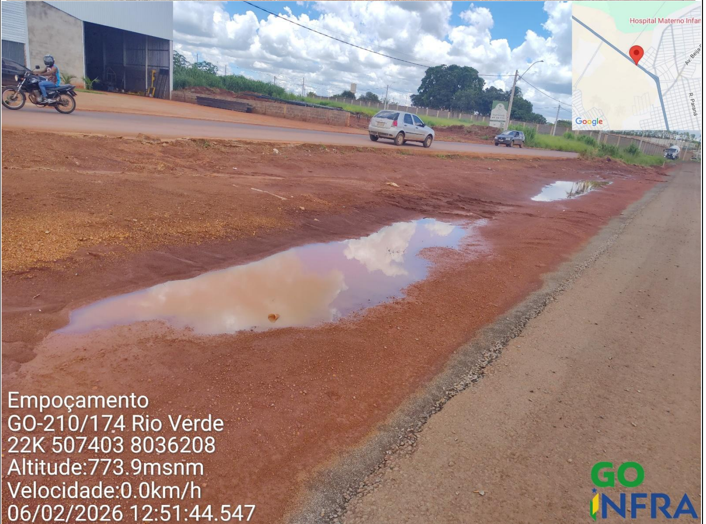
Empoçamento/Falha no dispositivo de drenagem GO-210/174 Rio Verde 22K 507366 8036230 Altitude:774.6msnm Velocidade:0.0km/h 06/02/2026 12:52:28.607
