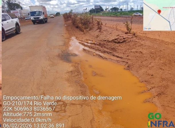
Empoçamento/Falha no dispositivo de drenagem GO-210/174 Rio Verde 22K 506956 8036537 Altitude:774.3msnm Velocidade:0.0km/h 06/02/2026 13:01:45.806
