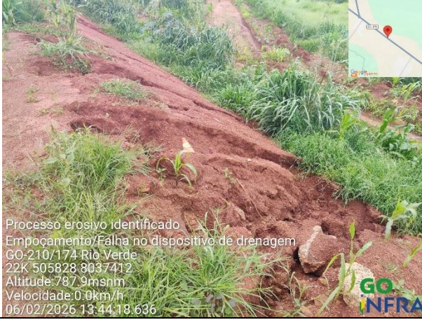
Processo erosivo identificado Empoçamento/Falha no dispositivo de drenagem GO-210/174 Rio Verde 22K 505841 8037401 Altitude:787.4msnm Velocidade:0.5km/h 06/02/2026 13:43:56.831
