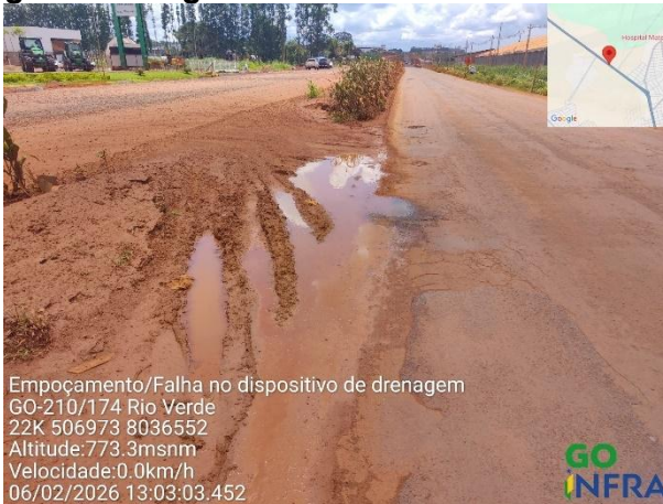
Empoçamento/Falha no dispositivo de drenagem GO-210/174 Rio Verde 22K 506964 8036535 Altitude:775.6msnm Velocidade:0.0km/h 06/02/2026 13:01:26.904
