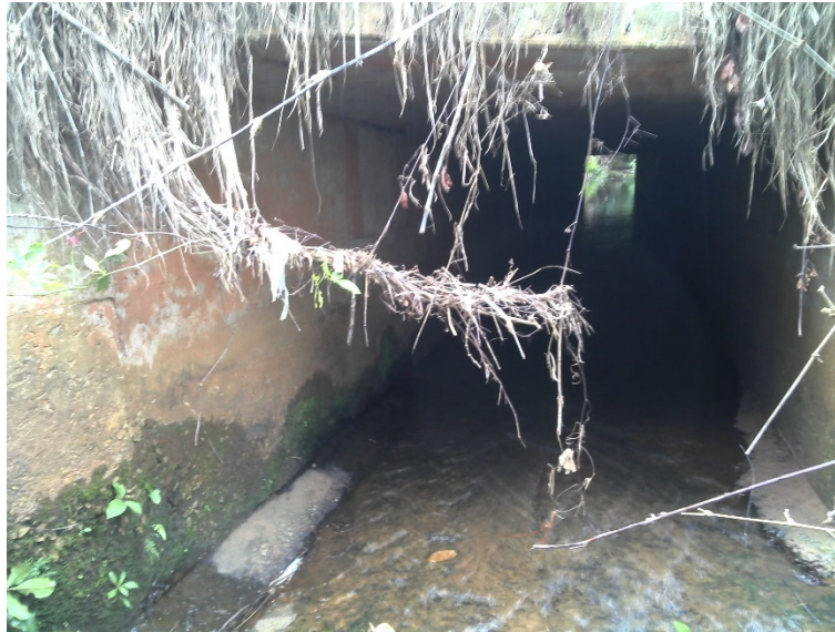
Figura 32. Bueiro BDCC 2,00 x 2,00 m localizado na estaca 1046 da rodovia GO-070.
