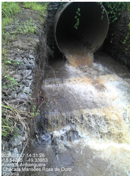
Figura 30. Bueiro BSTM de diâmetro 2,80m localizado na estaca 66 da rodovia GO-070.
