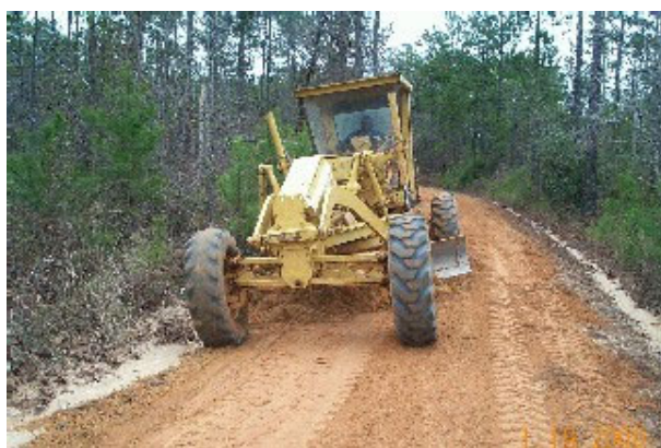
Figura 36 - Execução e manutenção de "bigodes" com moto niveladora.
