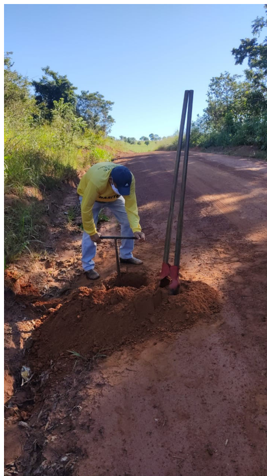
Foto 6: Sondagem estaca 81+5
