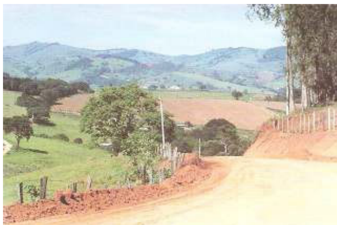
Figura 39 - Exemplo de leira bem executada.
