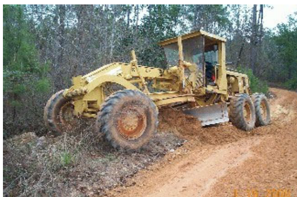
Figura 37 - Execução e manutenção de "bigodes" com moto niveladora.
