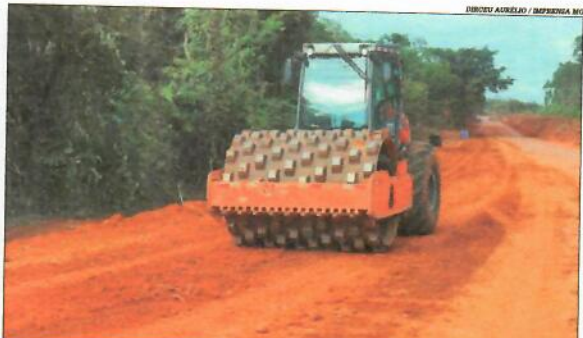
Projeto será executado com os recursos de reparação ao rompimento da barragem da Vale
