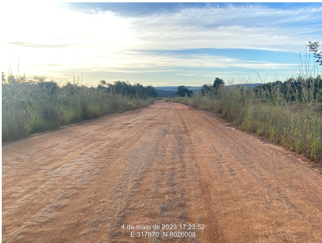
Km 30,20 –Subtrecho sem pavimentação
