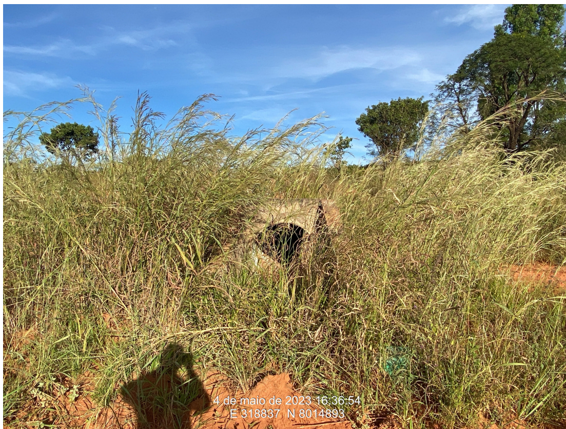
Km 18,90 – Bueiro tubular existente BSTC \phi 1,0m
