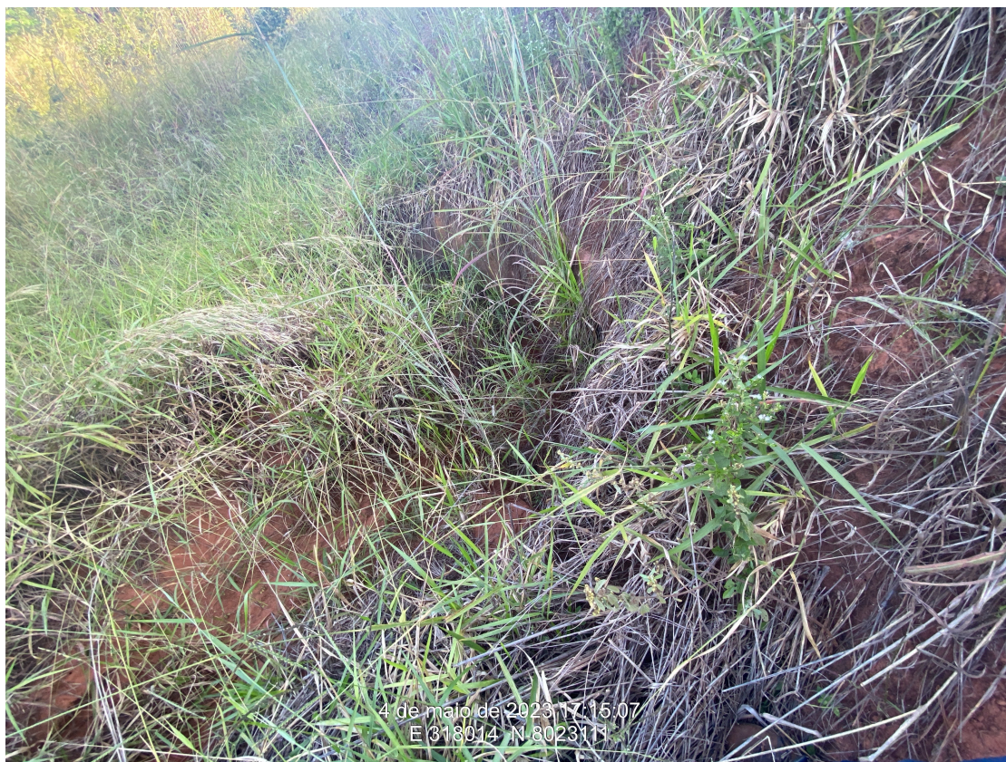
Km 26,50 – Bueiro tubular existente
