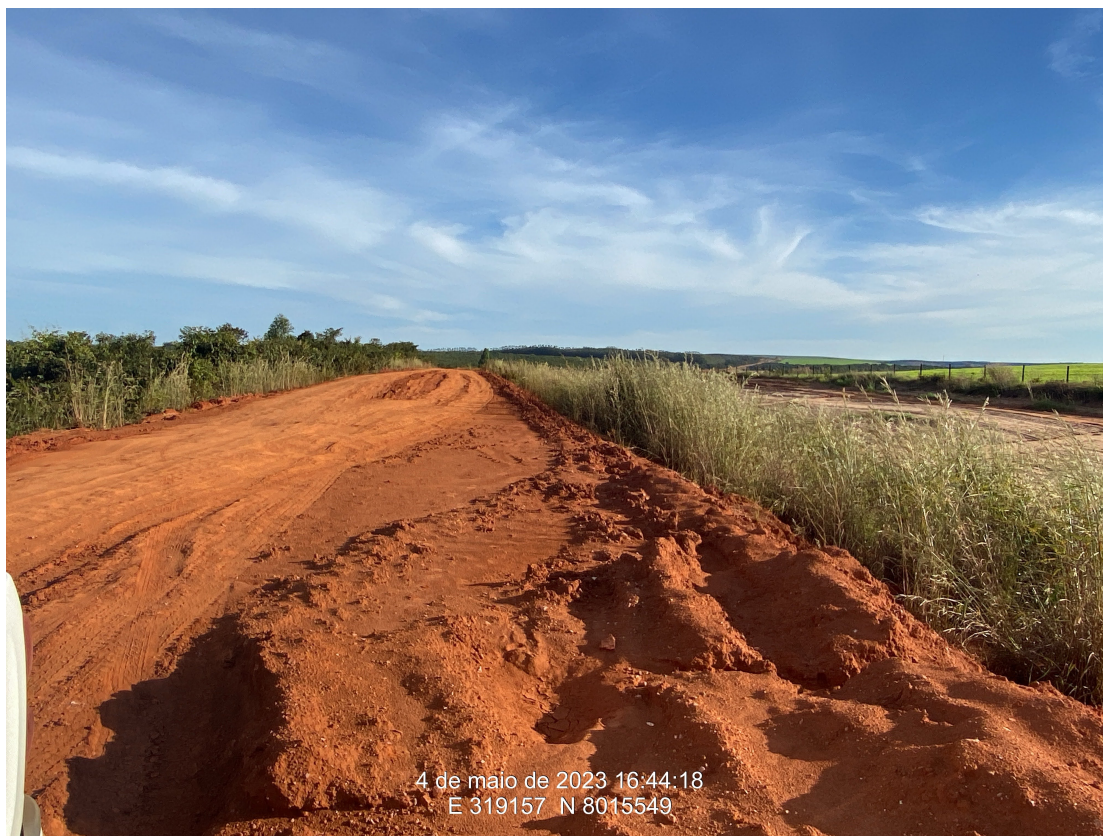
Km 19,60 – Pista em aterro com via lateral
