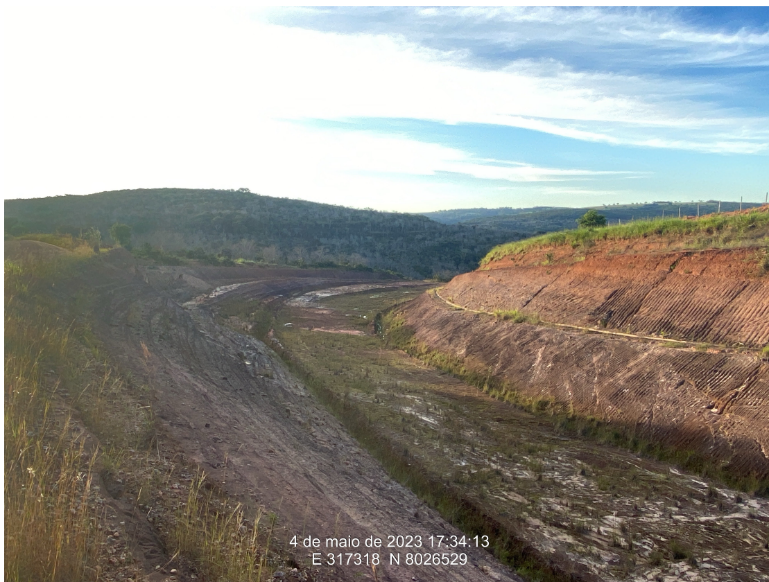
Km 31,30 – Nova pista com terraplenagem executada
