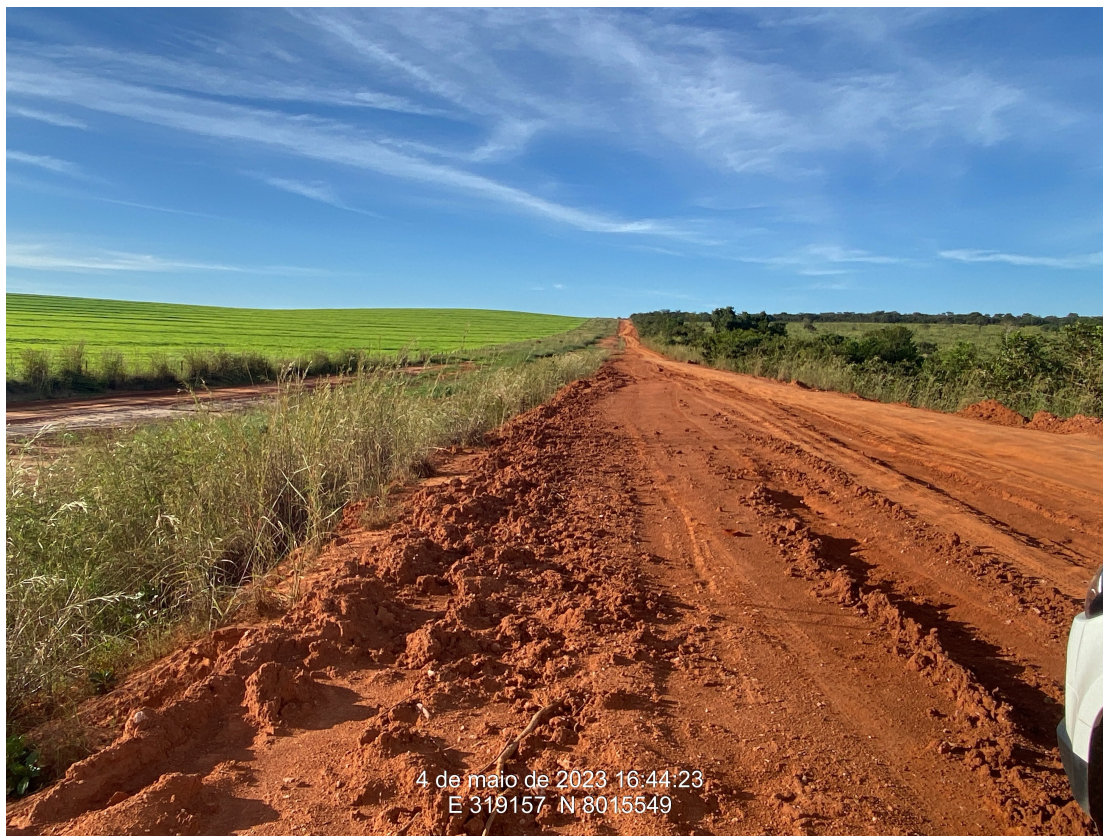
Km 19,60 – Bueiro tubular existente
