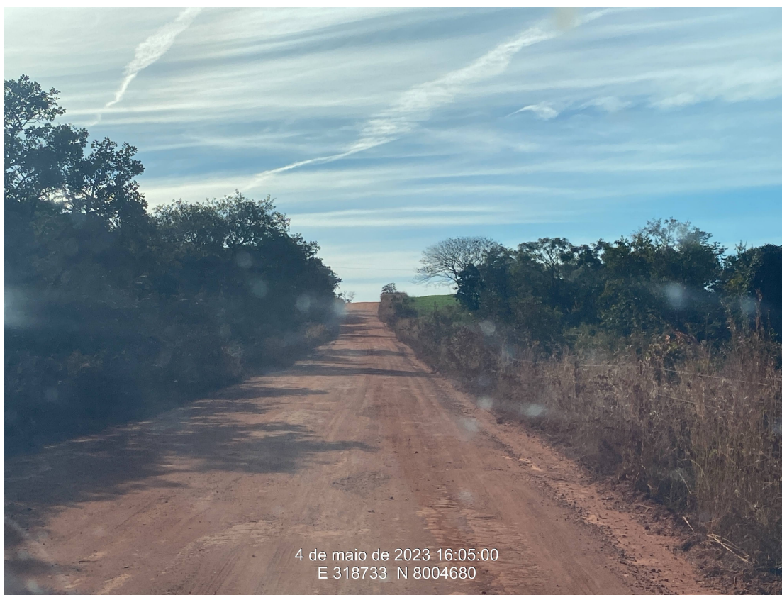
Km 5,80 – Situação da via
