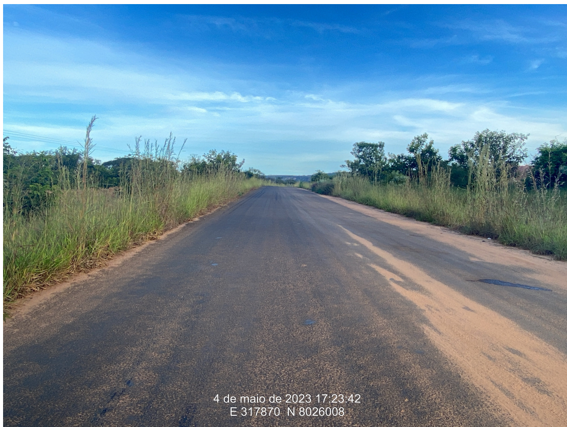
Km 30,20 – Final da pavimentação
