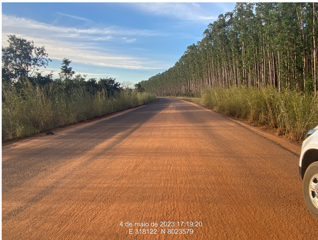
Km 28,20 – Início da pavimentação
