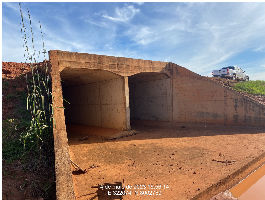
Km 1,30 – Bueiro Celular construído BDCC 2,5x2,5
