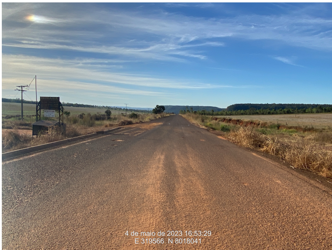
Km 22,20 – Início da Pavimentação
