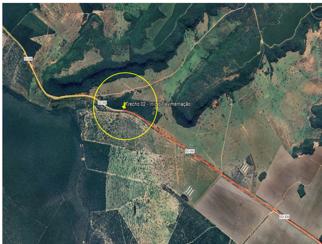
Final do subtrecho 01 da GO-306, início da pavimentação
