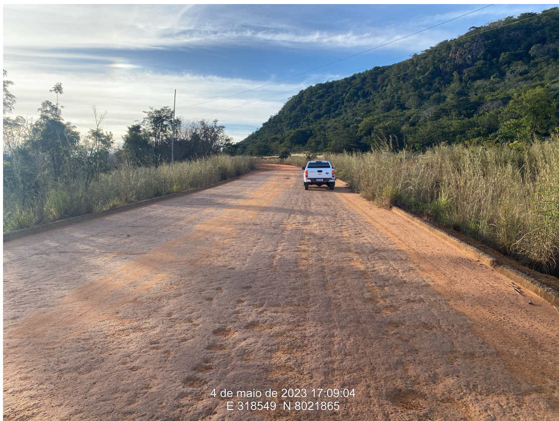
Km 26,30 – Subtrecho sem pavimentação
