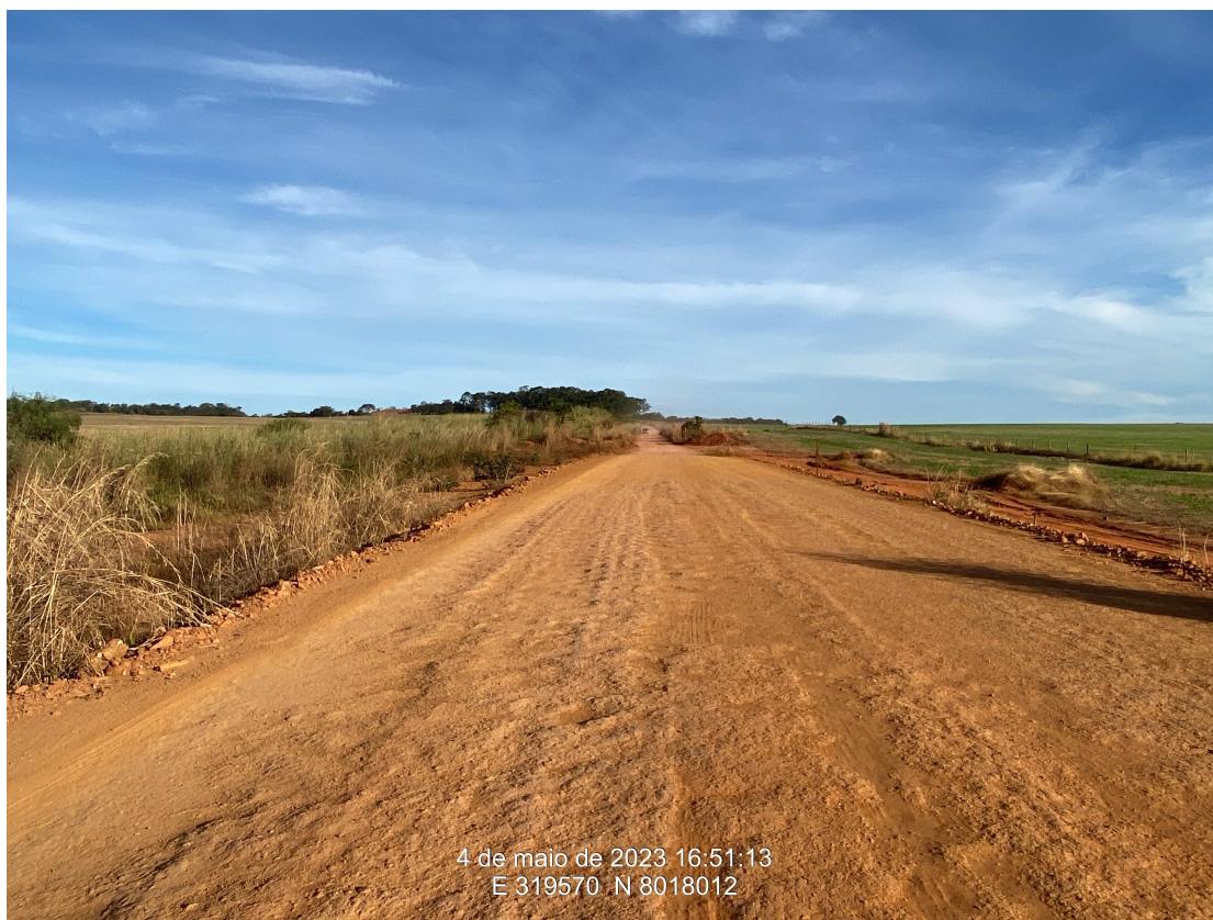
Km 22,20 – Aspecto da via, final do subtrecho
