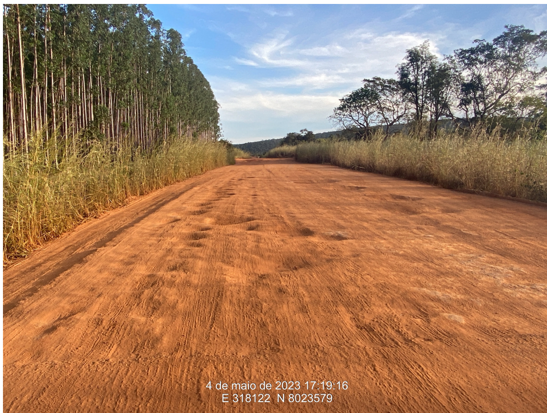
Km 28,20 – Aspecto do segmento final sem pavimentação
