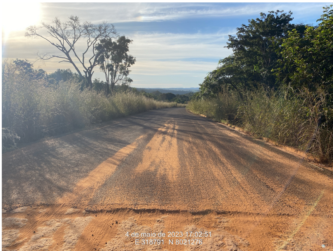
Km 25,60 – Início do subtrecho pavimentado
