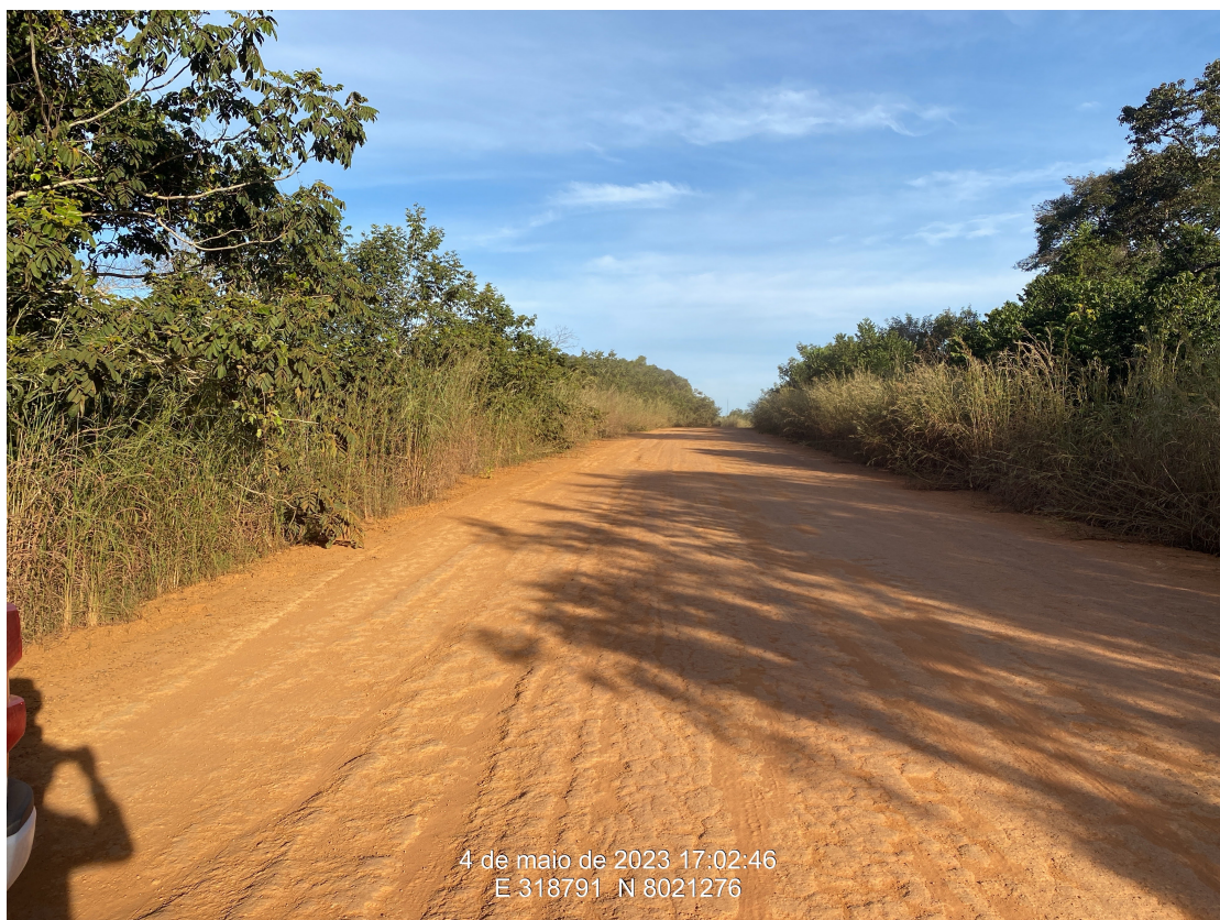
Km 25,60 – Aspecto da via no subtrecho sem pavimentação
