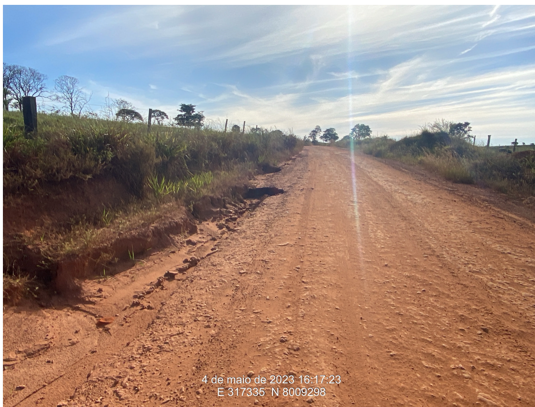
Km 11,90 – Erosão nas laterais da pista, devido ao escoamento de água
