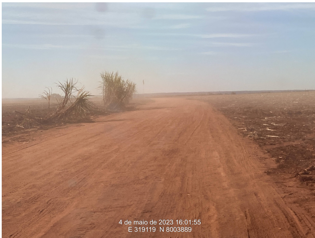
Km 4,90 – Pista sem delimitação da faixa de domínio
