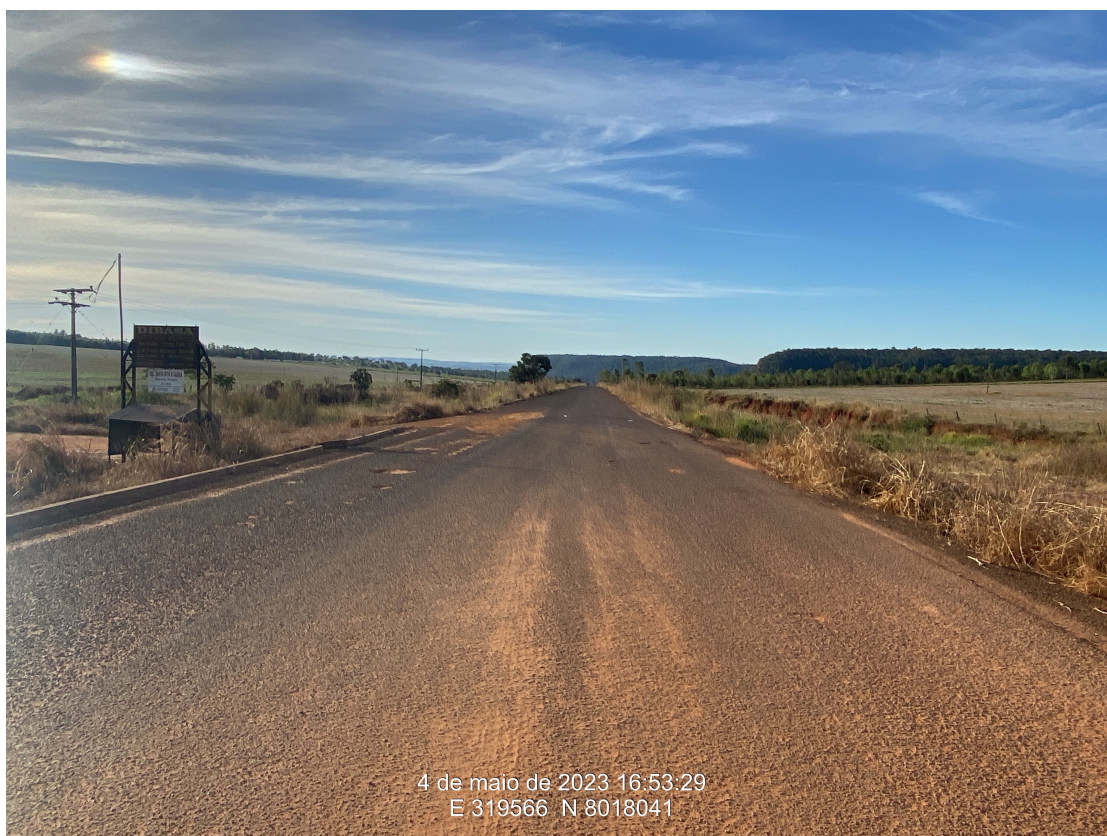
Km 22,2 – Início do subtrecho 02, início da pavimentação (17°55'5.27"S, 52°42'12.76"O).
