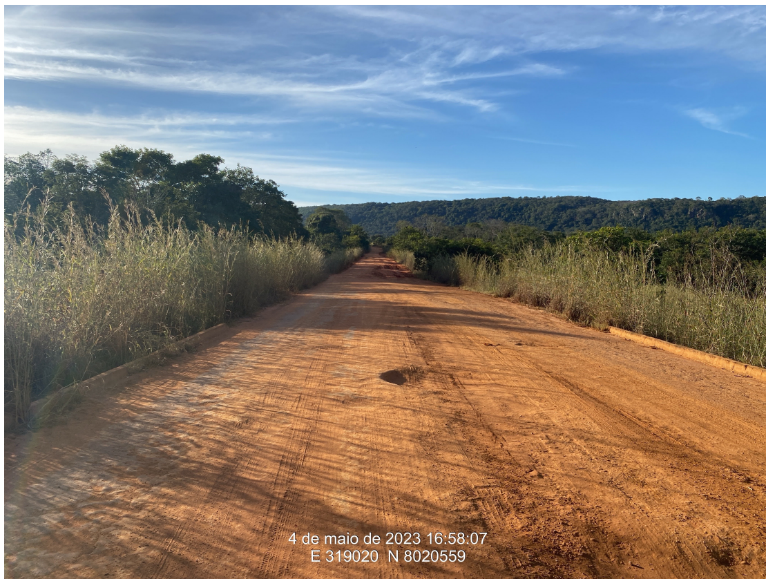
Km 24,90 – Início do subtrecho sem pavimentação
