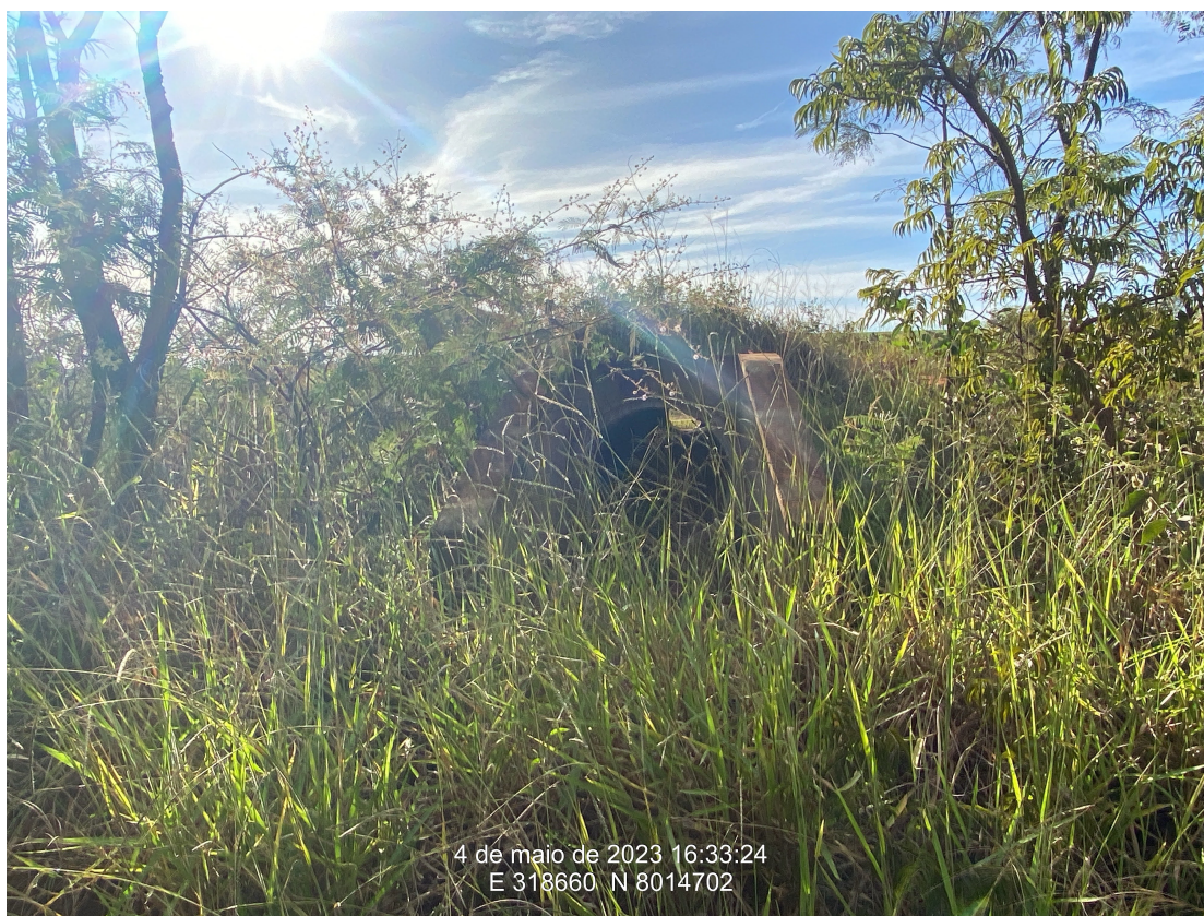
Km 18,60 – Bueiro tubular existente BSTC \phi 1,0m
