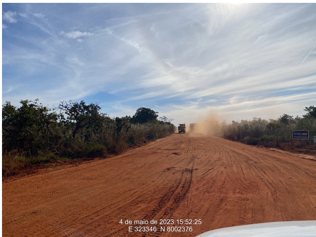
Km 0,00 – Início do subtrecho da GO-306, entroncamento com a GO-050
