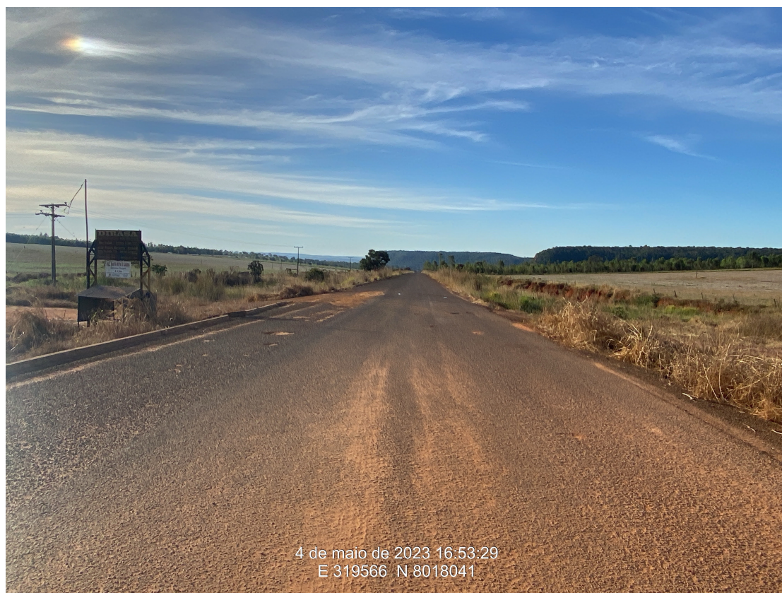
Km 22,2 – Final do subtrecho 01, início da pavimentação (17°55'5.24"S, 52°42'12.67"O).
