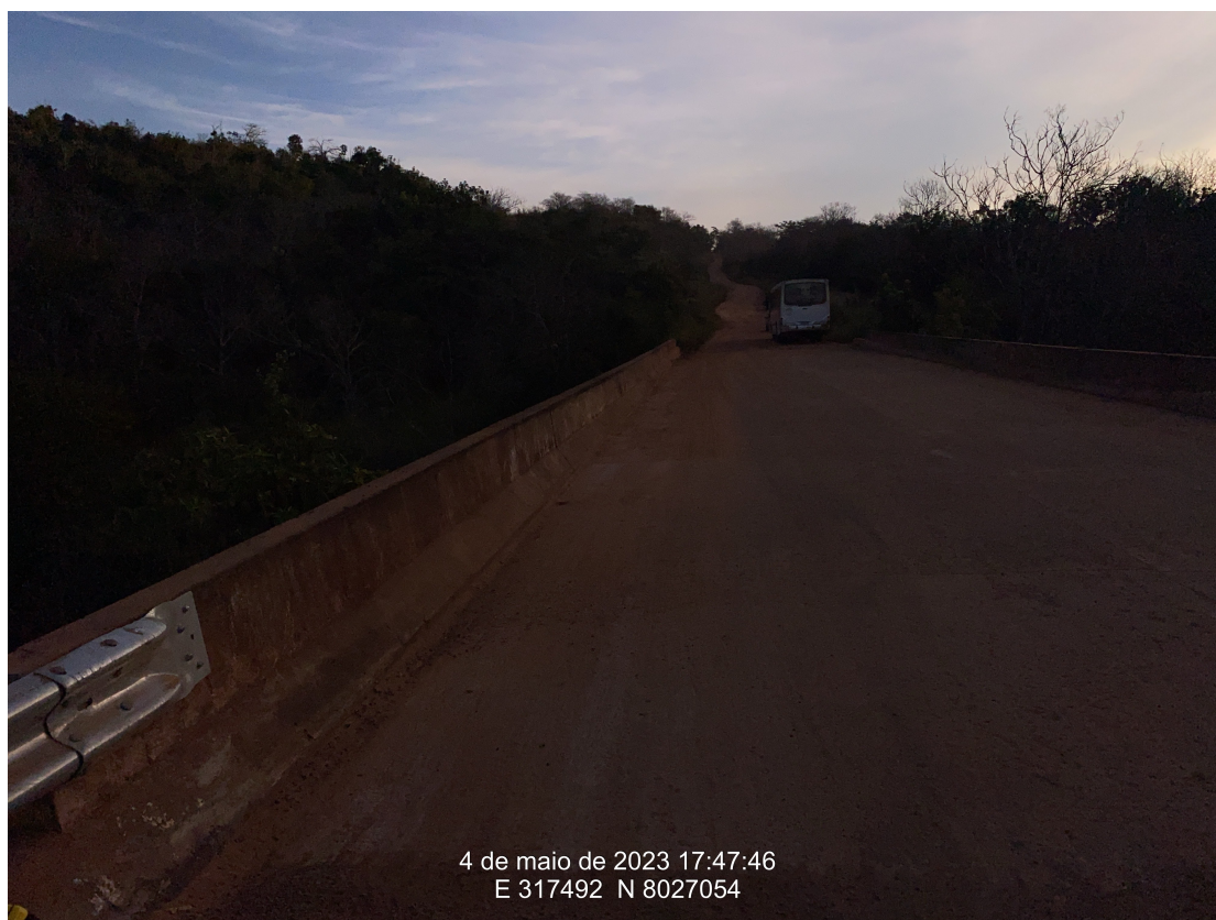
Km 32,4 – Final do subtrecho 02, Ponte sobre o Ribeirão Grande ( 17^{\circ}50'11.36''S , 52^{\circ}43'20.52''O ).
