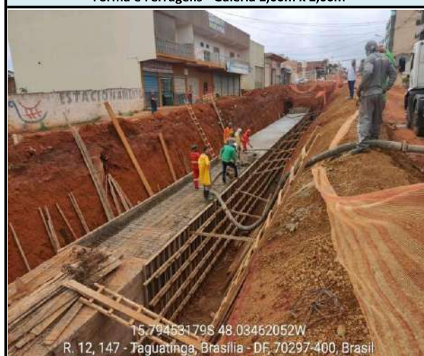
Concretação Galeria 2,00m x 2,00m
