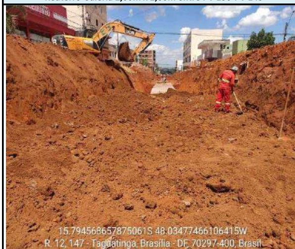
Reaterro Galeria 2,00m x 2,00m entre PV 150-PV 143
