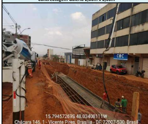
Concretação Galeria 2,00m x 2,00m
