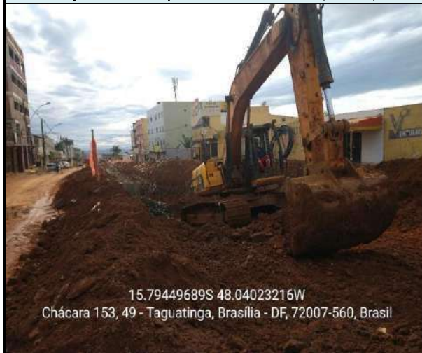
15.79447316S 48.03996616W Chácara 153, 49 - Taguatinga, Brasília - DF, 72007-560, Brasil Escavação Vala e Transporte Bota Fora - Galeria 2,00m x 2,00m
