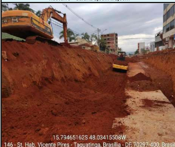
Reaterro - Galeria 2,00m x 2,00m
