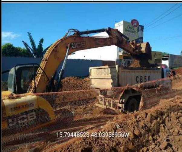
Escavação Vala e Transporte Bota Fora - Galeria 2,00m x 2,00m
