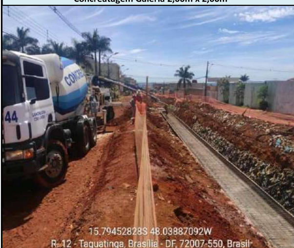
Concretação Galeria 2,00m x 2,00m
