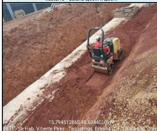
Reaterro - Galeria 2,00m x 2,00m
