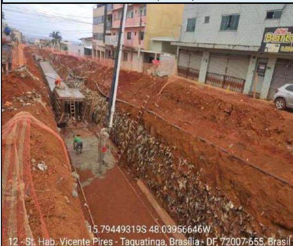
Concretagem do Fundo - Galeria 2,00m x 2,00m
