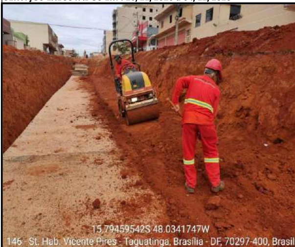
Reaterro - Galeria 2,00m x 2,00m
