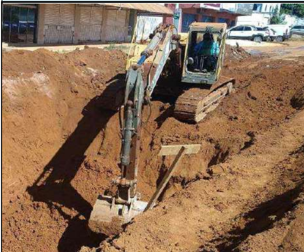
Escavação Vala - Galeria 2,00m x 2,00m entre PV 150-PV 143
