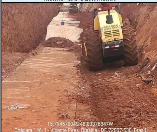
Reaterro - Galeria 2,00m x 2,00m
