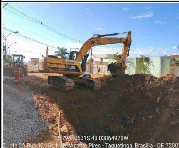
Escavação Retirada Lixo (Troca de Solo) - Est 54 a Est. 65+10,00 - Bordo Direito
