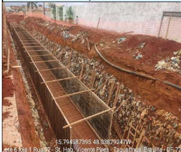
Forma e Ferragens - Galeria 2,00m x 2,00m
