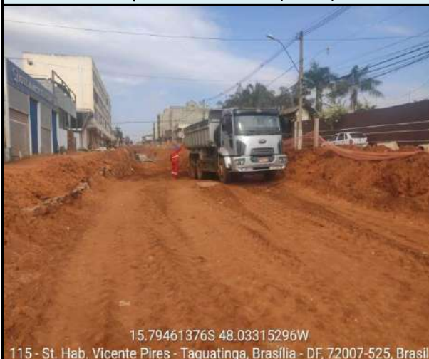
Material para Reaterro - Galeria 2,00m x 2,00m
