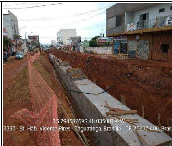
Forma e Ferragens - Galeria 2,00m x 2,00m entre PV 150-PV 143
