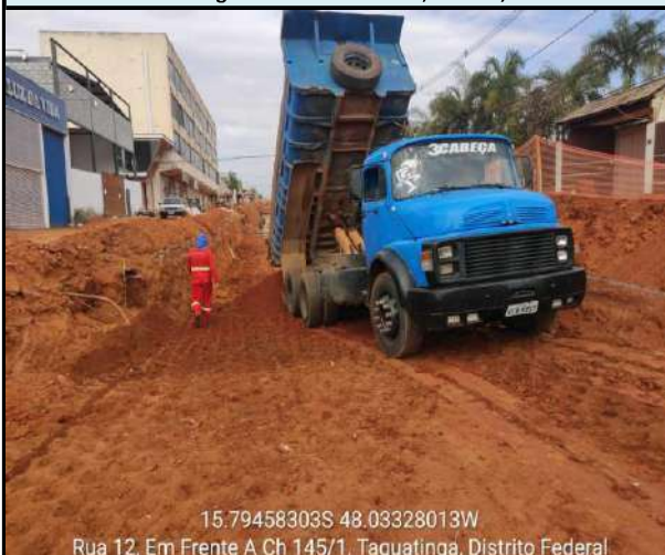
Material para Reaterro - Galeria 2,00m x 2,00m
