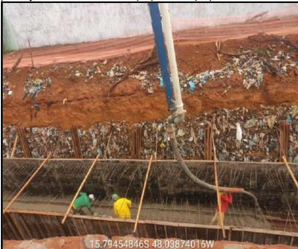
Concretagem Radier - Galeria 2,00m x 2,00m
