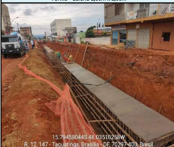
Concretação Galeria 2,00m x 2,00m
