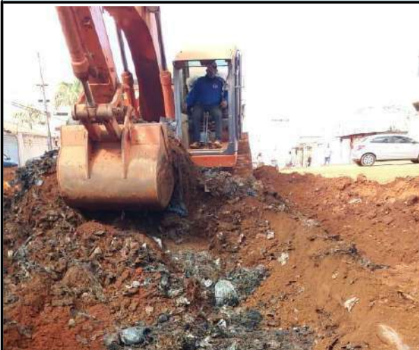
Escavação Vala (com lixo) - Galeria 2,00m x 2,00m
