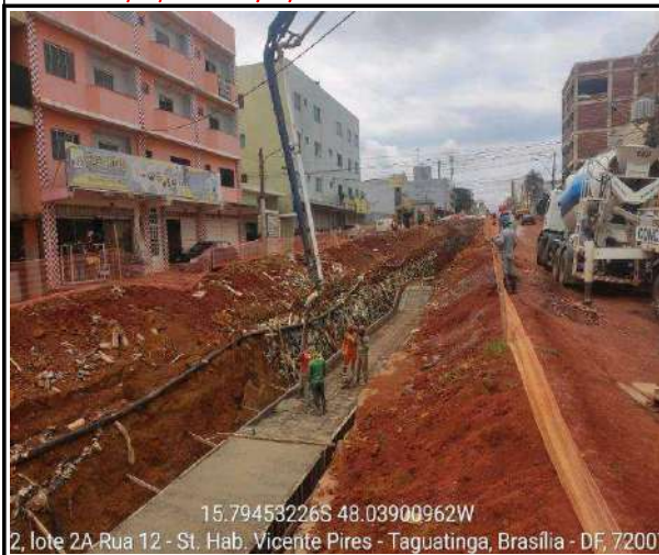
Forma - Galeria 2,00m x 2,00m entre PV 150-PV 143
