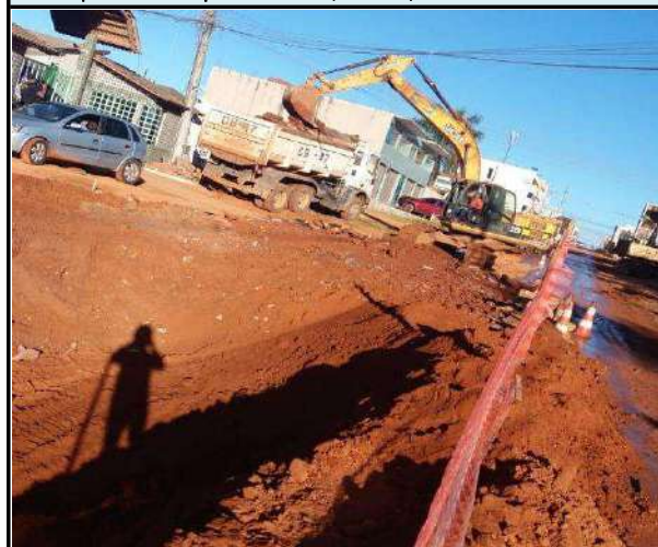
Transporte Bota Espera-Galeria 2,00m x 2,00m entre PV 150-PV 143
