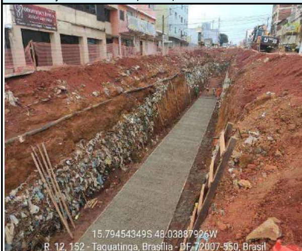
Concretagem do Fundo - Galeria 2,00m x 2,00m entre PV 150-PV 143
