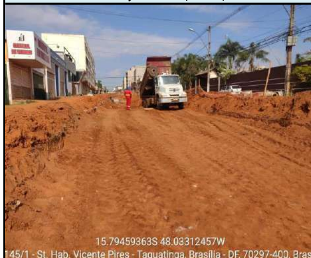
Material para Reaterro - Galeria 2,00m x 2,00m
