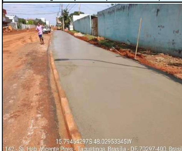
Concretagem - Calçada Rua 12 (Estaca 0+00 a 12+00)
