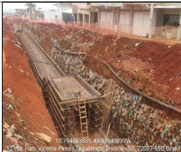
Forma e Ferragens - Galeria 2,00m x 2,00m
