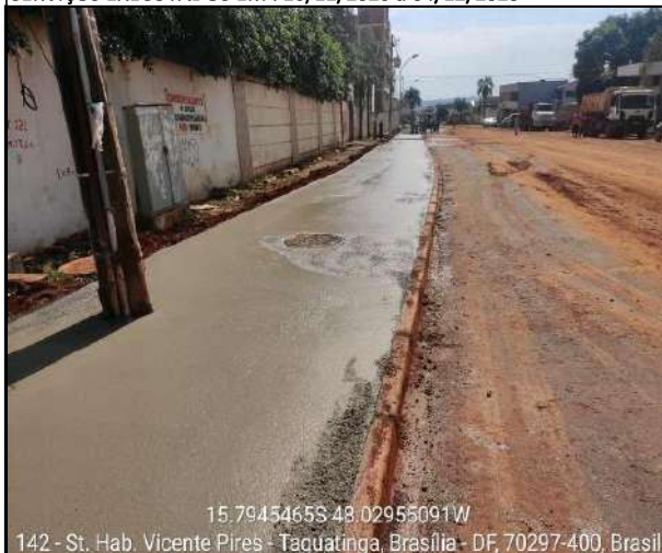
Concretagem - Calçada Rua 12 (Estaca 0+00 a 12+00)
