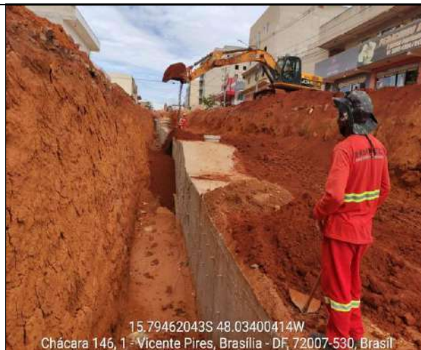
Reaterro - Galeria 2,00m x 2,00m
