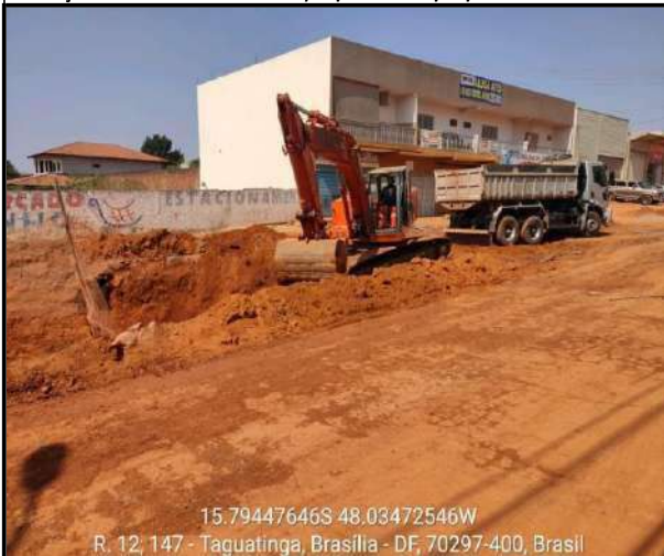
Escavação e Transporte Bota Espera - Galeria 2,00m x 2,00m
