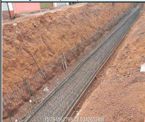
Ferragens - Galeria 2,00m x 2,00m entre PV 150-PV 143
