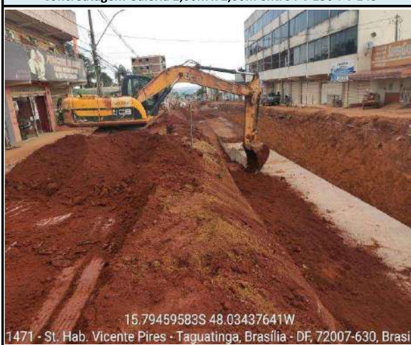
Reaterro Galeria 2,00m x 2,00m entre PV 150-PV 143
