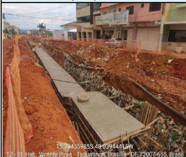
Concretação Galeria 2,00m x 2,00m entre PV 150-PV 143
