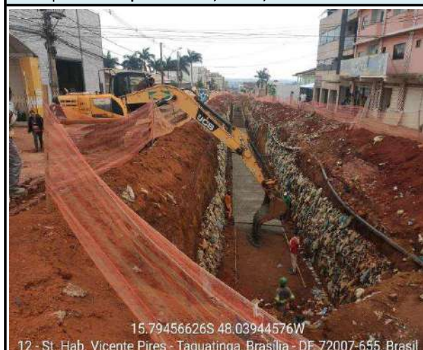
Concretagem do Fundo - Galeria 2,00m x 2,00m entre PV 150-PV 143
