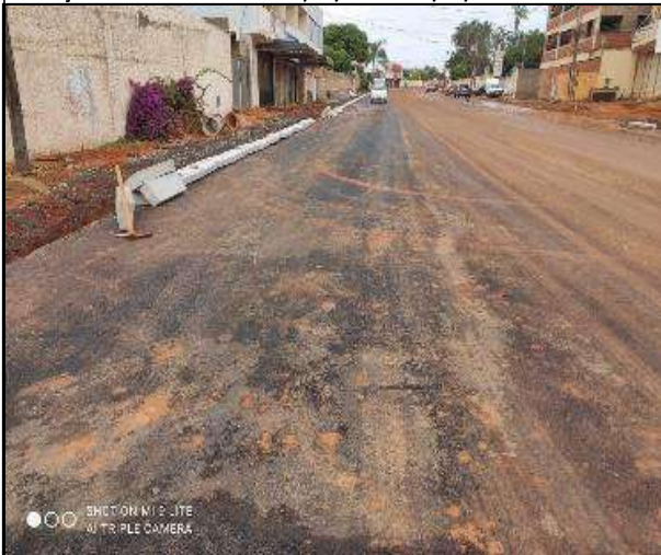
Meio-Fio na Rua 12 (Estaca 0+00 a 12+00)
