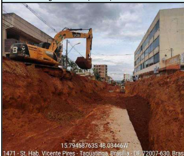
Reaterro Galeria 2,00m x 2,00m entre PV 150-PV 143
