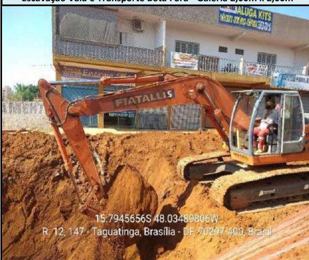
Escavação Vala e Transporte Bota Fora - Galeria 2,00m x 2,00m
