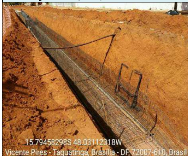
Forma e Ferragens - Galeria 2,00m x 2,00m entre PV 150-PV 143
