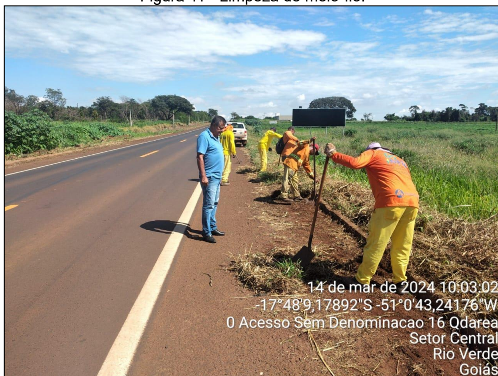
Figura 11 - Limpeza de meio-fio.
