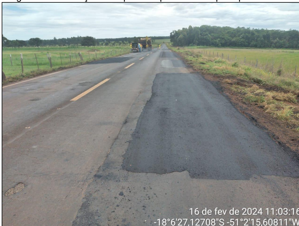
Figura 14 - Execução de reparos superficiais em pista pavimentada.
