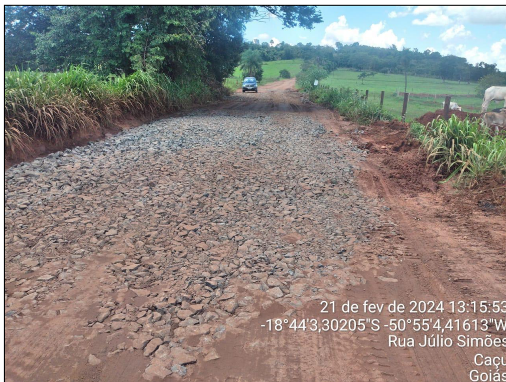
Figura 19 - Exemplo de execução de revestimento primário em vias não pavimentadas.
