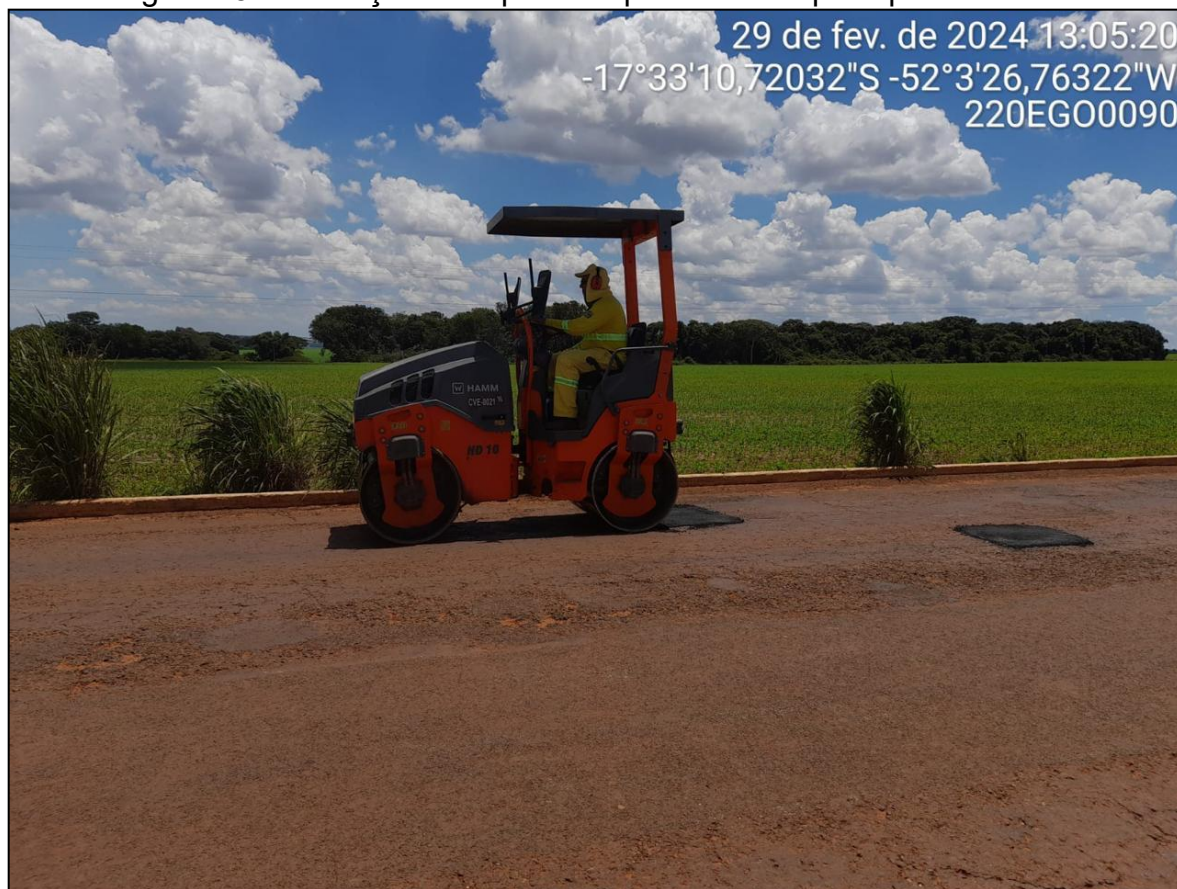
Figura 15 - Execução de reparos superficiais em pista pavimentada.
