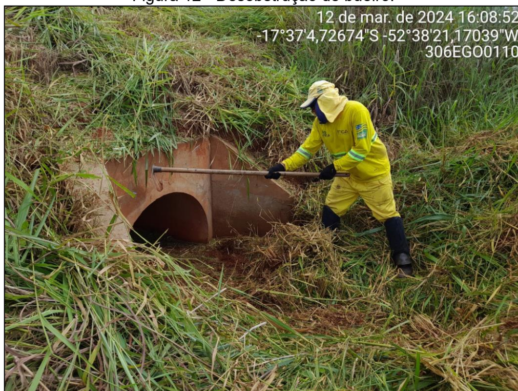
Figura 12 - Desobstrução de bueiro.
