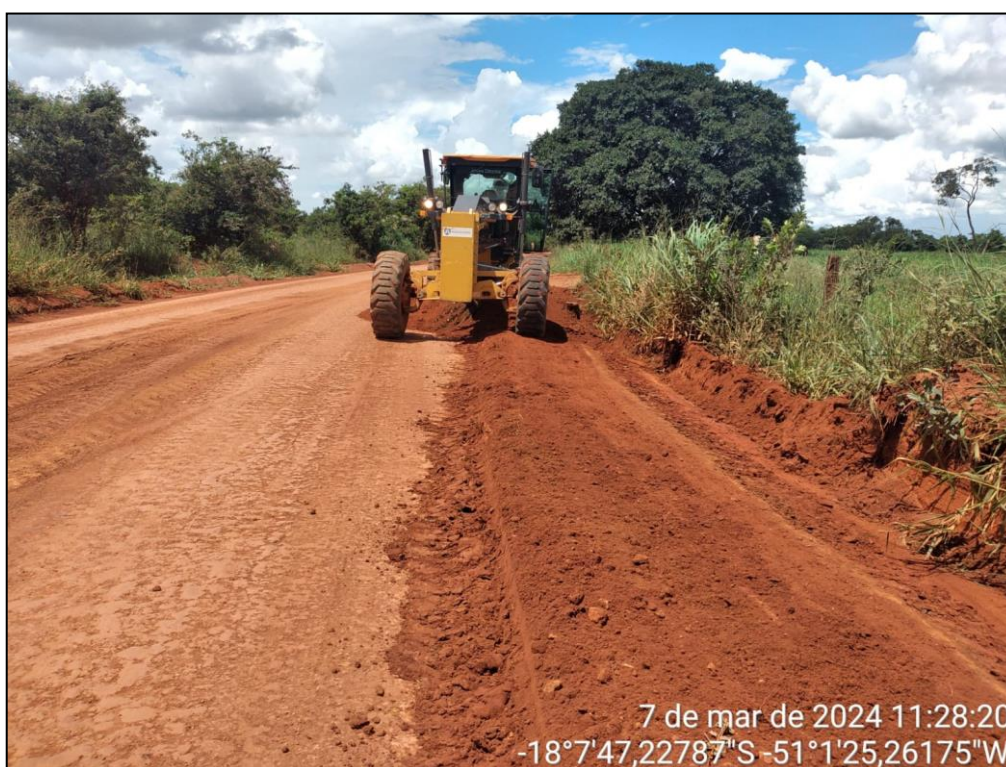
Figura 18 - Execução de vala não revestida em via não pavimentada.
