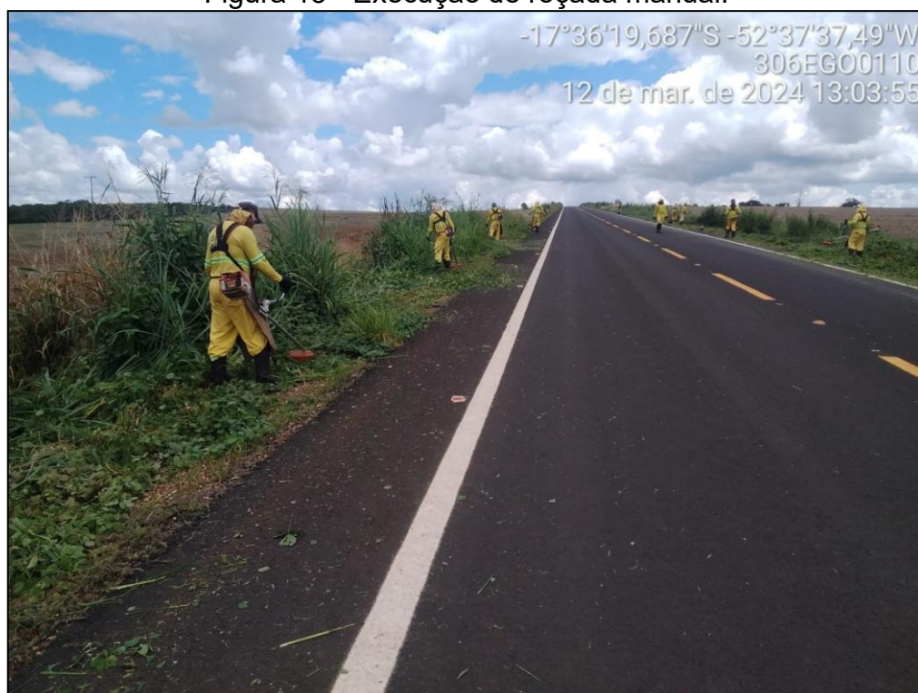
Figura 13 - Execução de roçada manual.
