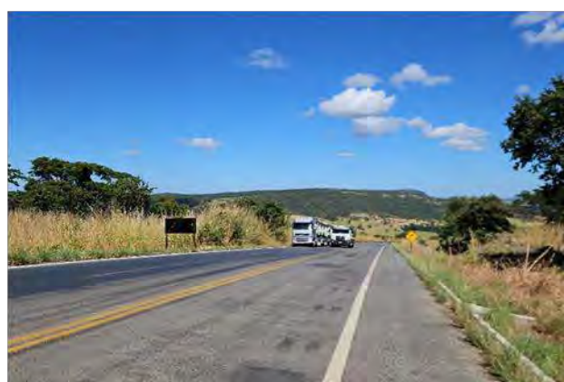
Figura 35 - Curva acentuada desprovida de Defesa Metálica
