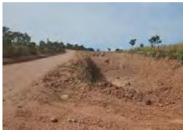
Figura 23 - Caixa Explorada sem Tratamento Adequado
