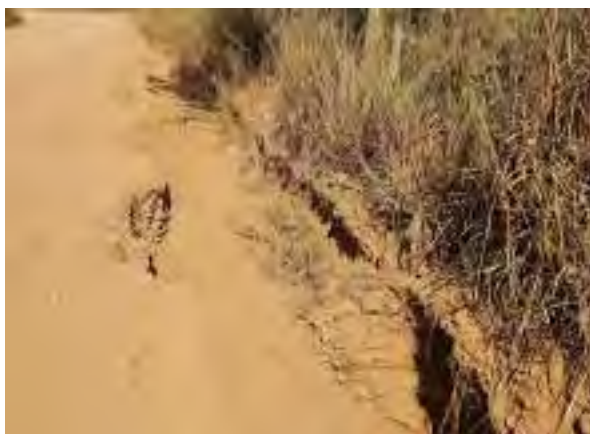
Figura 22 - Erosões na Rodovia GO-108
