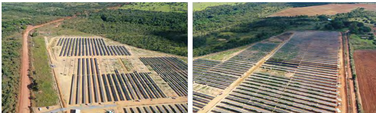
Figura 32 - Usina Solar GO-116 Fonte: Acervo do CONSÓRCIO.
