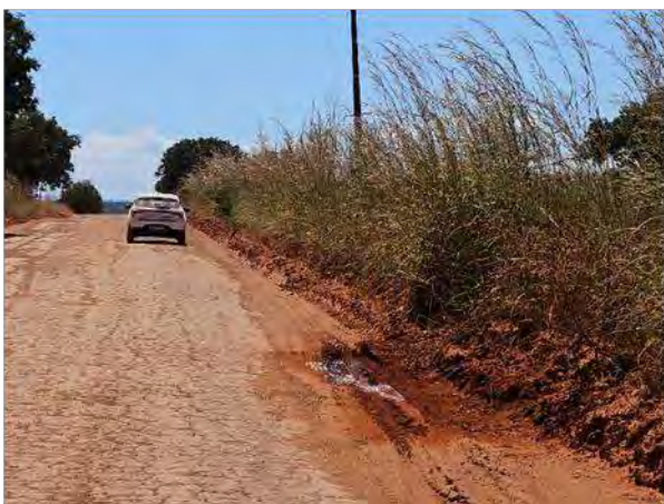
Figura 28 - Exemplos de Erosões no Trecho GO-116
