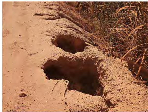
Figura 28 - Exemplos de Erosões no Trecho GO-116
