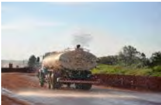
Figura 40 - Aspersão de água para controle de Poeira
