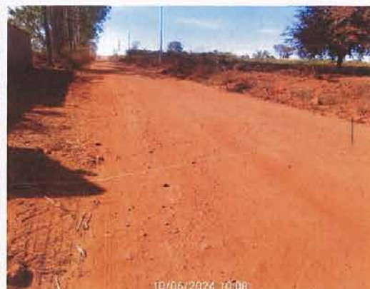
Figura 46 - Vista Geral da GO-466
