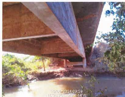
Figura 48 - Vista Inferior da Ponte sobre o Rio João Leite
