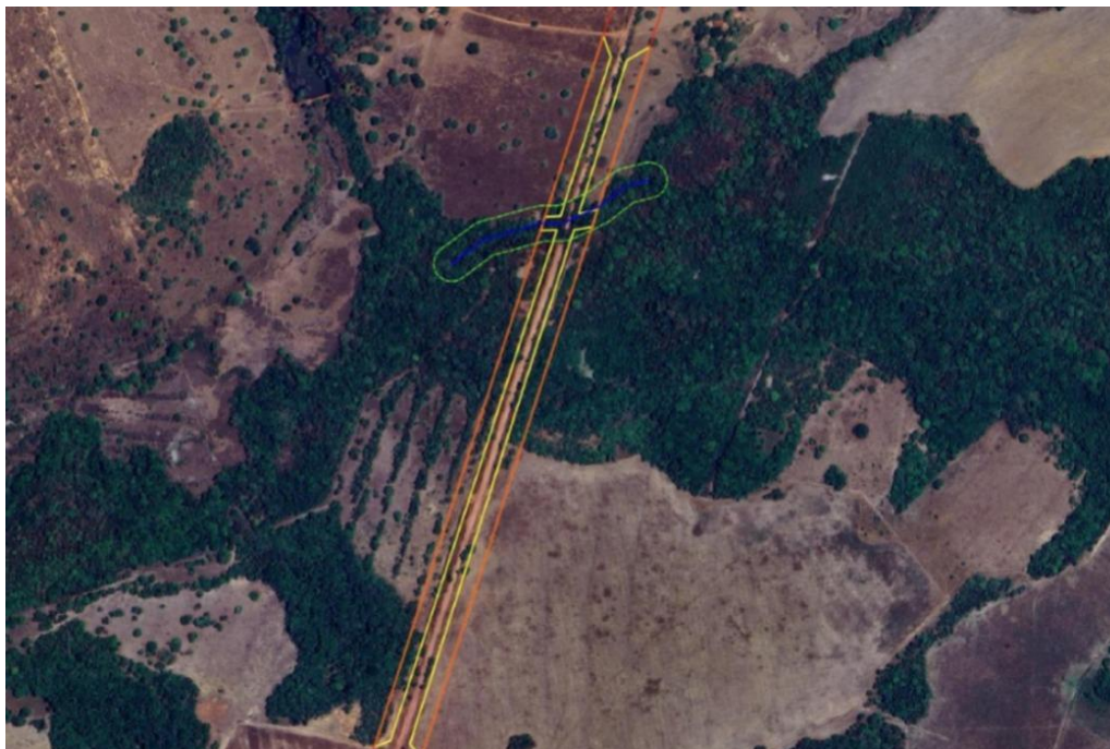
Figura 8. Proteção da vegetação na faixa de domínio para o interligação do corredor ecológico natural à passagem de fauna. Fonte: Elaborada pela equipe da Gerência Ambiental da GOINFRA.
