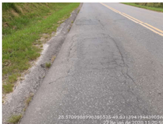
Figura 12 - Deformações localizadas
