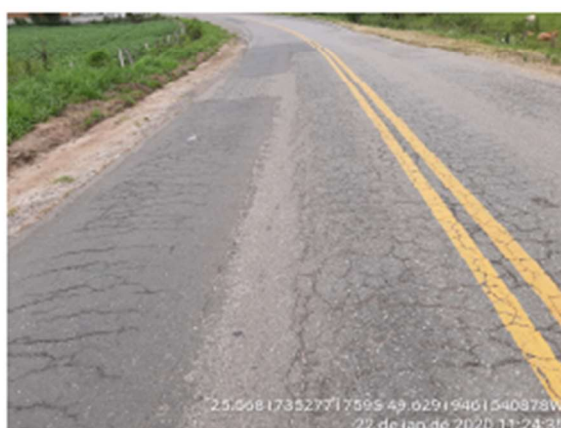
Figura 14 - Deformações permanentes em trilhas de roda
