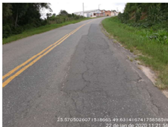
Figura 20 - Remendos na pista
