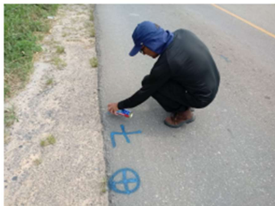
Figura 3 - Estaqueamento do trecho
