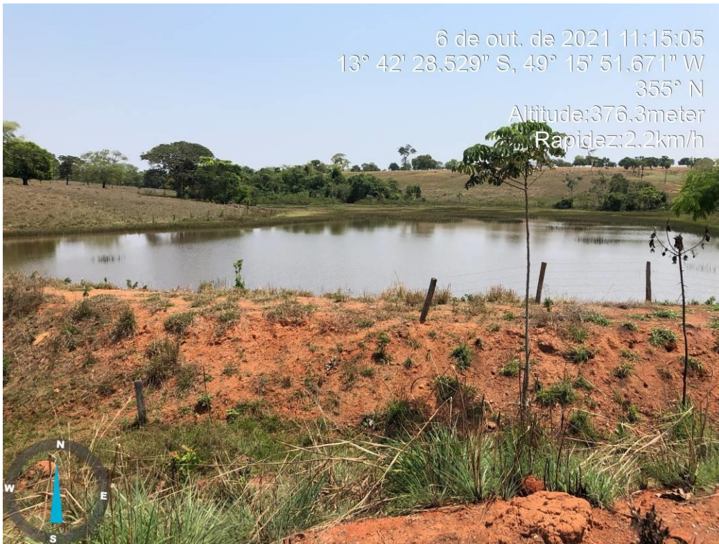
Figura 9: Barramento com parte de sua extensão na faixa de domínio.
