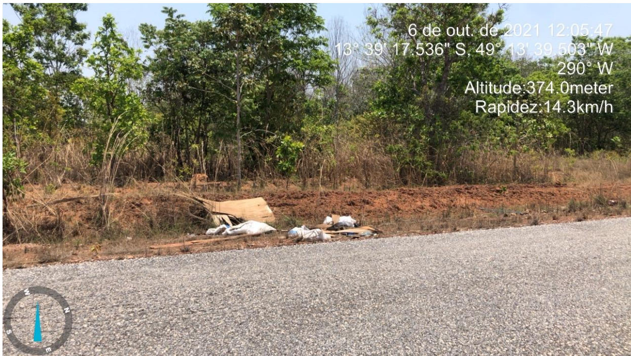
Figura 14: Ponto de disposição irregular de pequena quantidade de resíduos sólidos.
