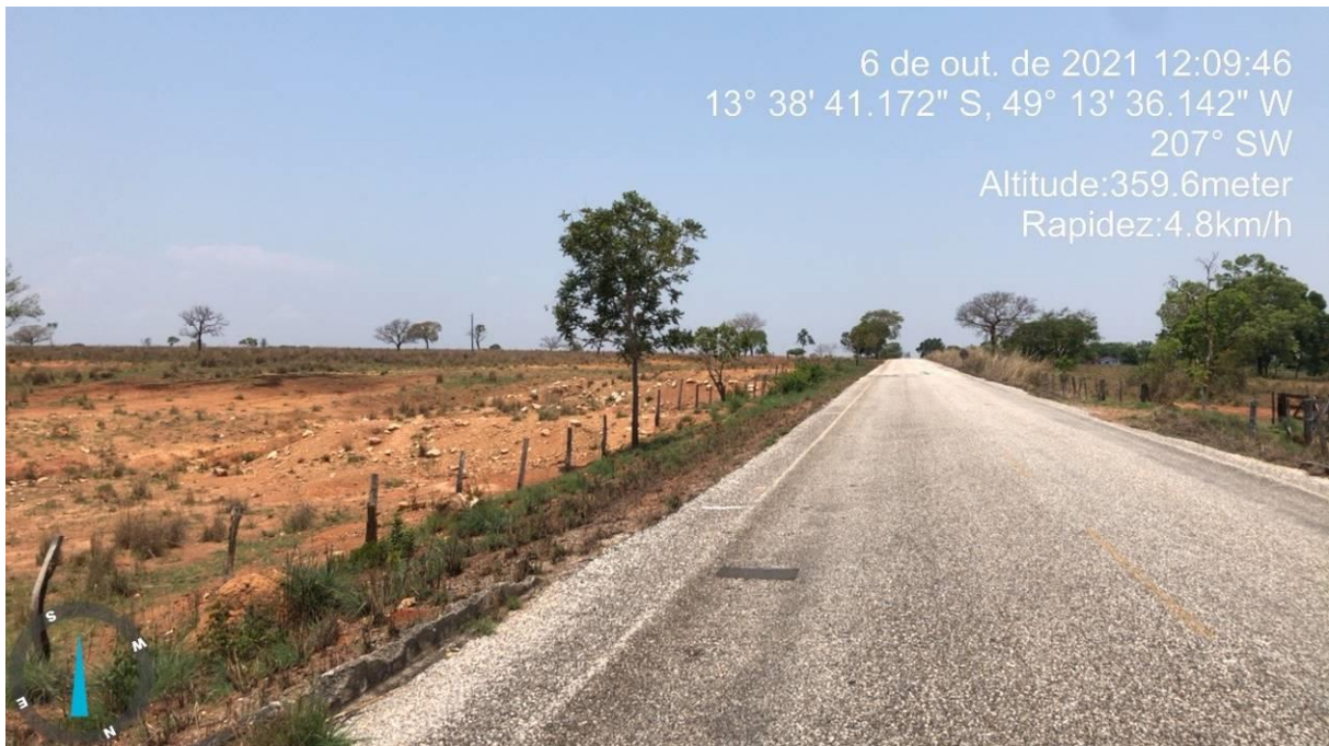
Figura 16: Antiga área de empréstimo de material.
