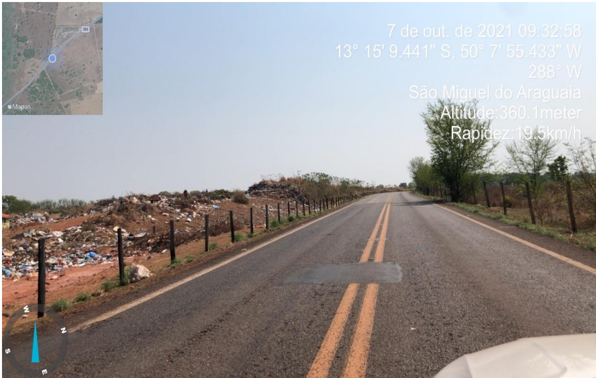
Figura 34: Aterro de resíduos de São Miguel do Araguaia.
