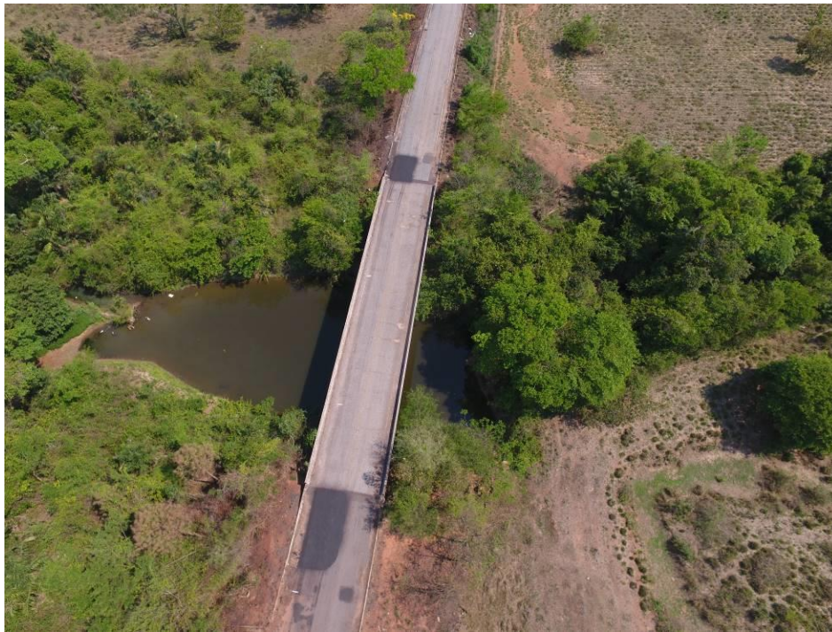
Figura 22: Ponte sobre o Ribeirão do Meio.
