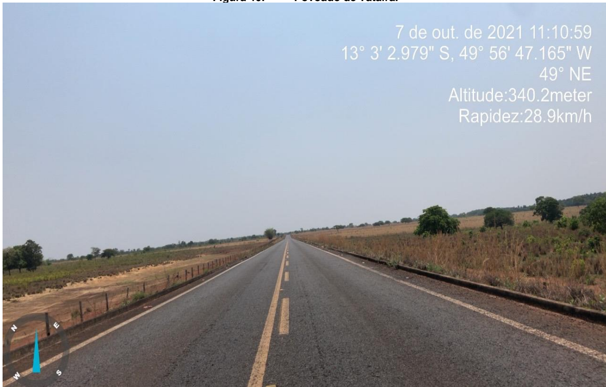
Figura 47: Neste trecho é possível notar a falta de cobertura vegetal que ocorre na maioria da área de influência.
