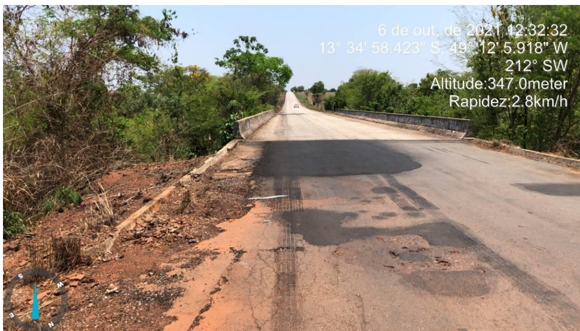
Figura 20: Ponte sobre o Ribeirão do Meio.
