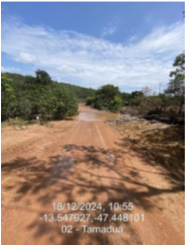
Ponto 2 – Ponte de madeira
