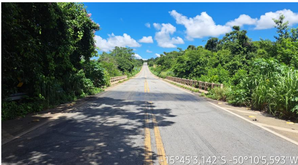
Km: 27,30 – Ponte em Concreto Armado.
