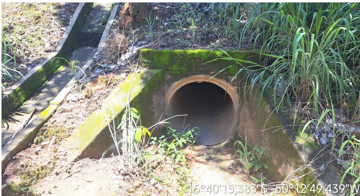
Km: 37,70 – Bueiro tubular.
