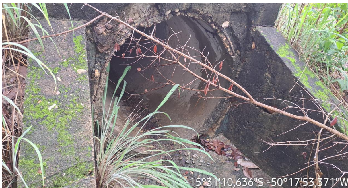
Km: 57,30 – Bueiro tubular.
