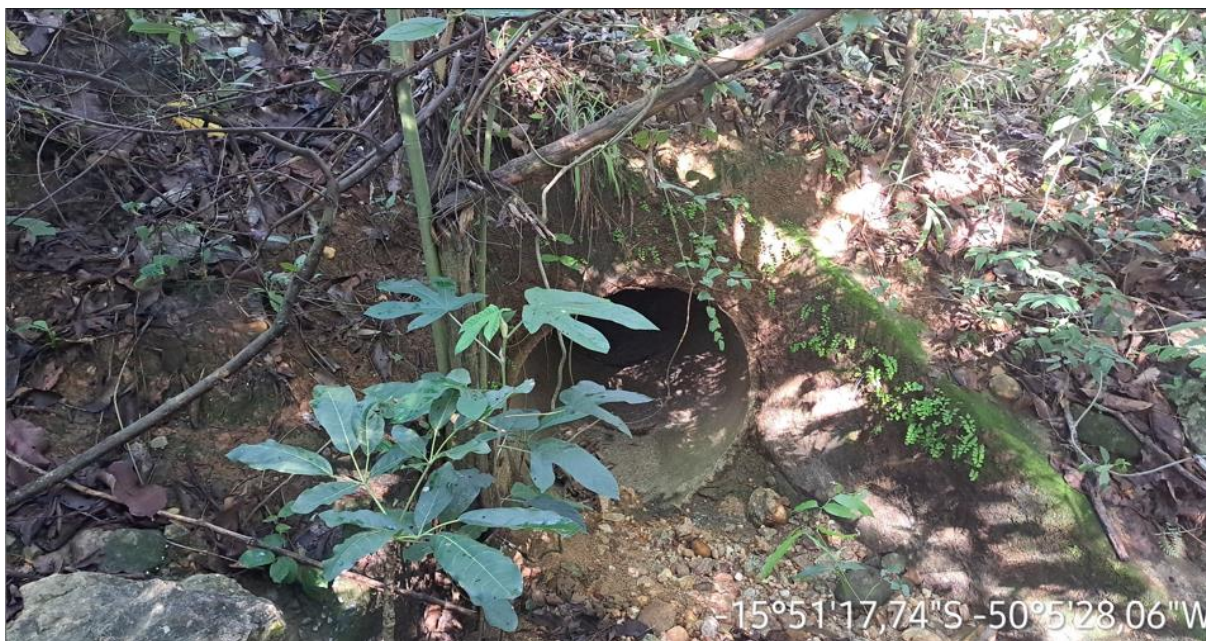
Km: 12,30 – Bueiro tubular.
