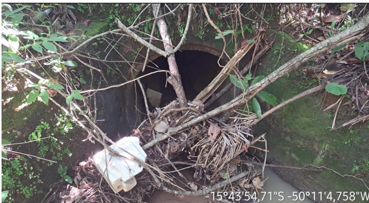
Km: 30,20 - Bueiro tubular.
