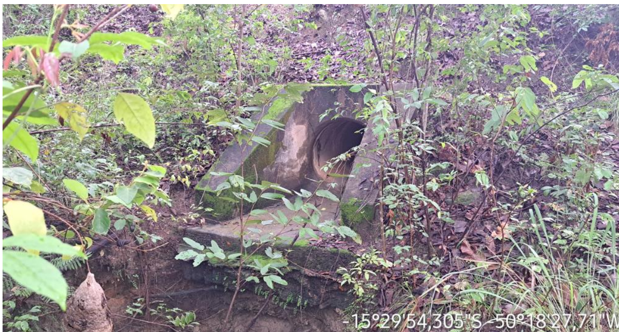
Km: 59,90 – Bueiro tubular.
