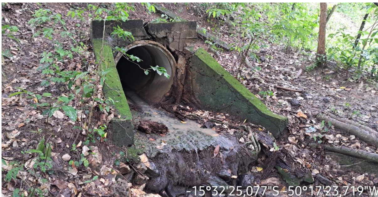
Km: 54,80 – Bueiro tubular.
