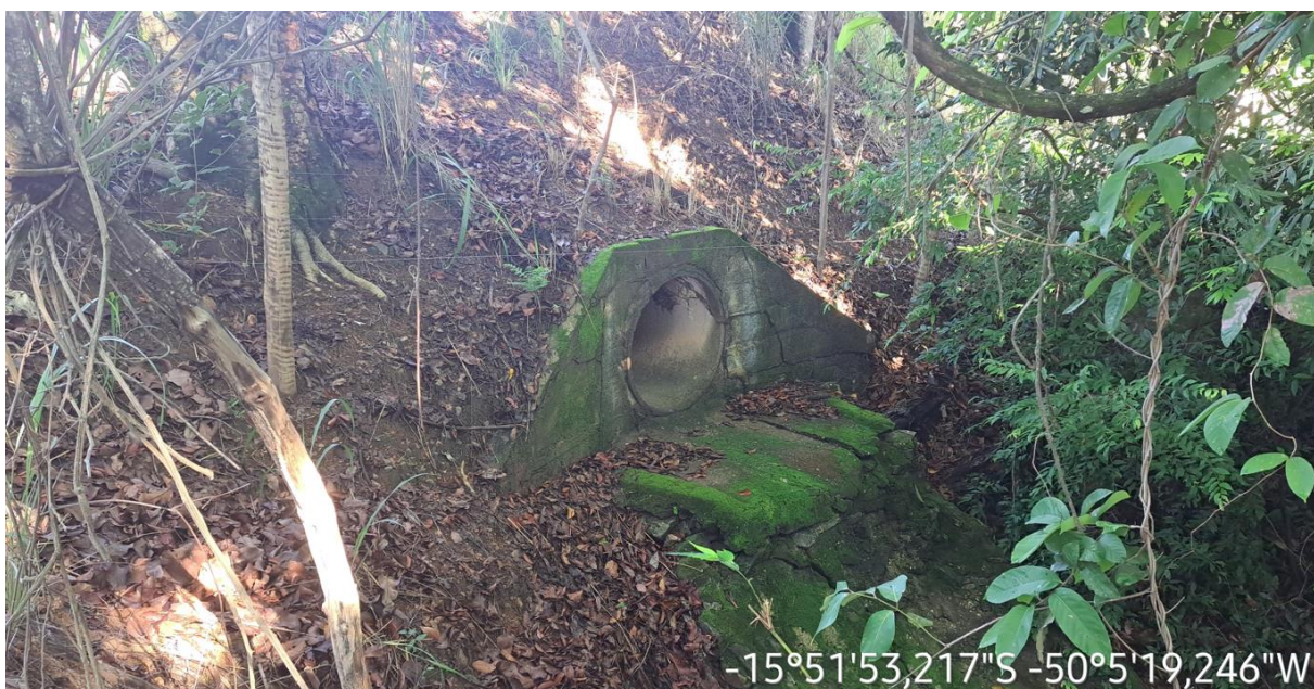
Km: 11,20 – Bueiro tubular.
