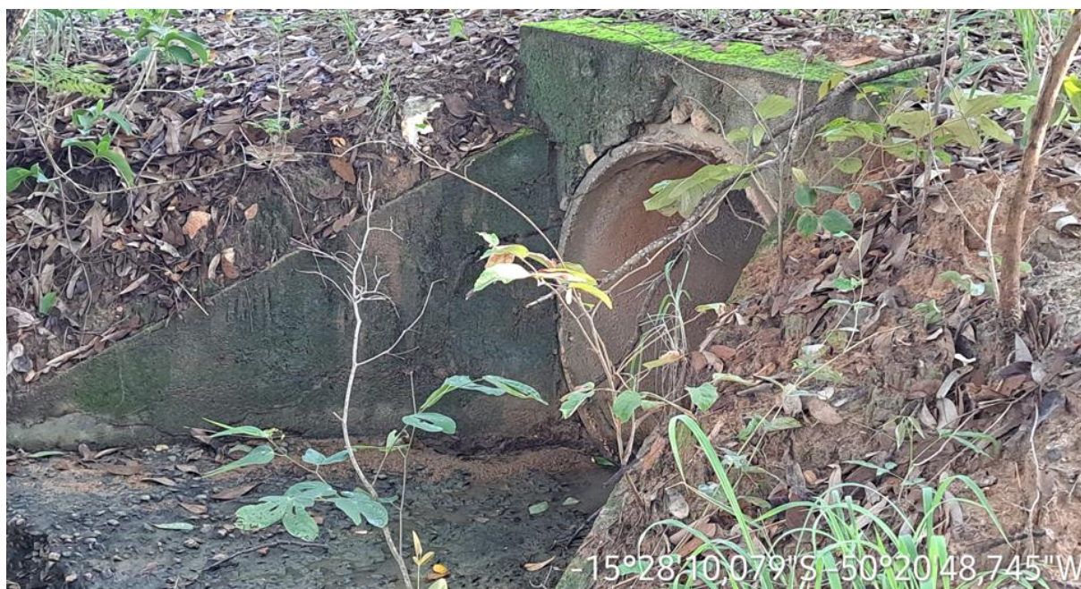
Km: 65,30 – Bueiro tubular.
