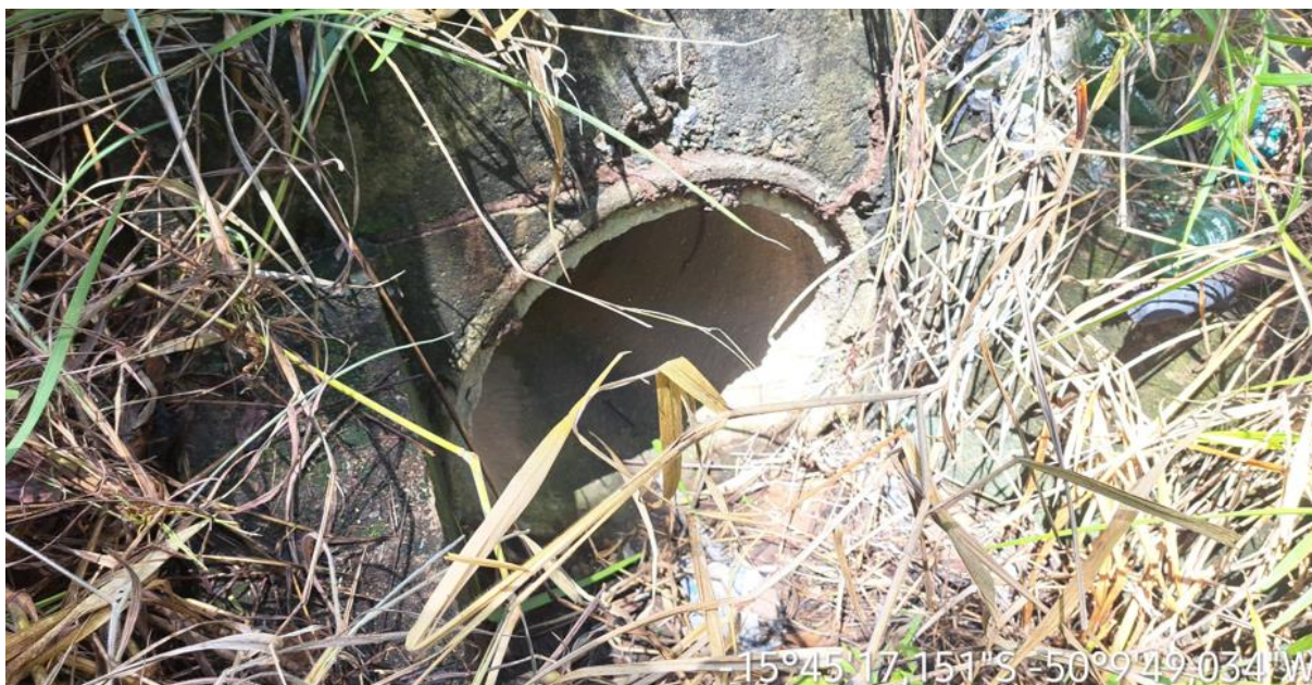
Km: 26,70 – Bueiro tubular.
