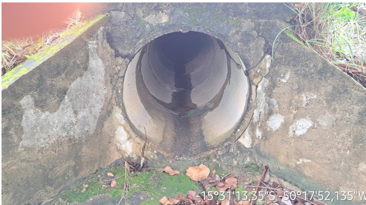
Km: 57,20 – Bueiro tubular.
