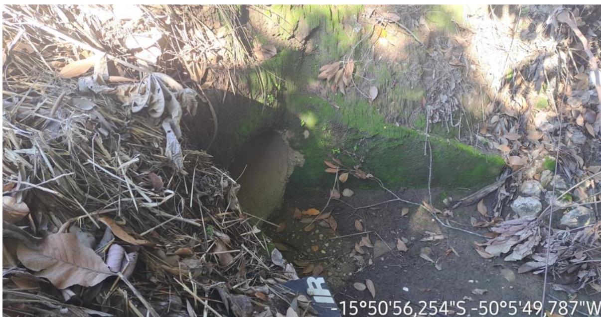
Km: 13,30 – Bueiro tubular.
