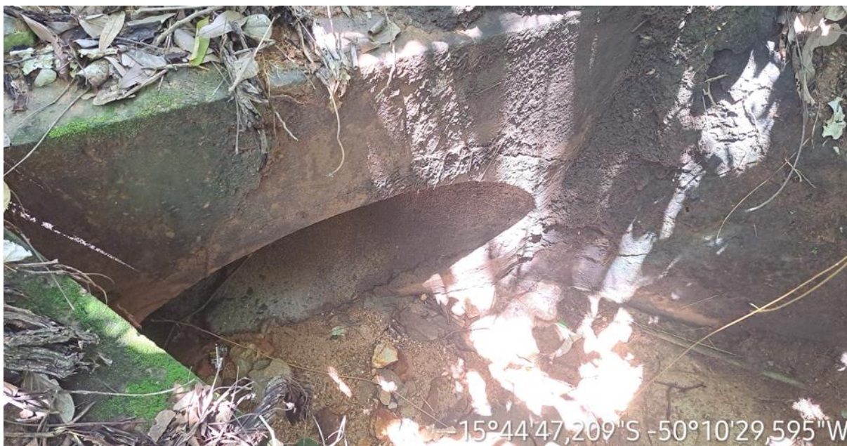
Km: 28,20 – Bueiro tubular.
