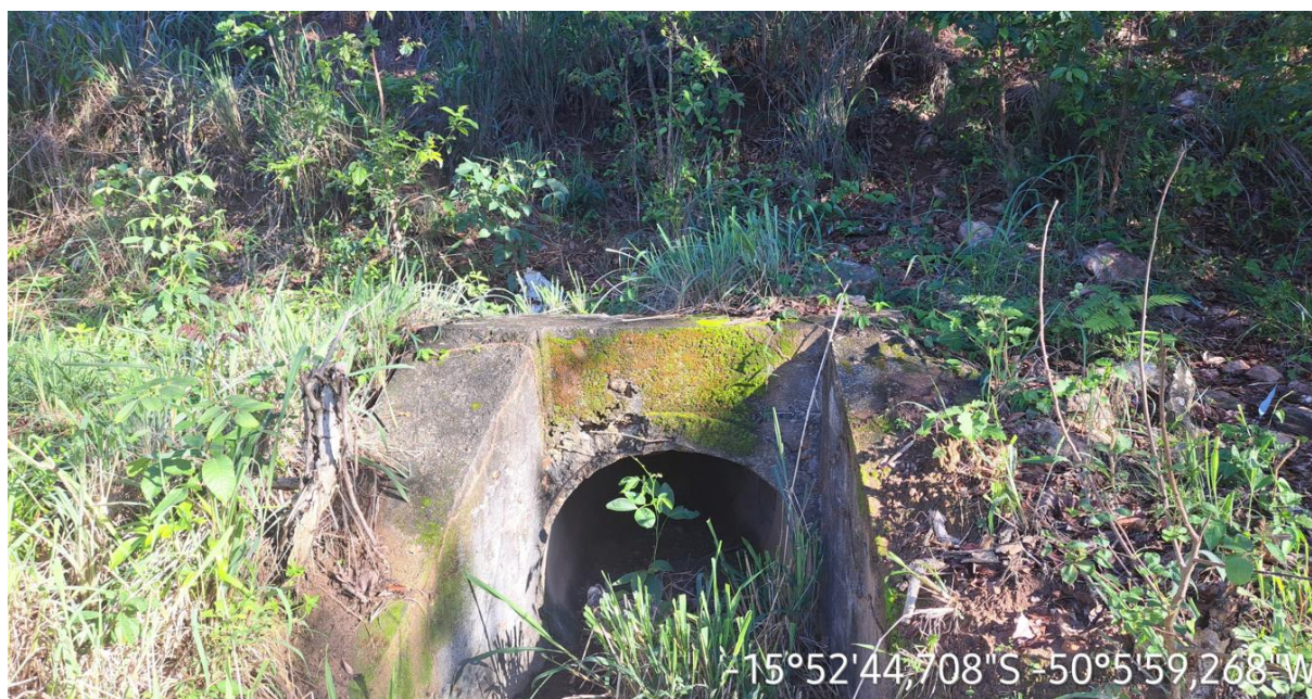
Km: 9,10 – Bueiro Tubular.
