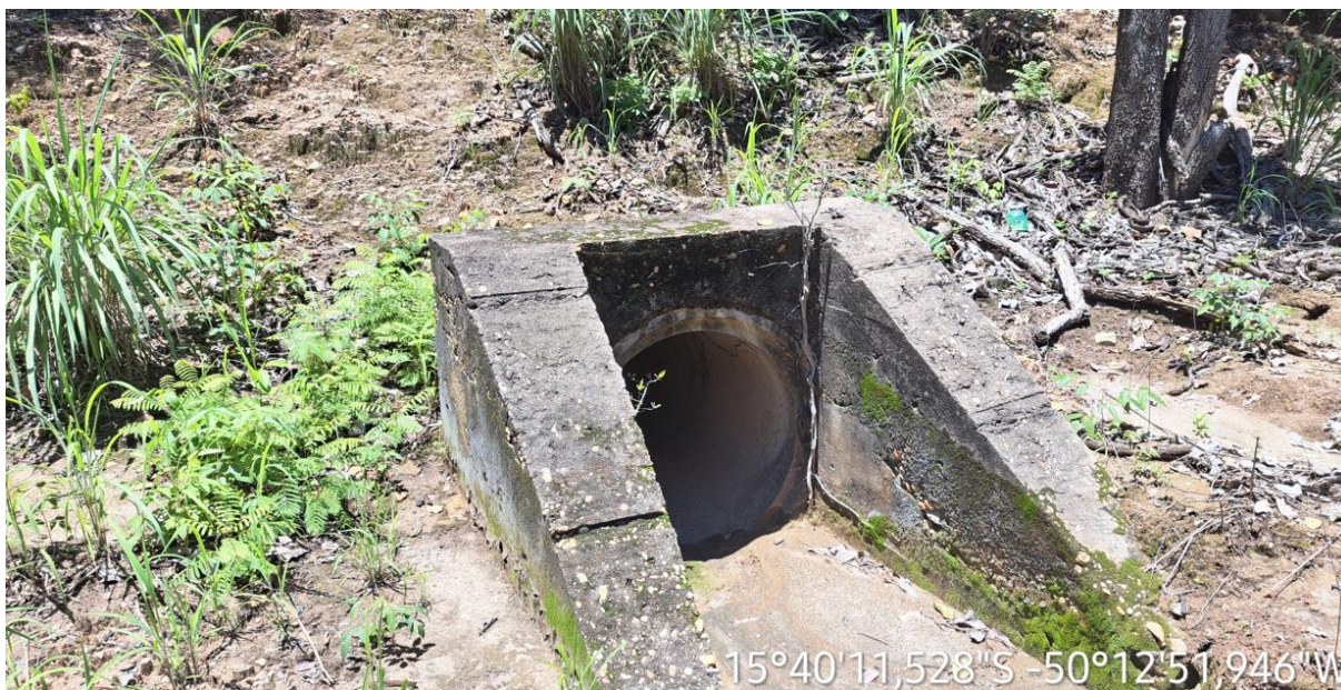
Km: 37,90 – Bueiro tubular.
