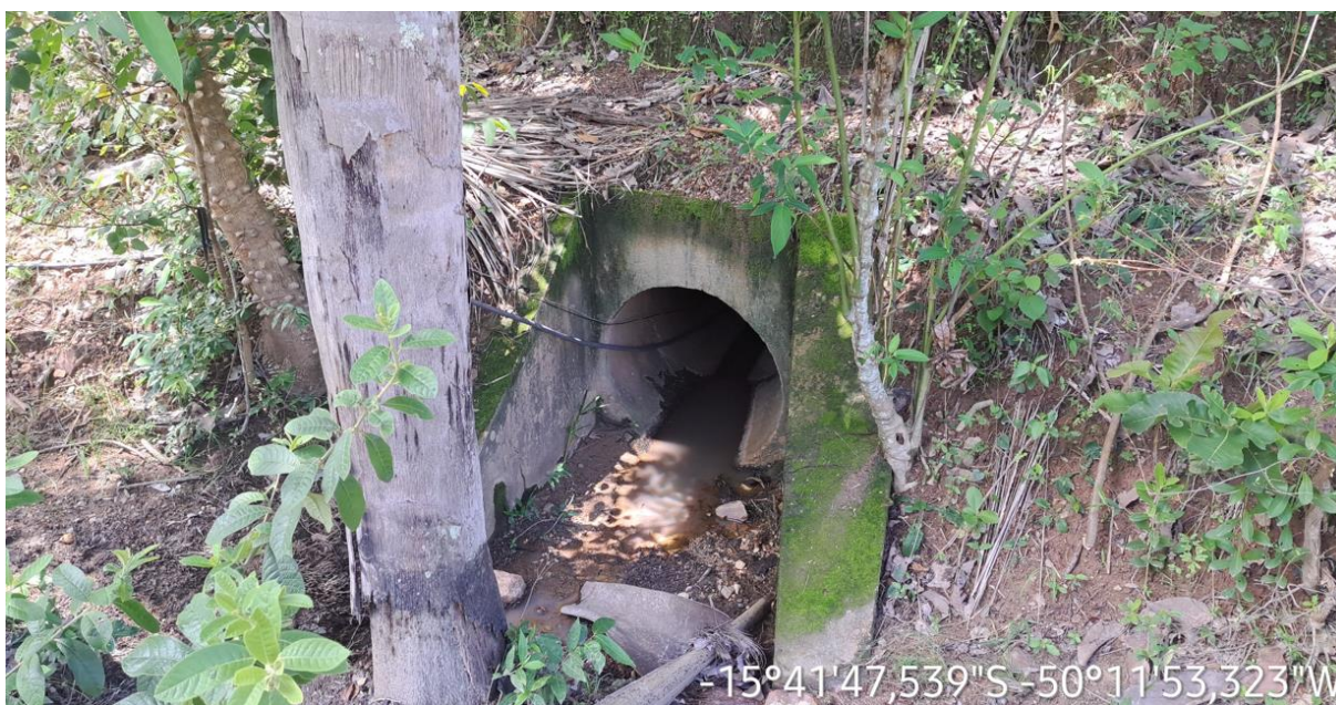
Km: 34,40 – Bueiro tubular.
