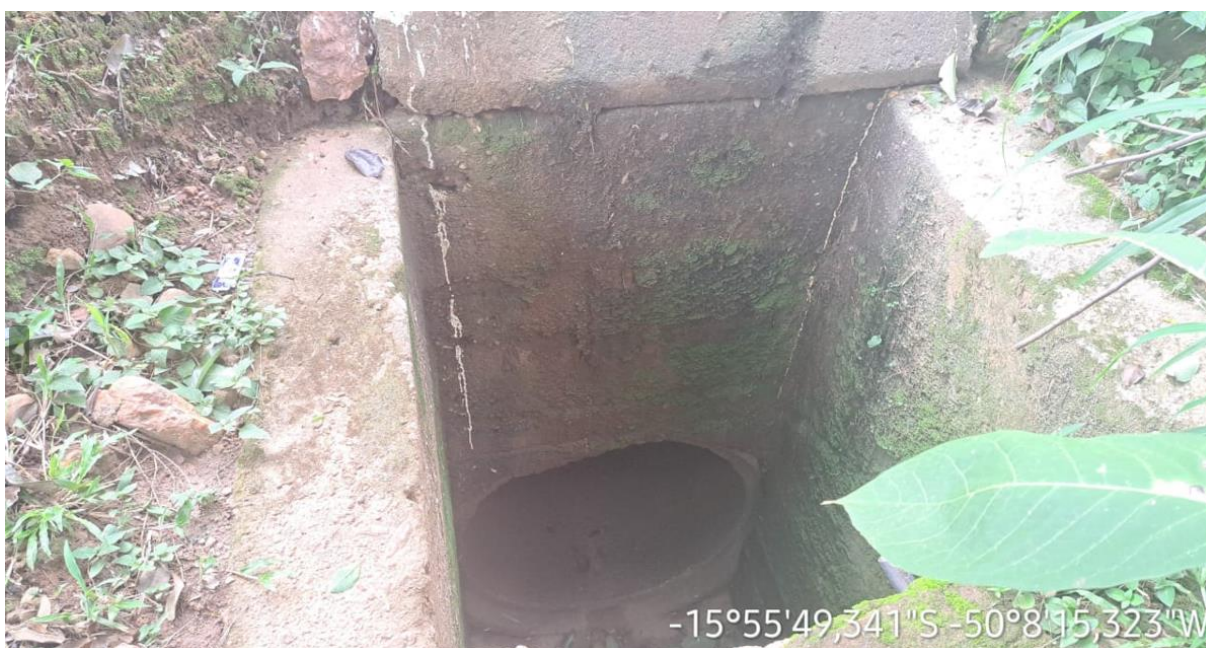
Km:1,40 – Bueiro tubular.
