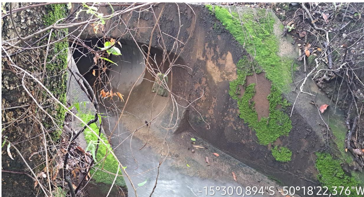
Km: 59,60 - Bueiro tubular.
