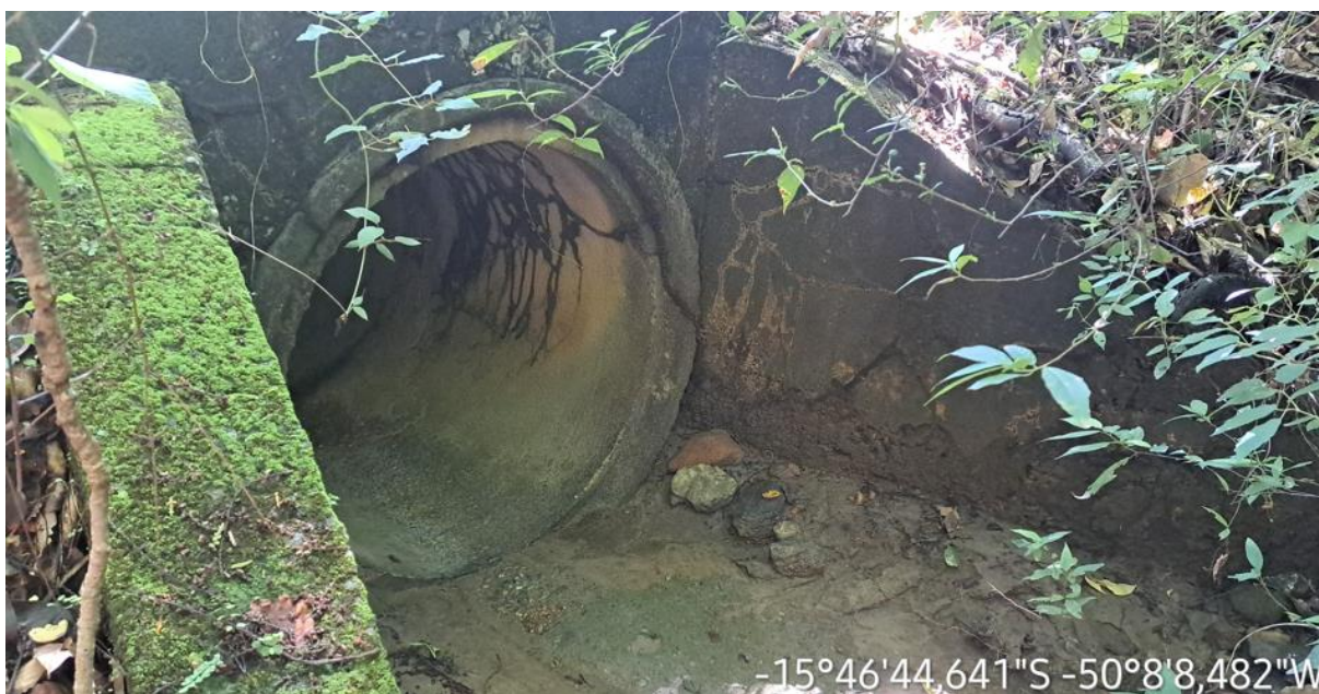
Km: 22,60 - Bueiro tubular.
