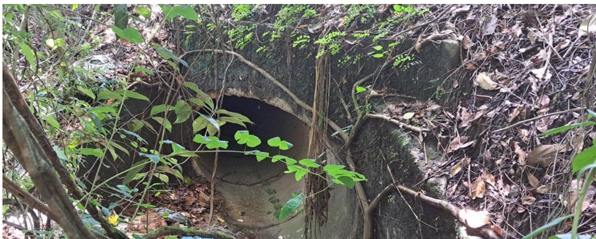
Km: 31,80 – Bueiro tubular.
