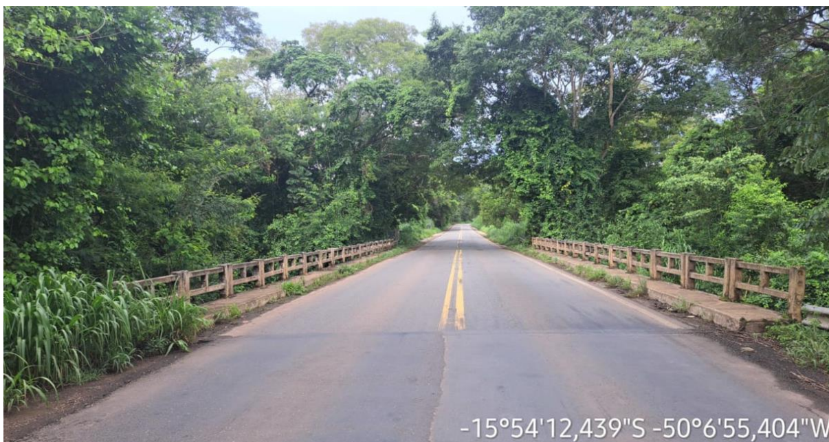
Km: 5,60 – Ponte em Concreto Armado – 34 x 10m.
