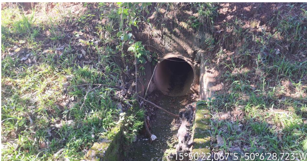
Km: 14,90 – Bueiro tubular.
