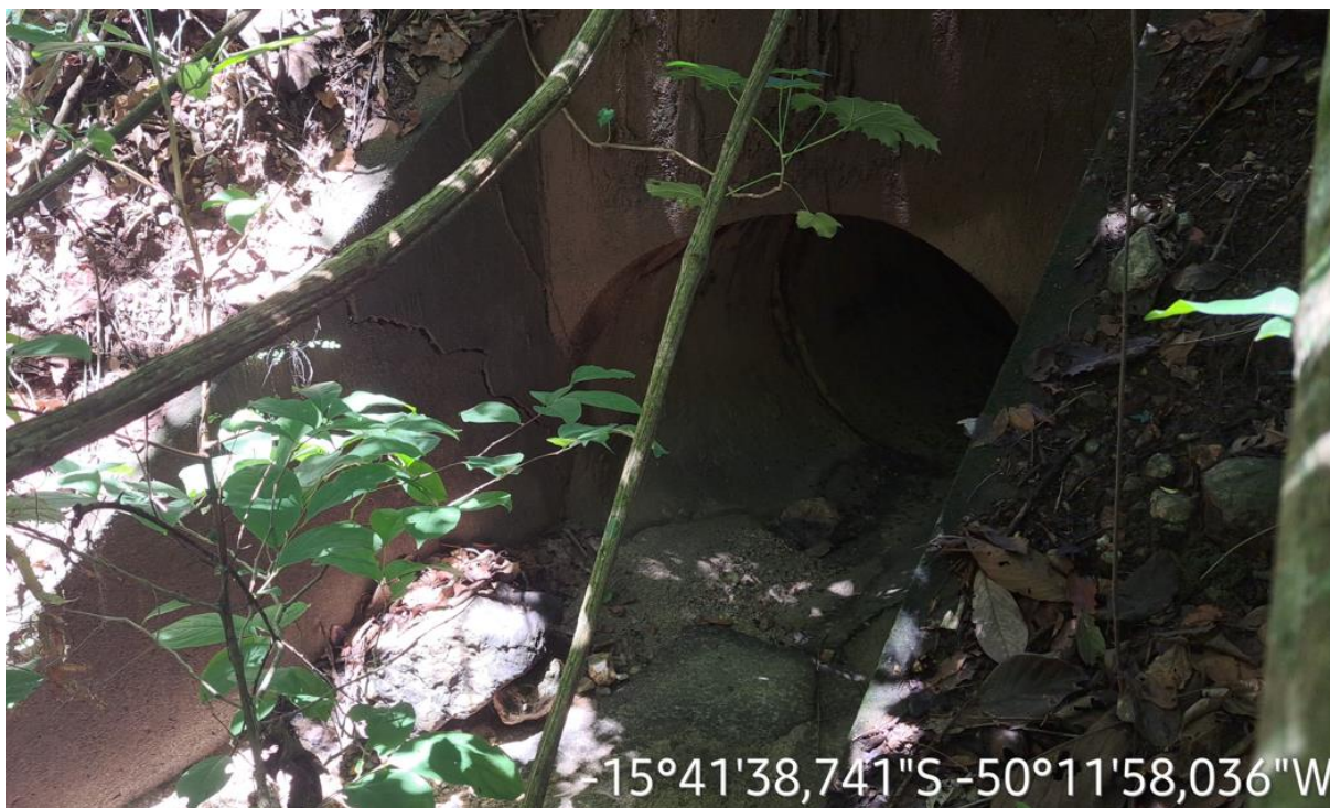
Km: 34,70 – Bueiro tubular.
