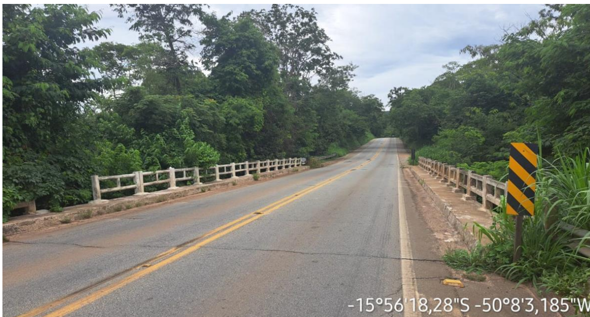
Km: 0,40 – Ponte em Concreto Armado – 30 x 10m.
