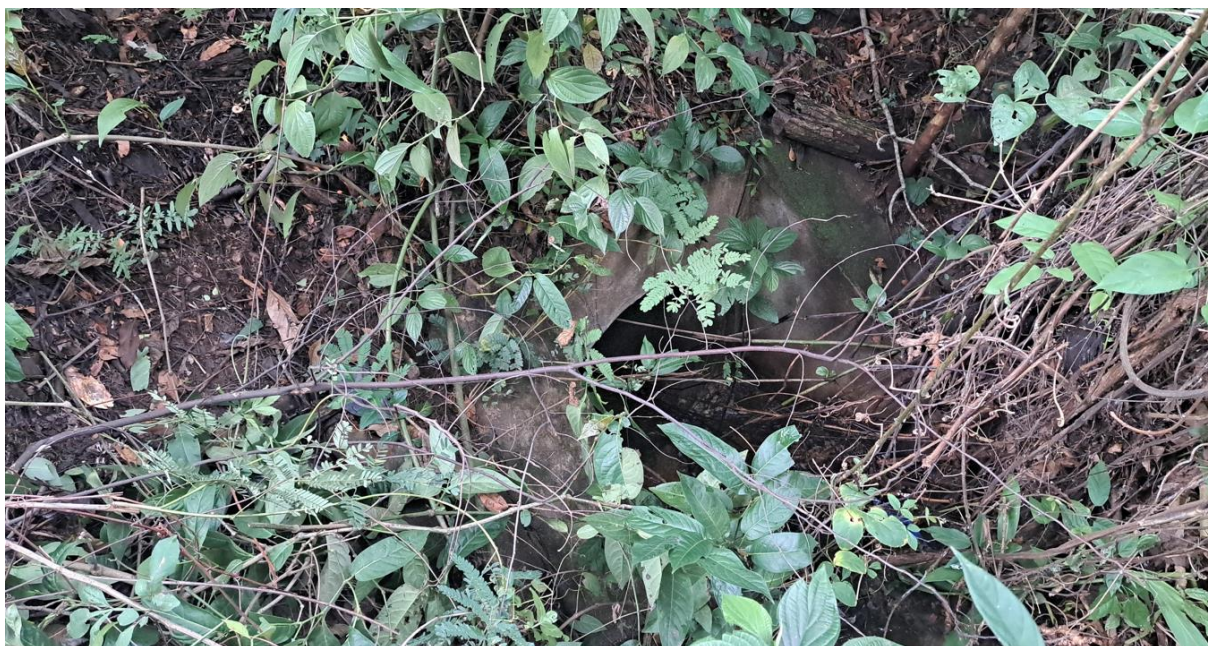
Km: 3,20 – Bueiro Tubular.
