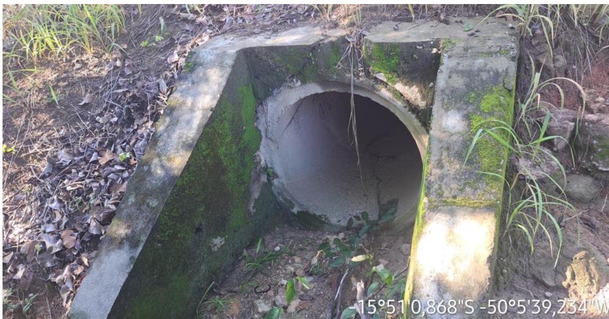
Km: 12,90 – Bueiro tubular.
