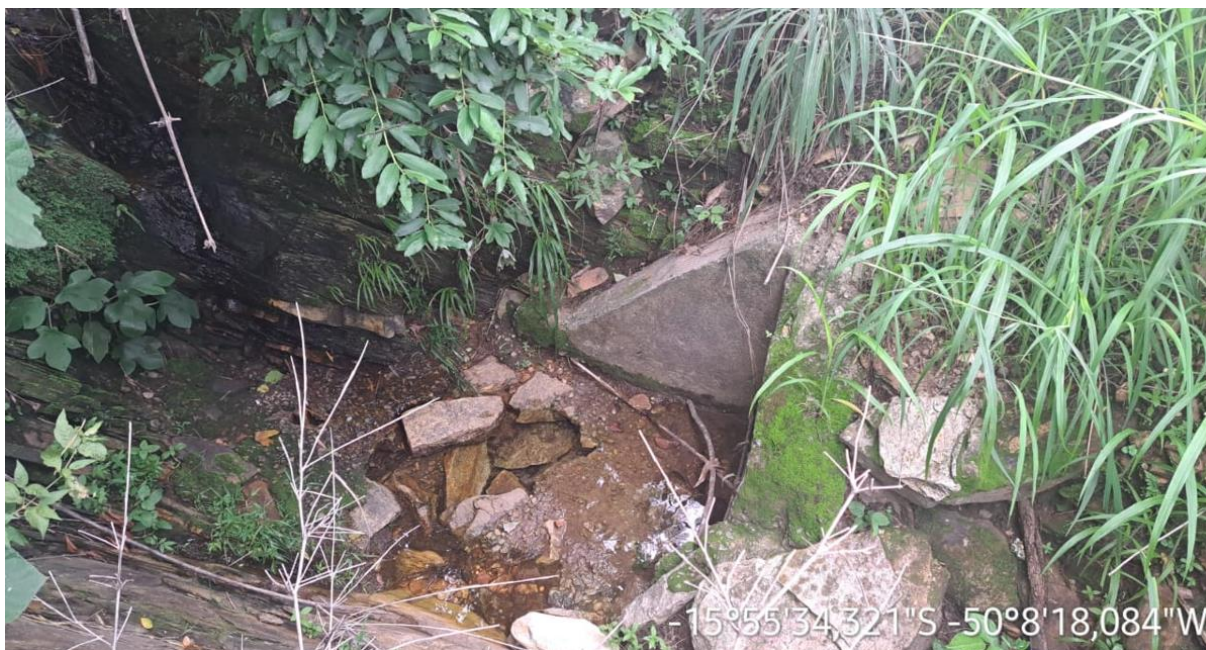
Km: 1,90 – Bueiro tubuar.
