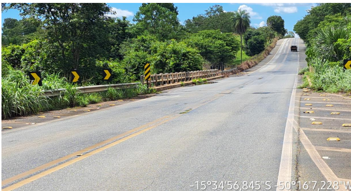
Km: 49,50 – Ponte em Concreto Armado.
