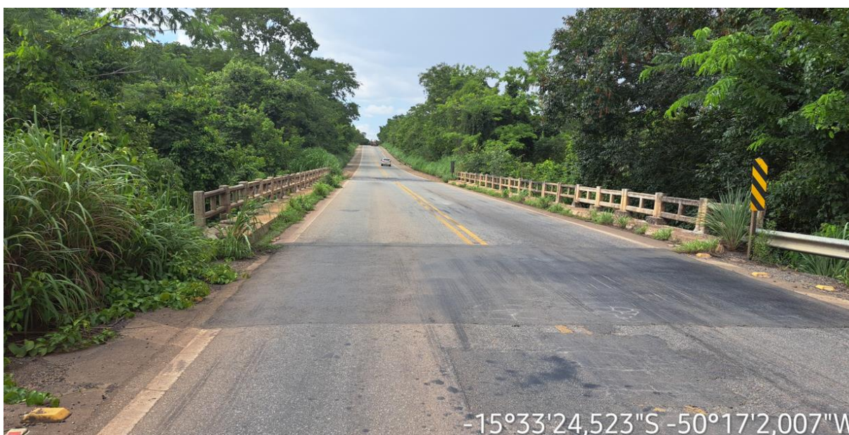
Km: 52,80 – Ponte em Concreto Armado.
