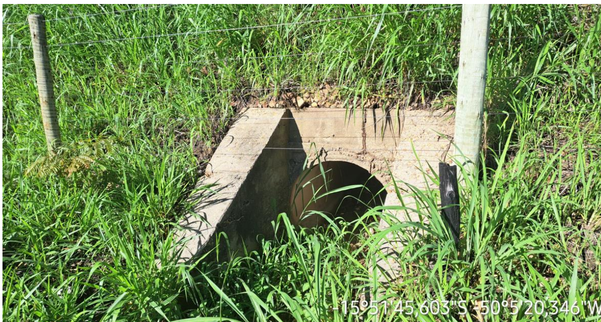
Km: 11,40 – Bueiro tubular.
