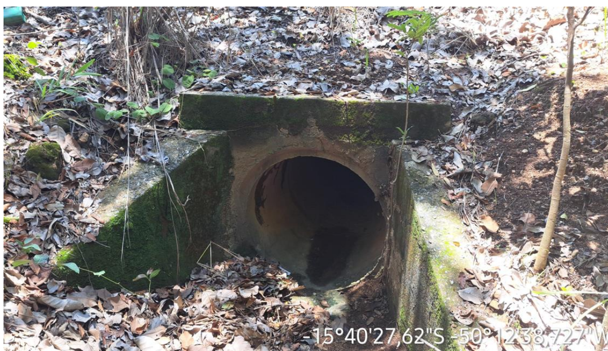
Km: 37,20 – Bueiro tubular.
