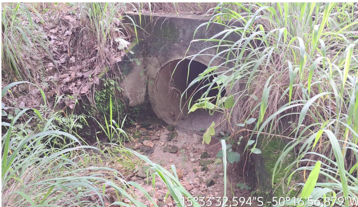
Km: 52,50 - Bueiro tubular.
