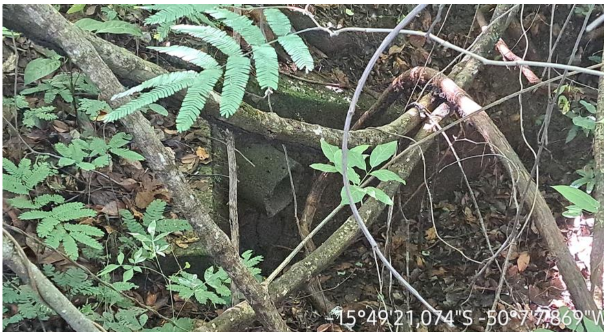
Km: 17,20 – Bueiro tubular.
