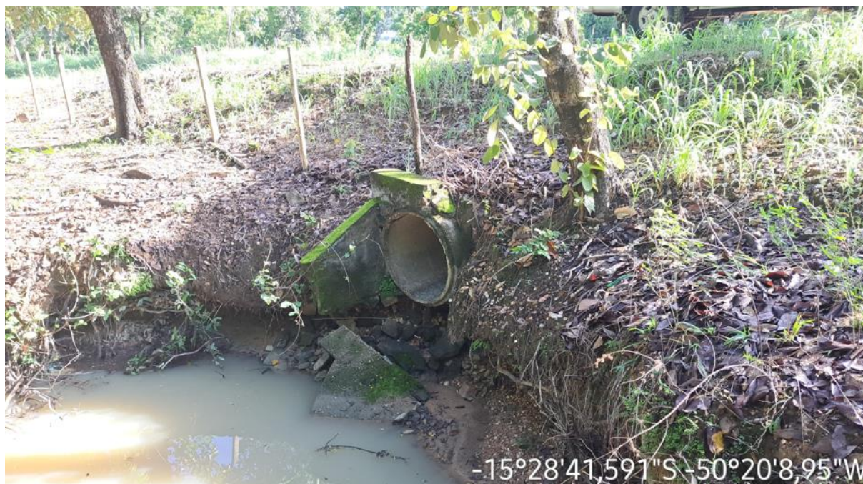
Km: 63,70 - Bueiro tubular.
