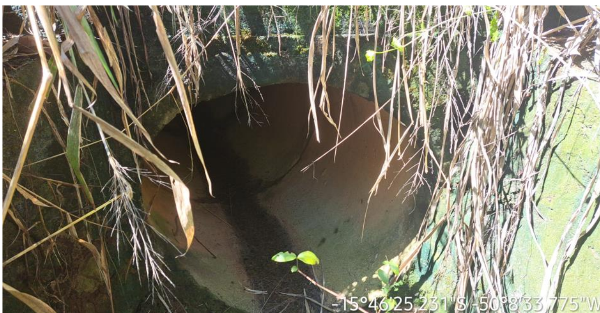
Km: 23,60 – Bueiro tubular.
