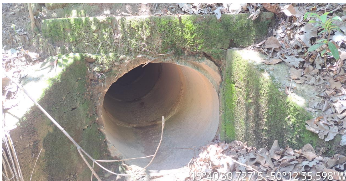
Km: 37,10 – Bueiro tubular.
