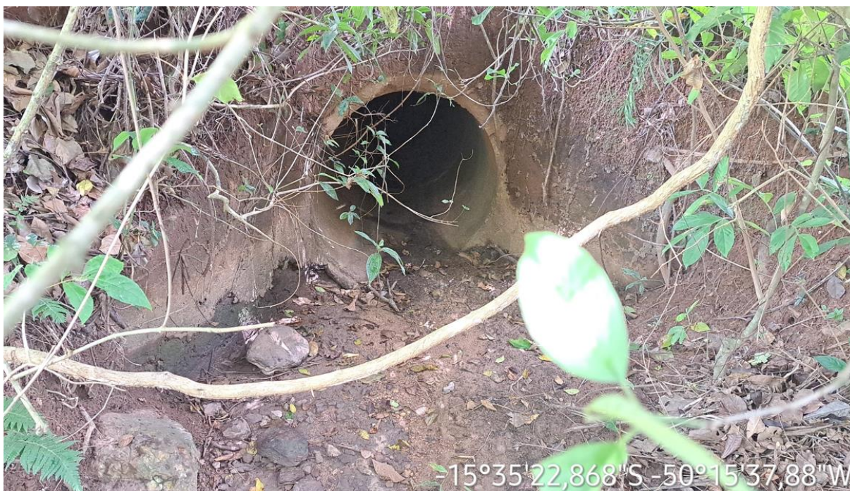
Km: 48,30 - Bueiro tubular.
