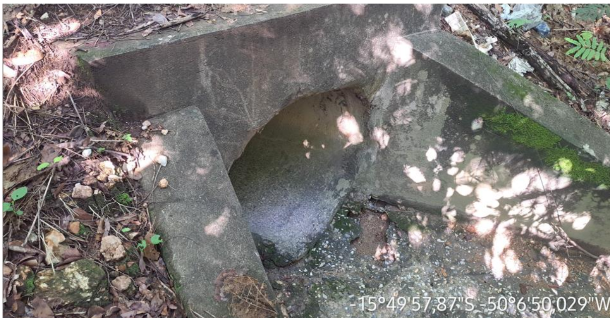
Km: 15,90 – Bueiro tubular.
