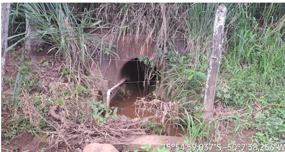
Km: 3,60 – Bueiro Tubular.
