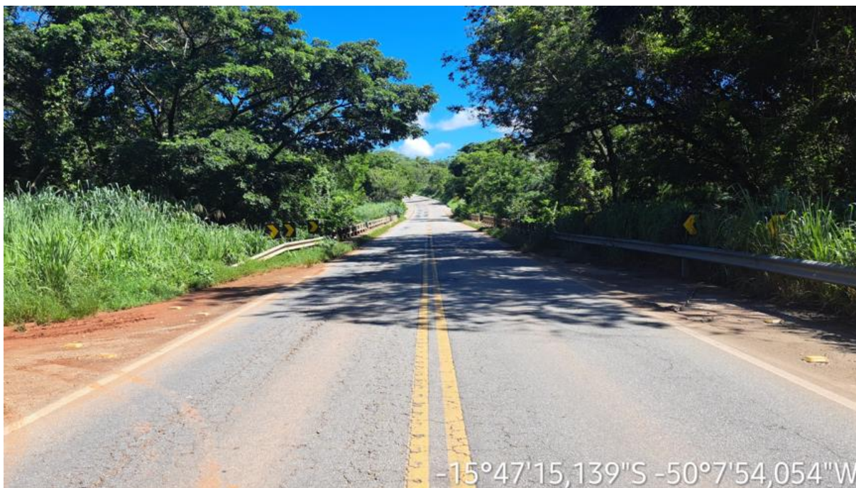
Km: 21,50 - Ponte em Concreto Armado.
