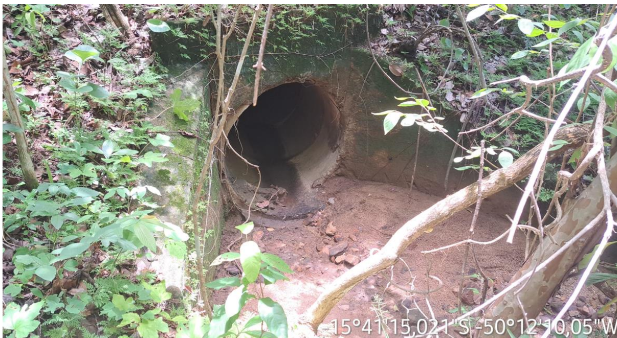
Km: 35,50 – Bueiro tubular.
