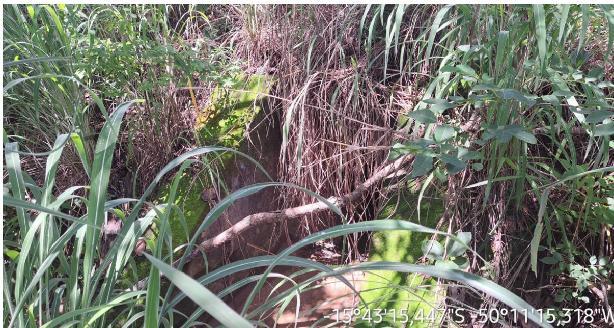
Km: 31,50 – Bueiro tubular.
