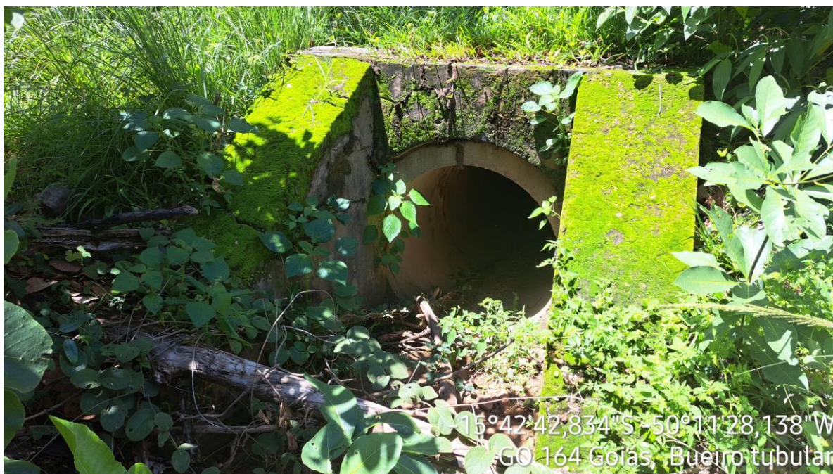
Km: 32,50 – Bueiro tubular.
