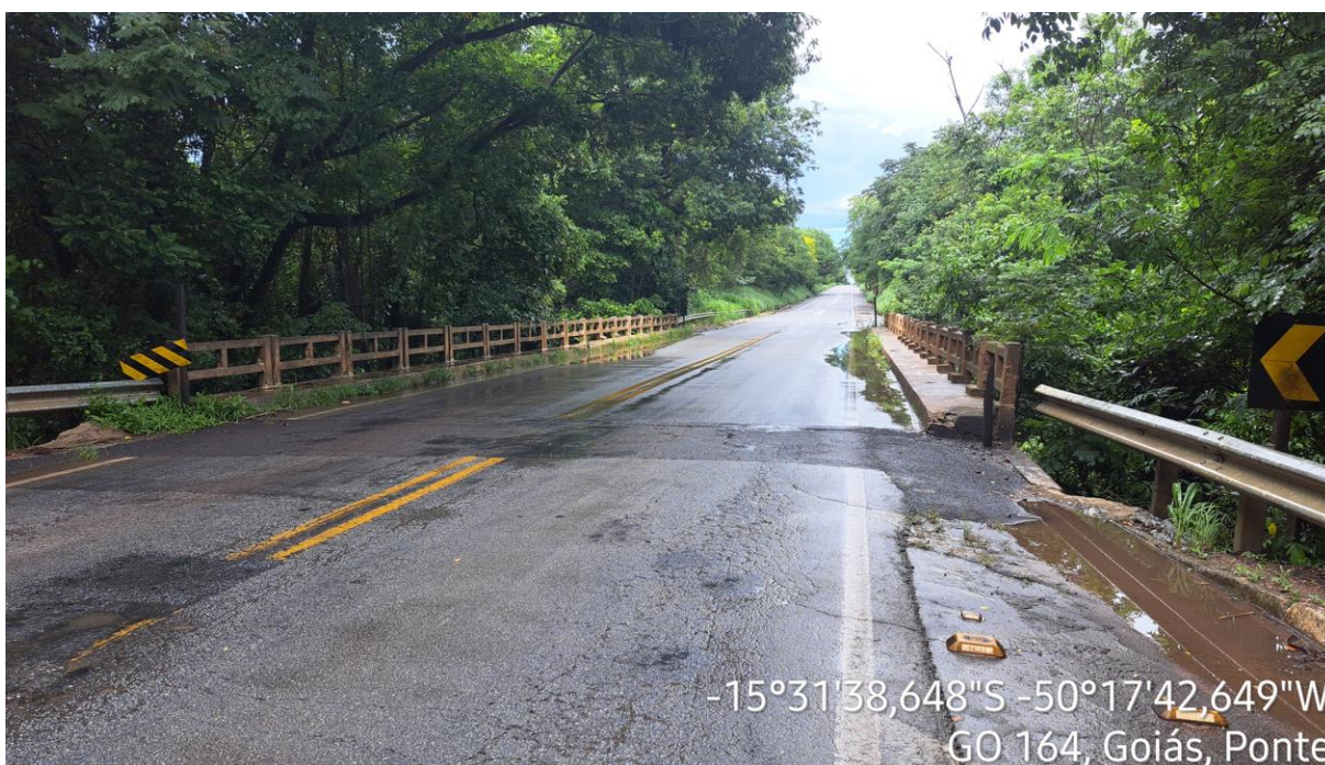
-15°31'38,648"S -50°17'42,649"W GO 164, Goiás, Ponte Km: 56,30 – Ponte em Concreto Armado.
