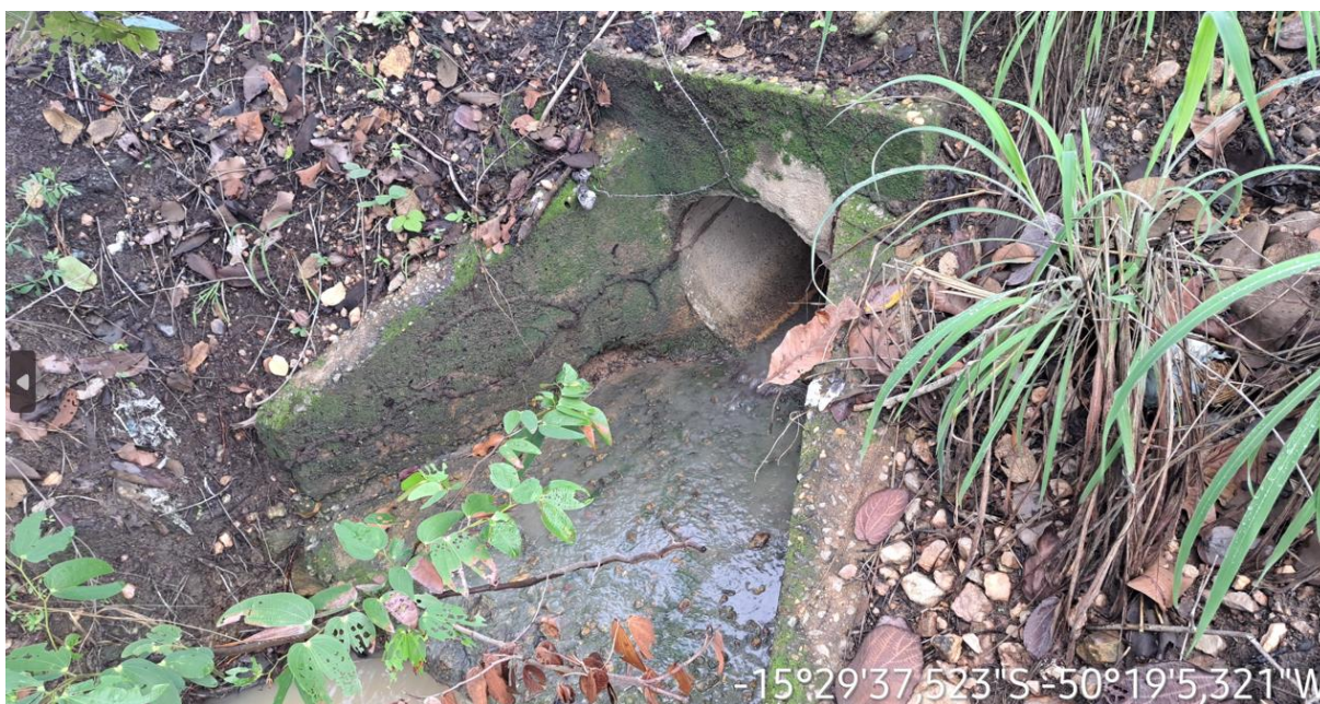
Km: 61,20 – Bueiro tubular.
