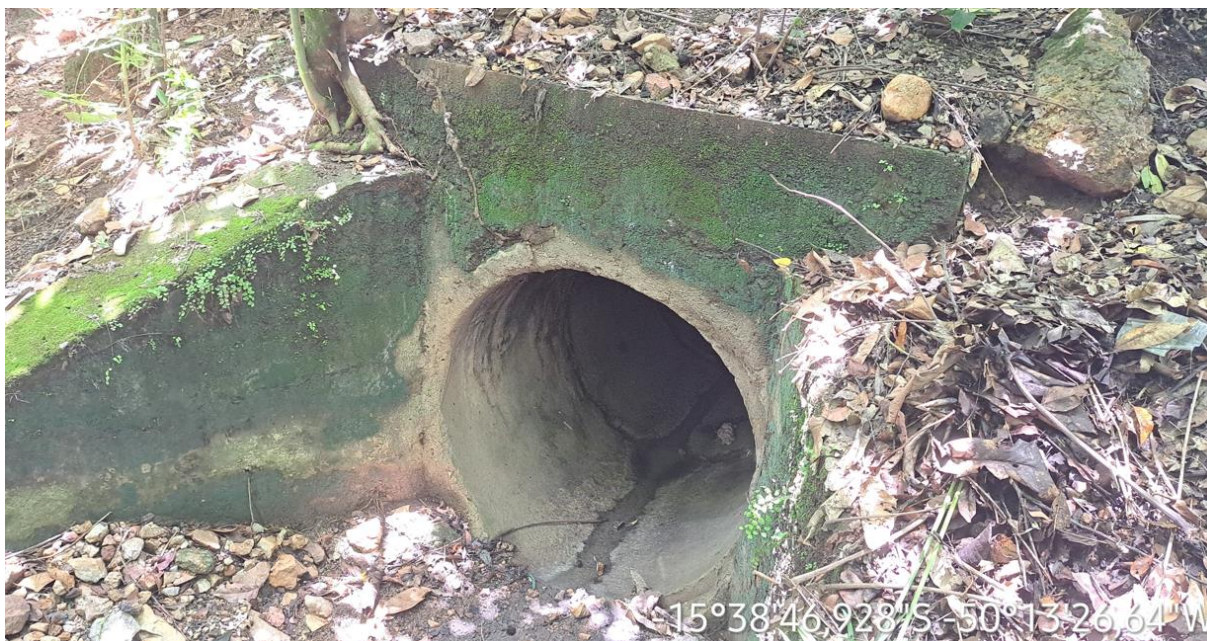
Km: 40,90 – Bueiro tubular.
