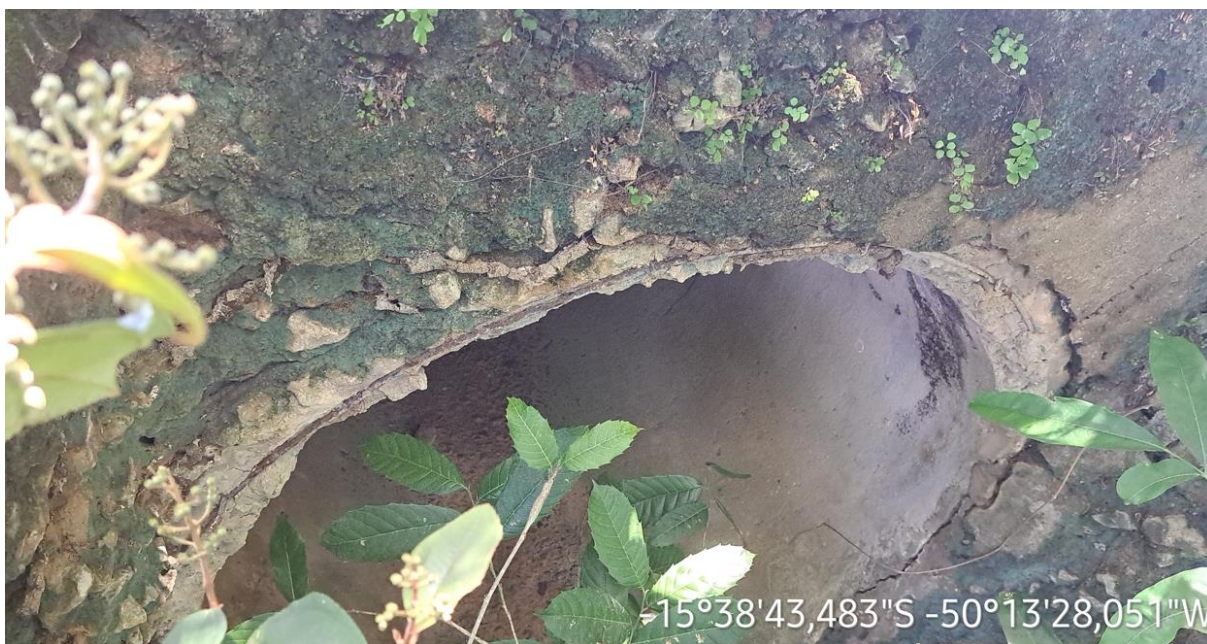
Km: 41,90 – Bueiro tubular.
