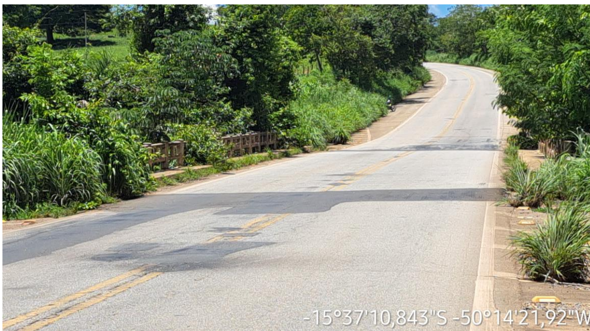
-15^{\circ}37'10,843''S -50^{\circ}14'21,92''W Km: 44,20 – Ponte em Concreto Armado.
