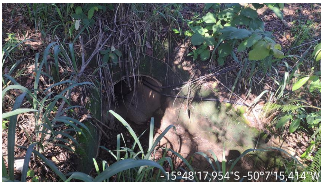
Km: 19,20 – Bueiro tubular.
