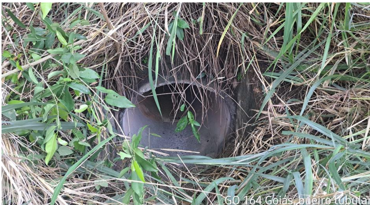
Km: 13,60 – Bueiro tubular.
