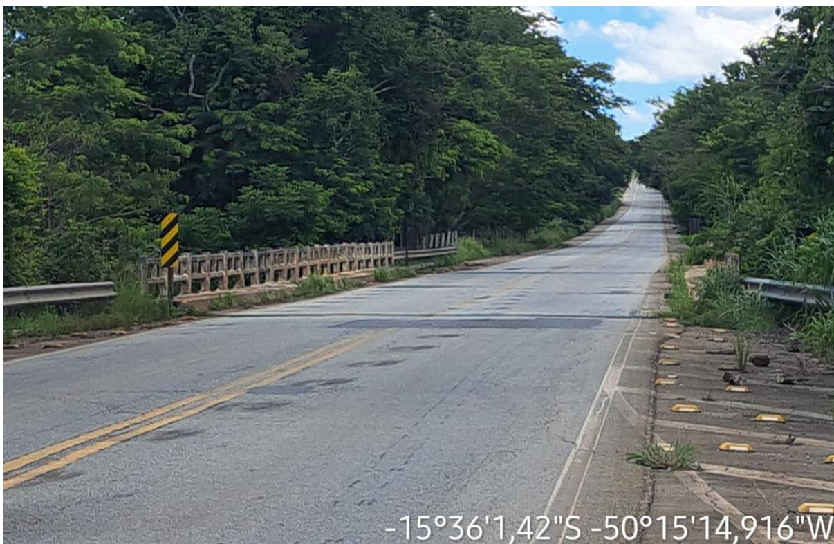
Km: 46,90 - Ponte em Concreto Armado.
