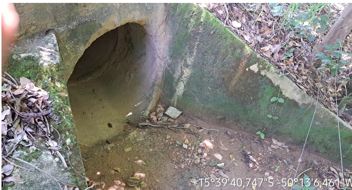
Km: 38,90 – Bueiro tubular.
