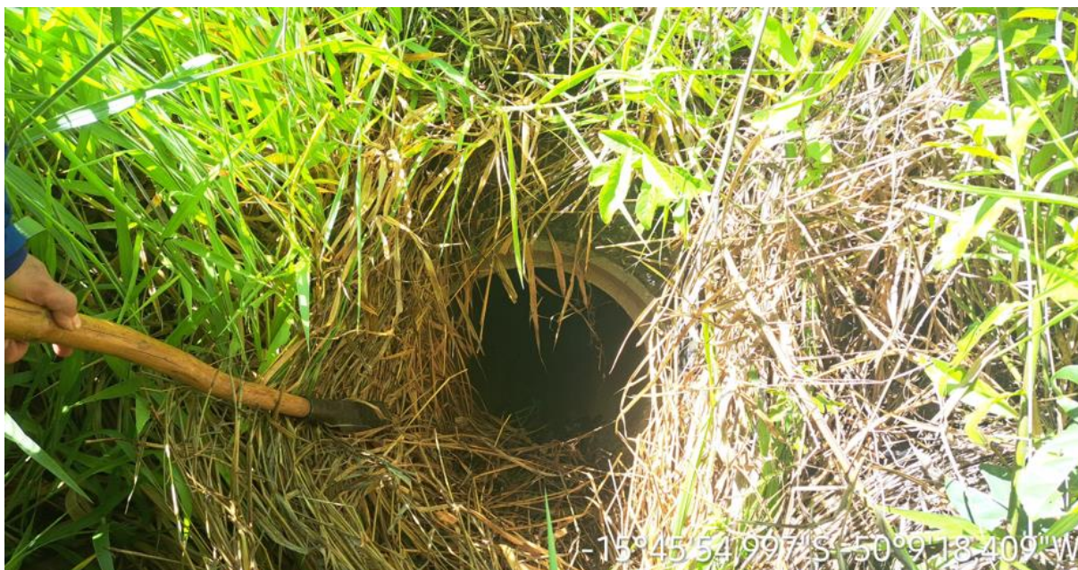
Km: 25,20 – Bueiro tubular.
