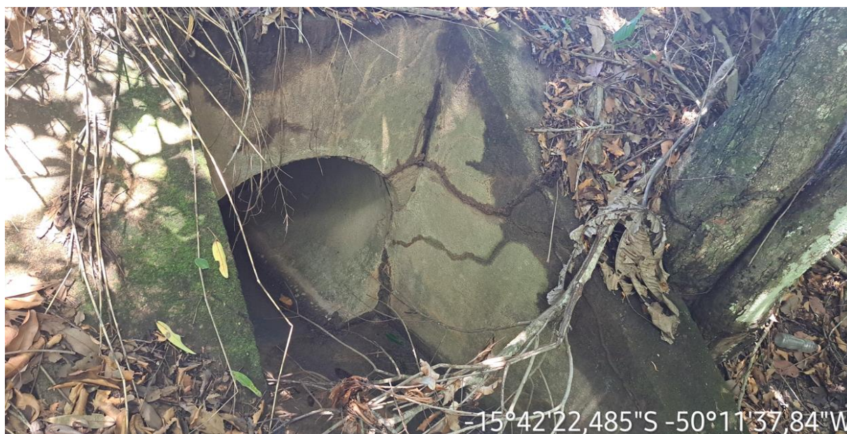
Km: 33,20 - Bueiro tubular.
