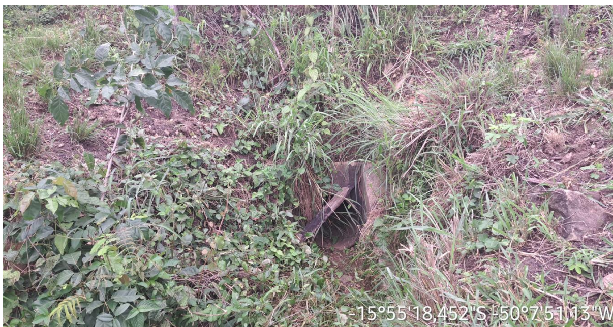
Km: 2,80 – Bueiro Tubular.
