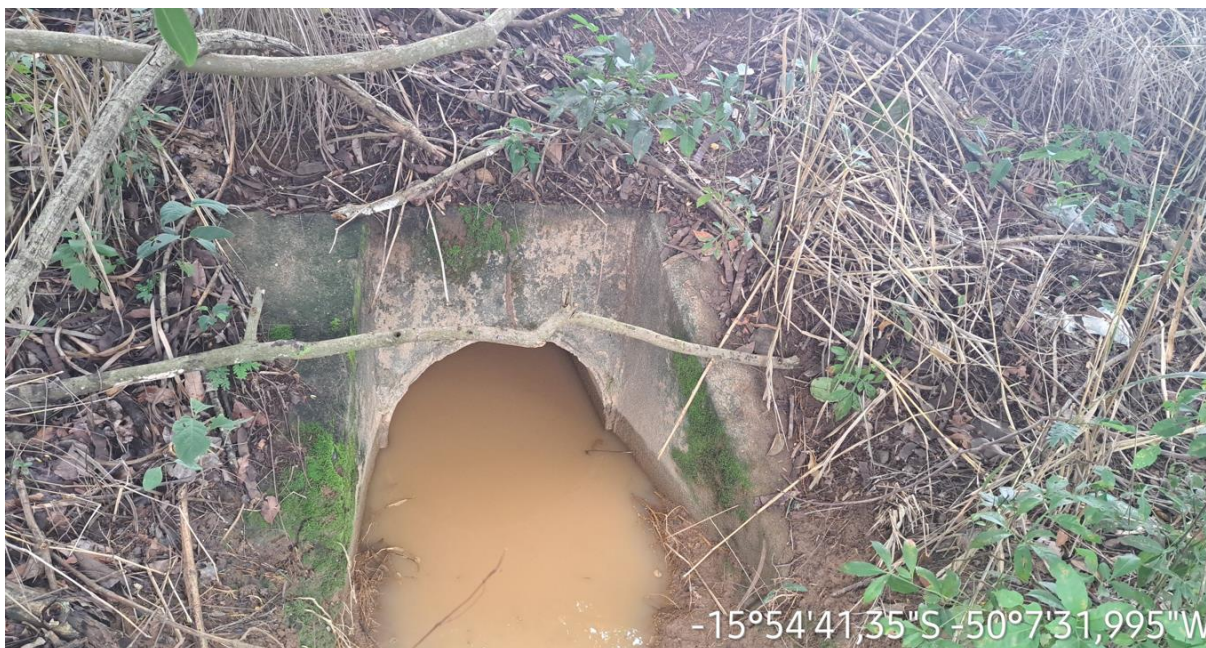
Km: 4,10 – Bueiro Tubular.
