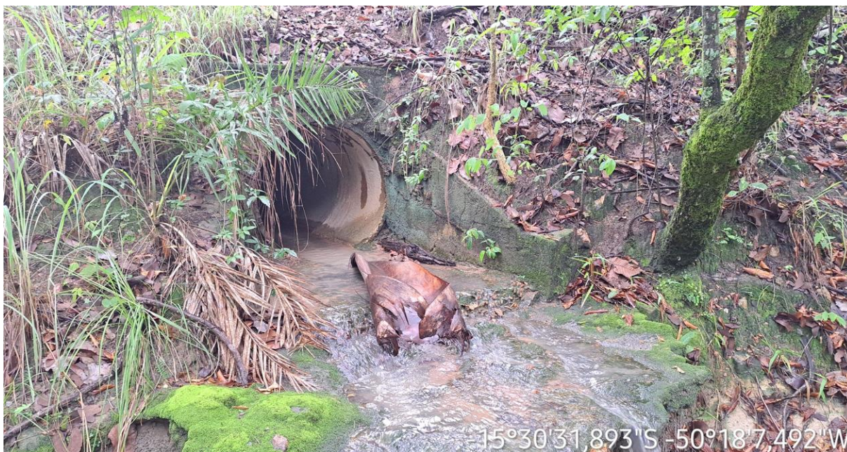
Km: 58,50 - Bueiro tubular.
