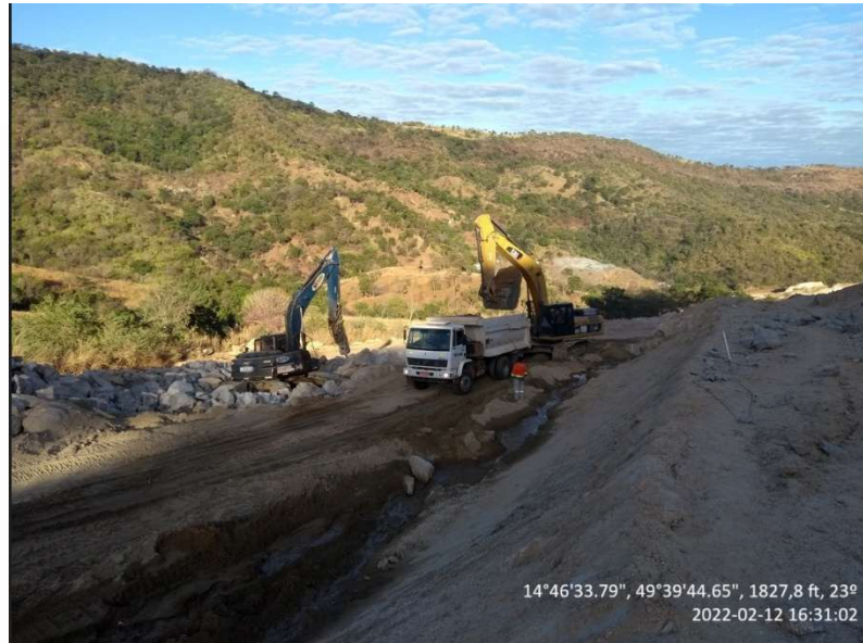
Imagem 6 – Utilização de escavadeira com martelo hidráulico Fonte: Arquivo próprio.
