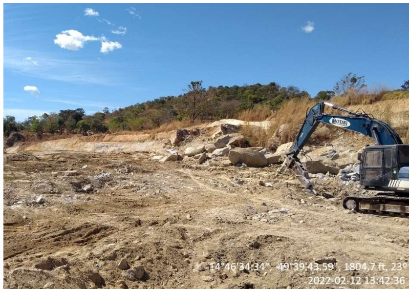
Imagem 4 – Utilização de escavadeira com martelo hidráulico Fonte: Arquivo próprio.
