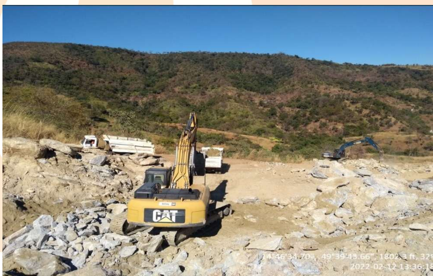
Imagem 3 – Utilização de escavadeira com martelo hidráulico Fonte: Arquivo próprio.
