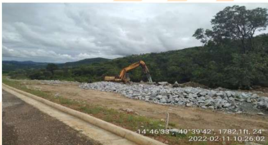
Imagem 2 – Utilização de escavadeira com martelo hidráulico Fonte: Diário de obra anexo (dia 11/02/2022)
