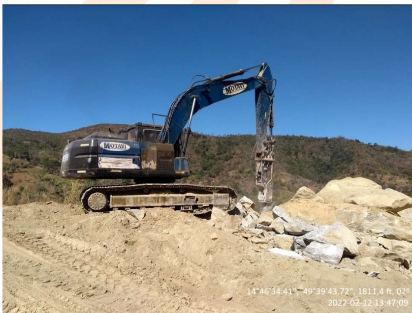
Imagem 5 – Utilização de escavadeira com martelo hidráulico Fonte: Arquivo próprio.
