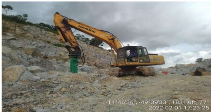
Imagem 1 – Utilização de escavadeira com martelo hidráulico Fonte: Diário de obra anexo (dia 01/02/2022)
