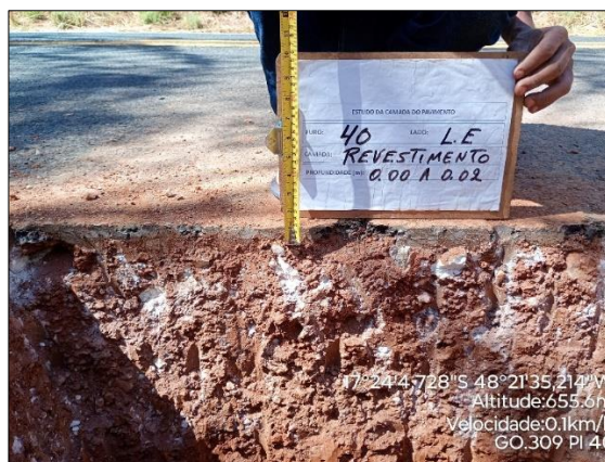
Figura 7 - Registro Fotográfico do Revestimento (PI-01, PI-08 e PI-40).
