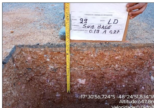
Figura 3 - Identificação das camadas e medição das espessuras.
