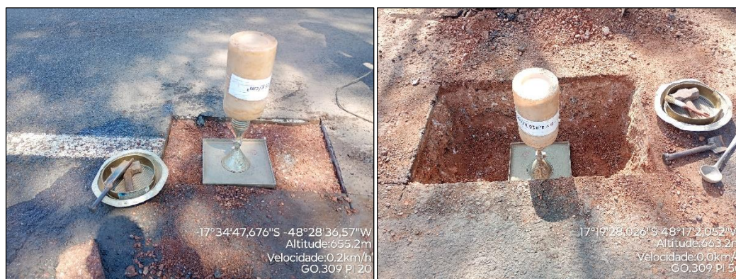
Figura 13 - Ensaio de Densidade In Situ (PI-20 e PI-50)
