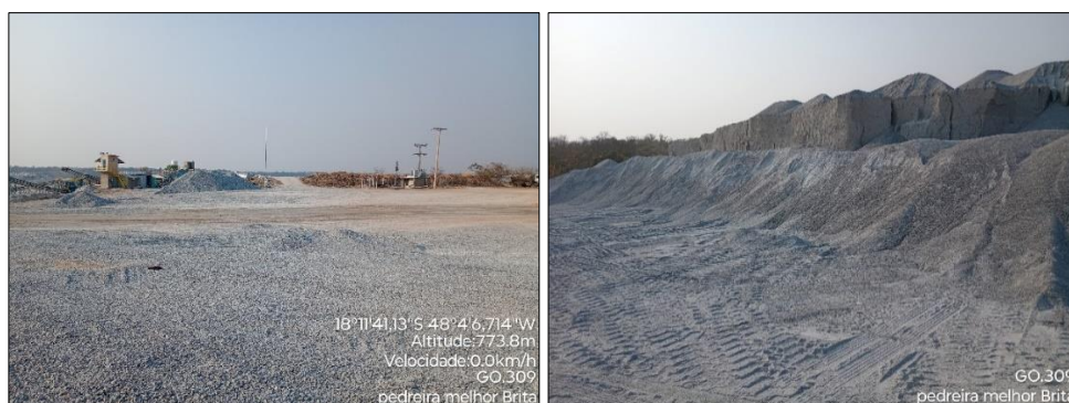
Figura 34 - Retirada de material da Melhor Brita.
