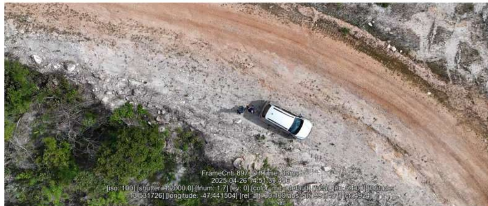
Figura 50 – Material arenoso do alargamento de plataforma no topo da grota, sem tratamento para revegetação.
