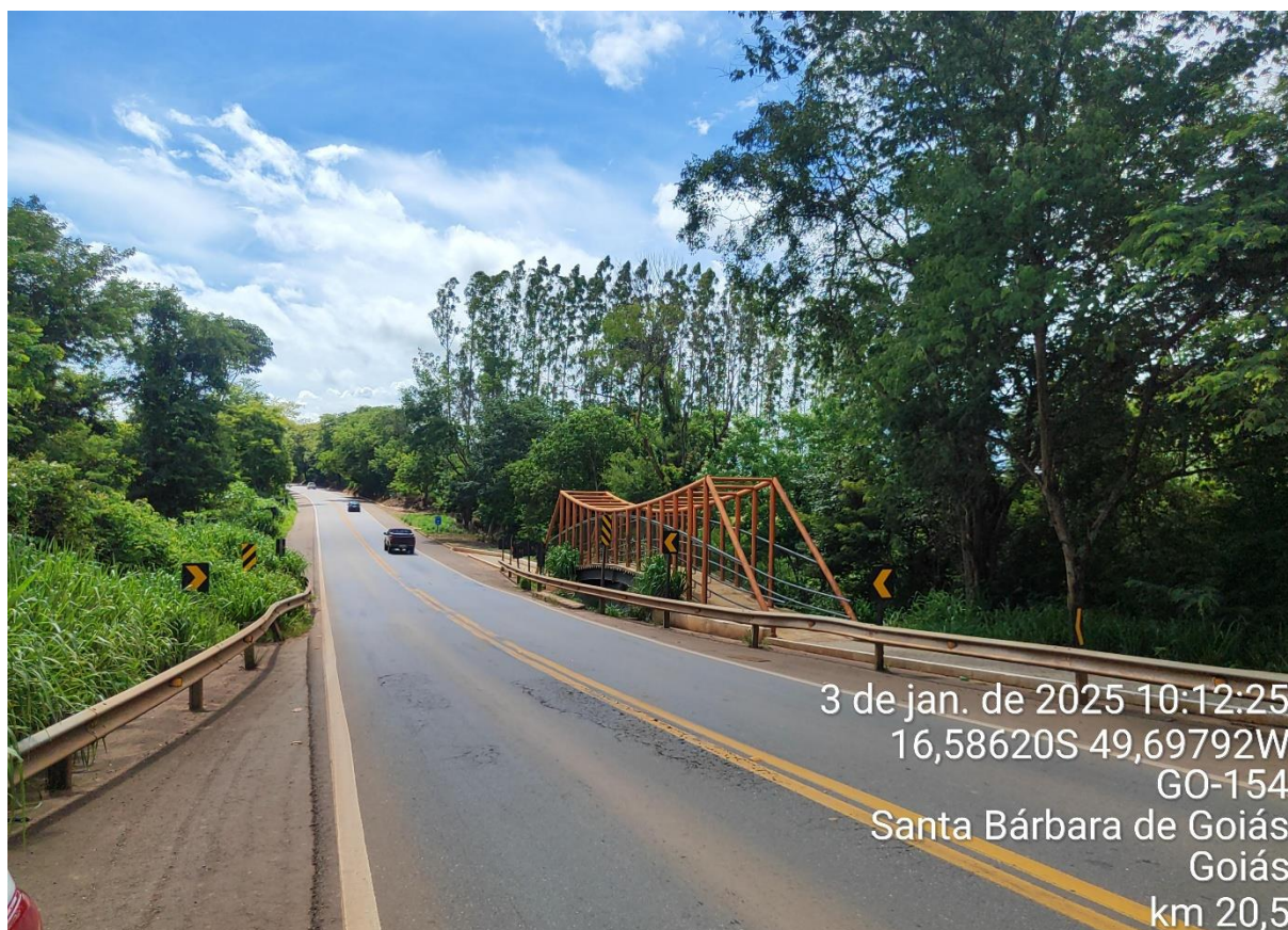
Km: 20,5 – Ponte 7,40 x 5,50 de extensão (com passarela)
