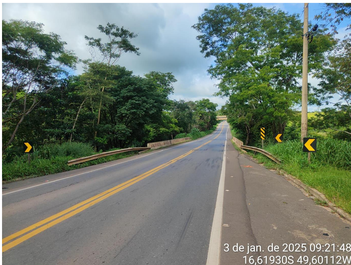
Km: 9,4 – Ponte 9,60 x 30 metros de extensão
