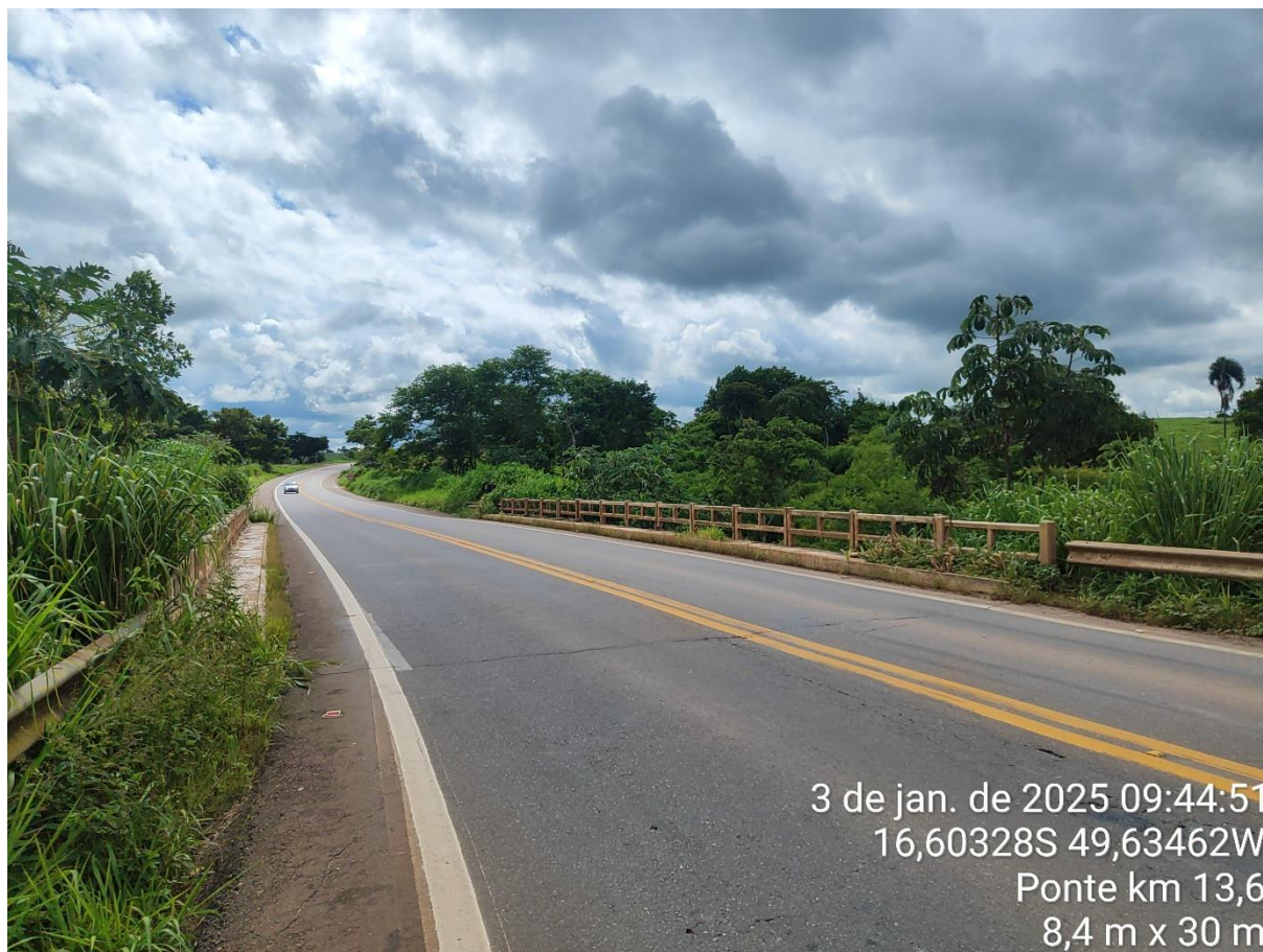
Km: 13,6 – Ponte 8,40 x 30 metros de extensão
