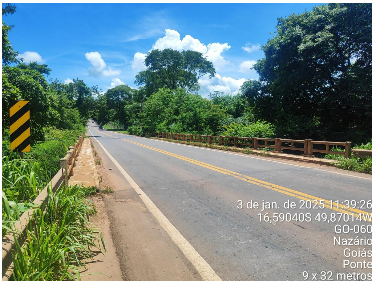
Km: 18,6 – Ponte 9,0 x 32 metros de extensão
