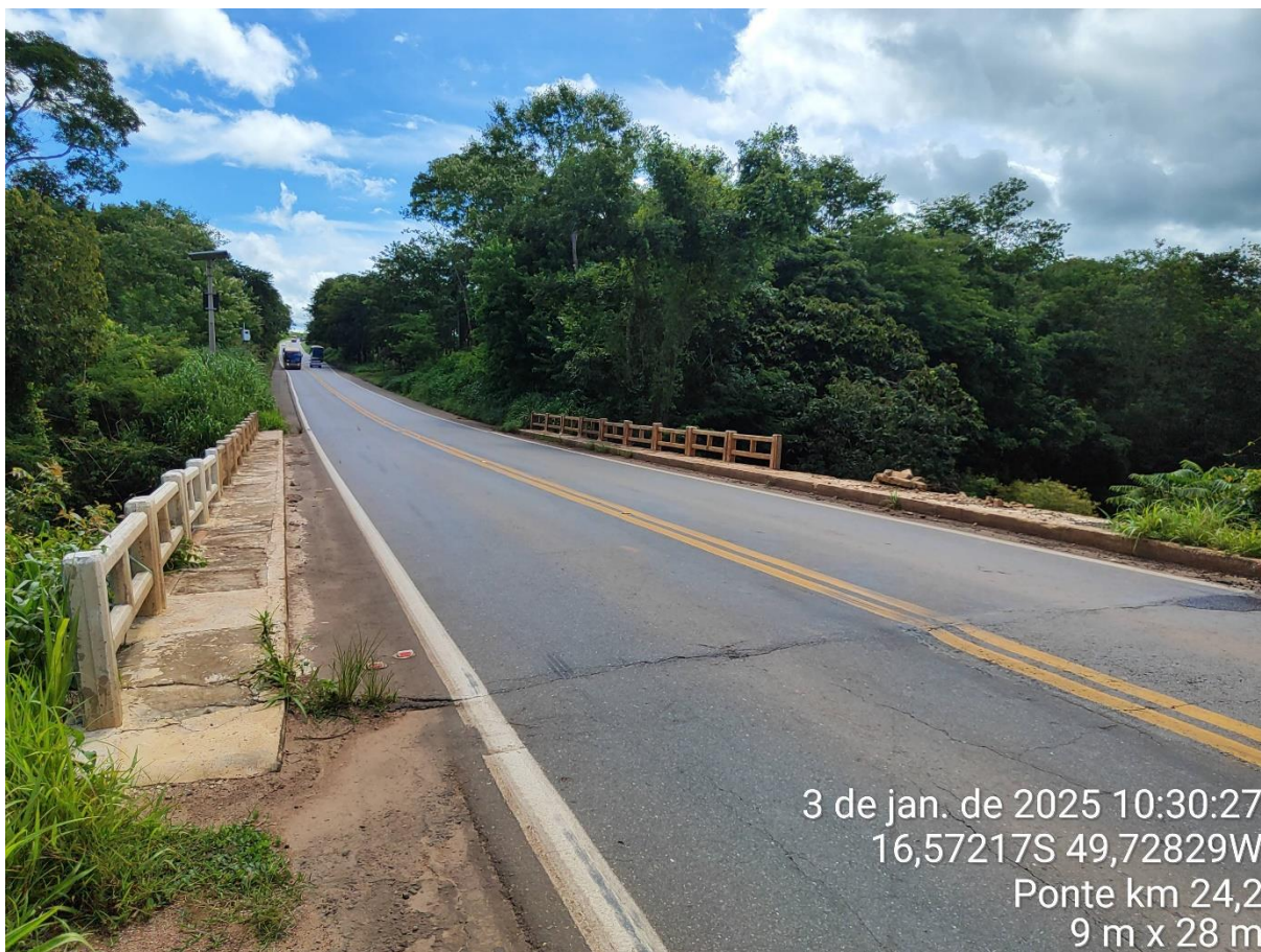
Km: 2,4 – Ponte 9,0 x 28 metros de extensão
