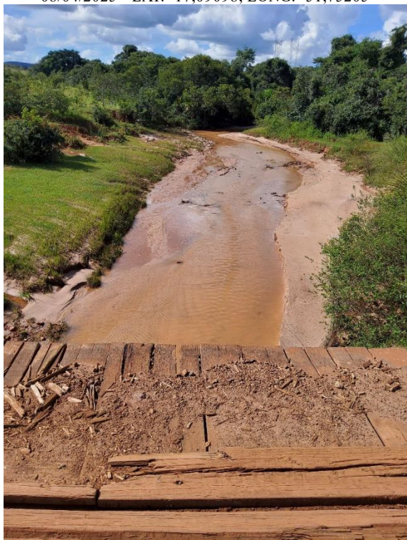
Foto 17 – Ponte de Madeira – km 29,4.
