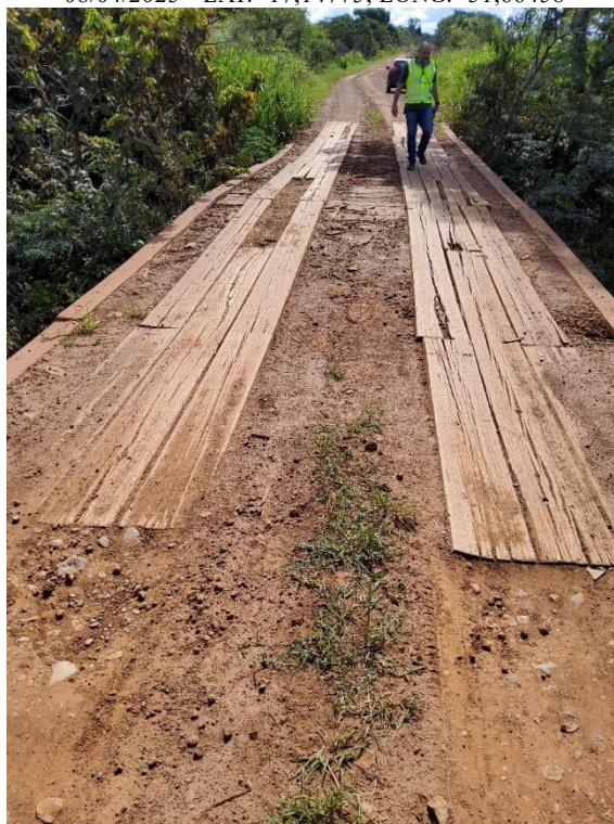
Foto 12 – Ponte de Madeira – km 23,4.
