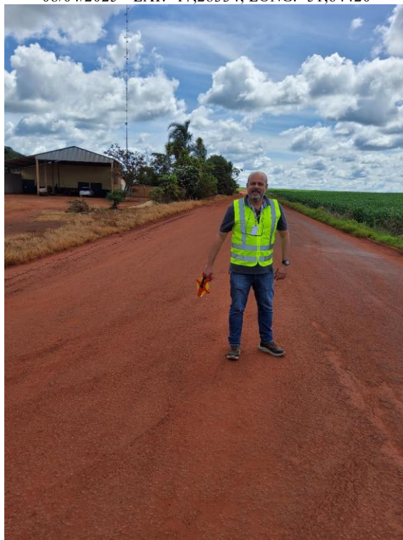
Foto 2 – Início do trecho – km 0,1.
