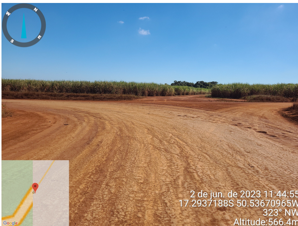
Final do trecho vistoriado, GO-409 entrocamento com GO-333 Km 23,1. (17.2937188S, 50.53670965O)
