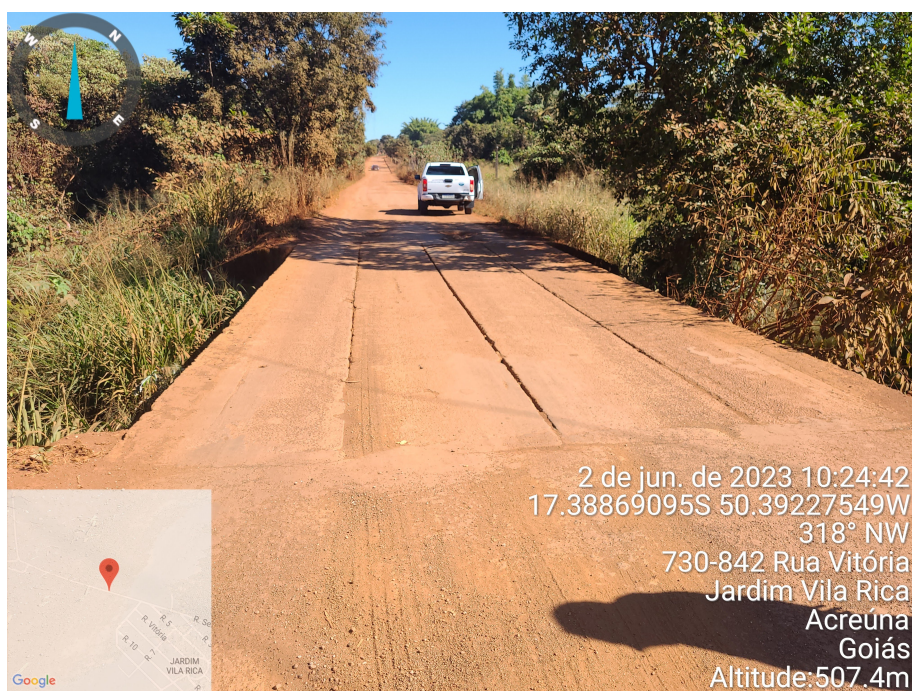
Km 0,9 – Ponte de Concreto sobre Ribeirão da Comprida, extensão 10m..
