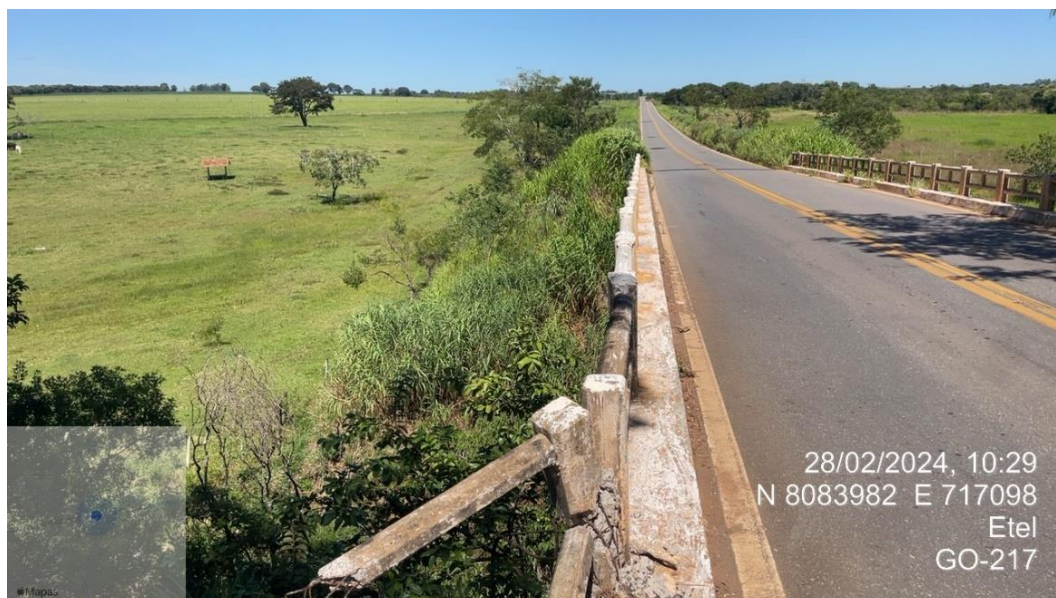
Figura 11 - Ponte sobre o córrego da Bacia 04
