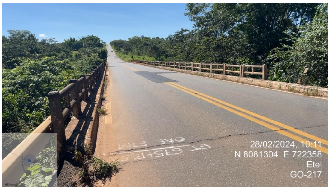
Figura 15 - Ponte sobre o Rio Piracanjuba
