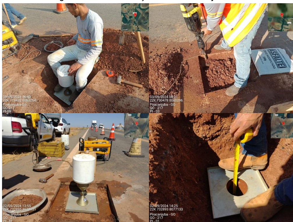
Figura 3.2.2.1-1 – Execução de abertura de janela- PI
