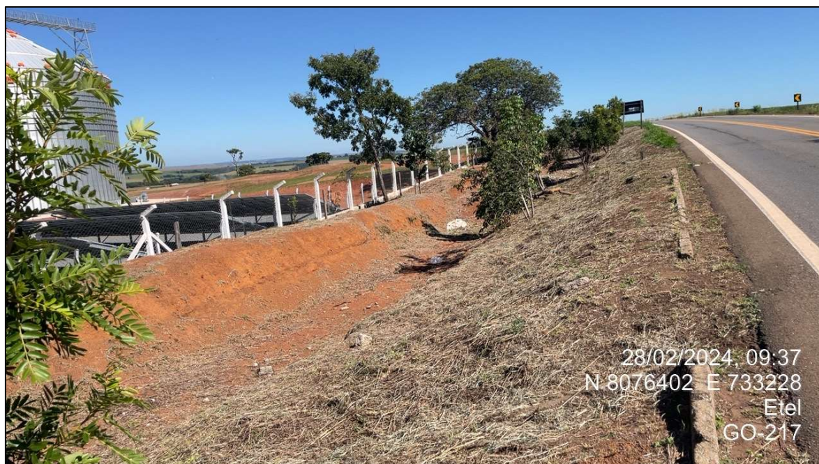
Figura 11 Meio-Fio a ser demolido Est. 11+10 a Est. 20+5,00
