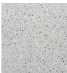
Piso feito in loco tipo granitina.
