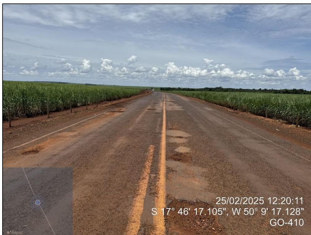
Figura 3: Buracos e remendos
