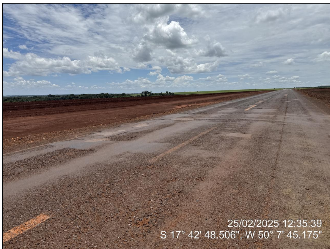
Figura 7: Buracos e afundamentos
