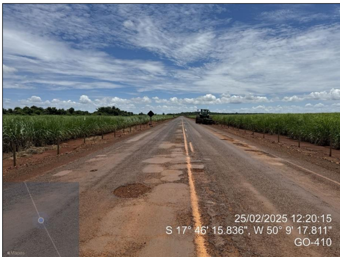
Figura 4: Buracos e remendos
