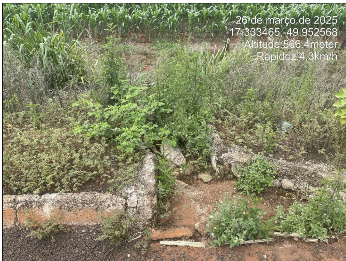
Figura 13: Descida obstruída
