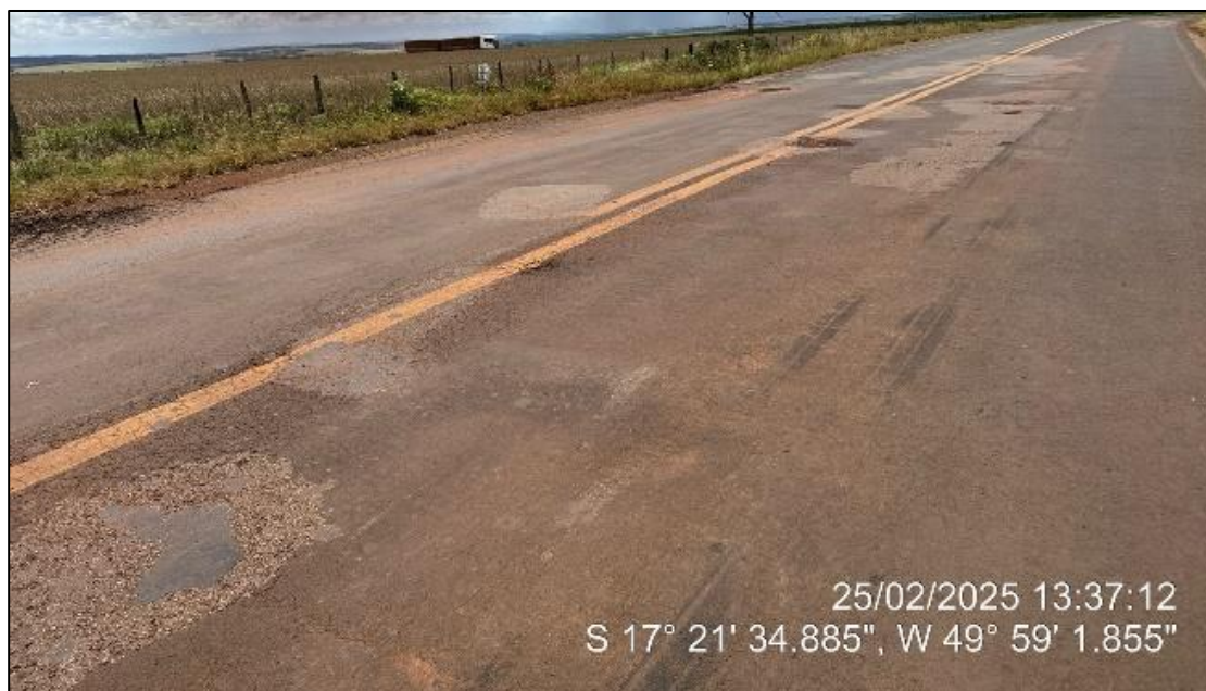
Figura 11: Afundamentos e remendos
