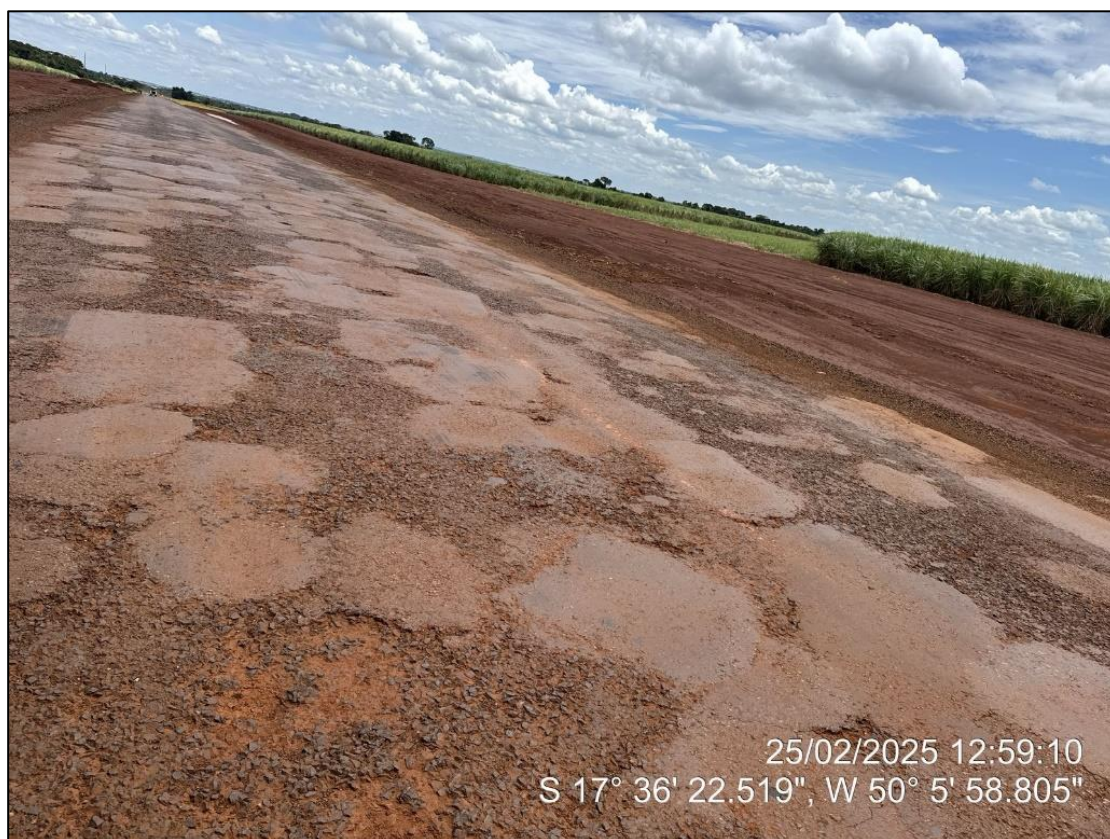
Figura 11: Afundamentos e remendos
