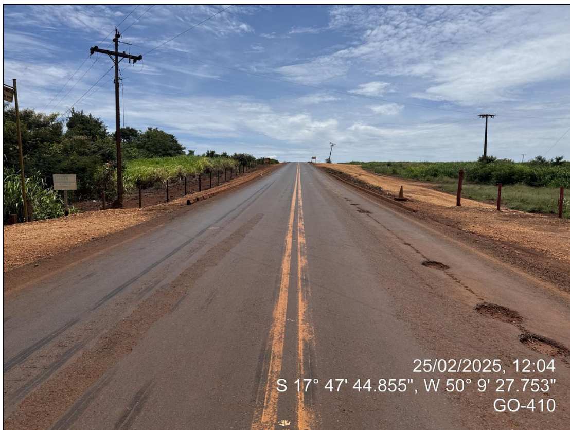
Figura 15: Pavimento com panelas
