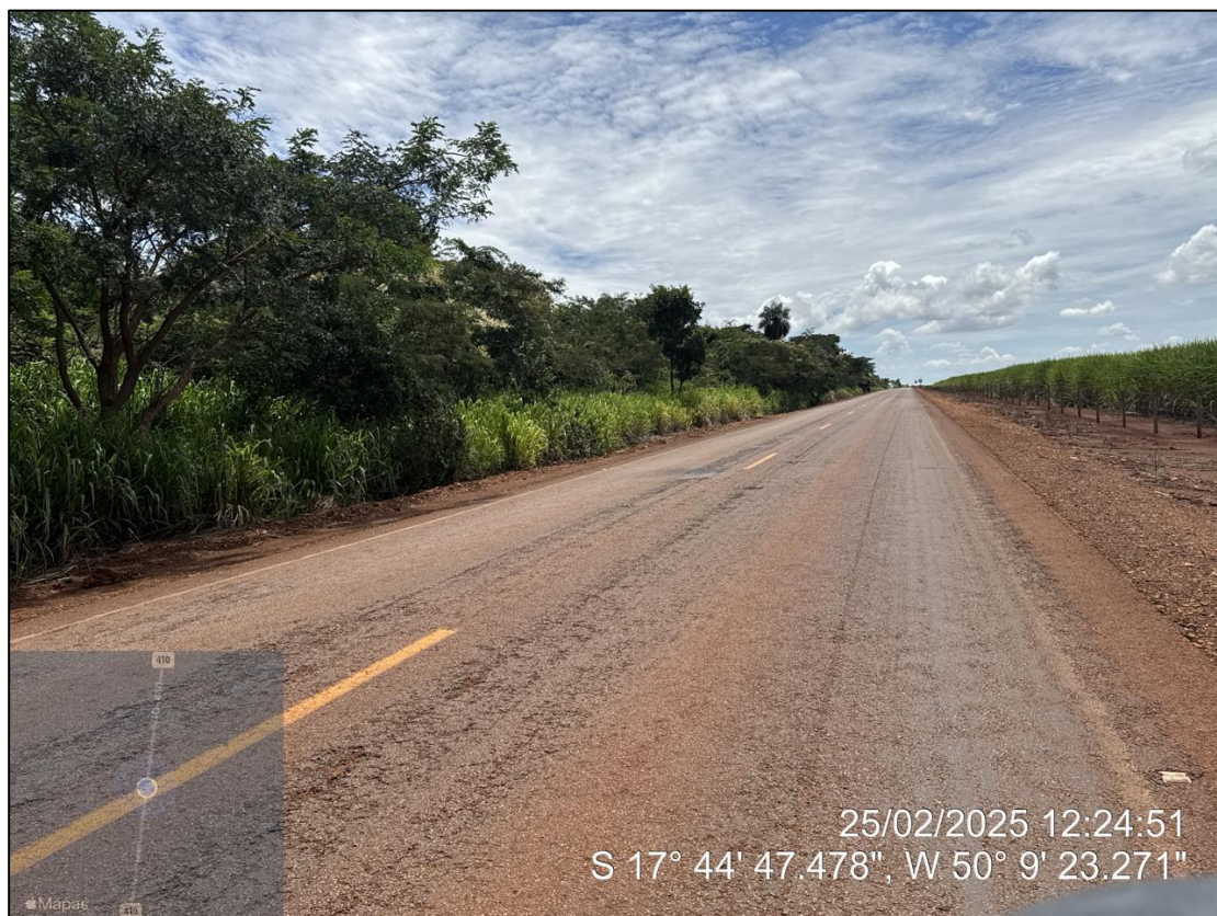
Figura 5: Desgaste e acúmulo de material nos bordos
