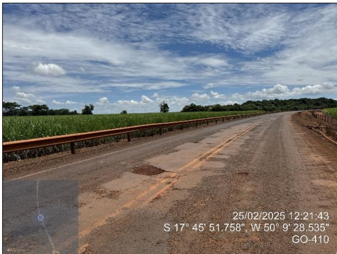
Figura 7: Buracos e afundamentos
