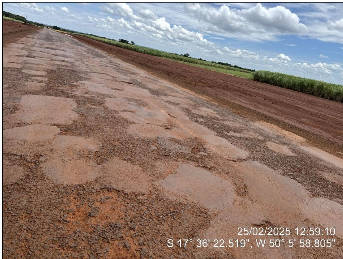
Figura 11: Afundamentos e remendos
