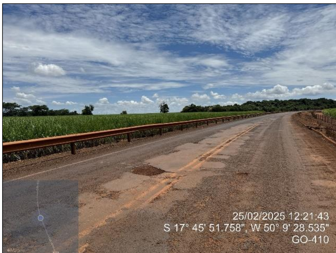
Figura 7: Buracos e afundamentos
