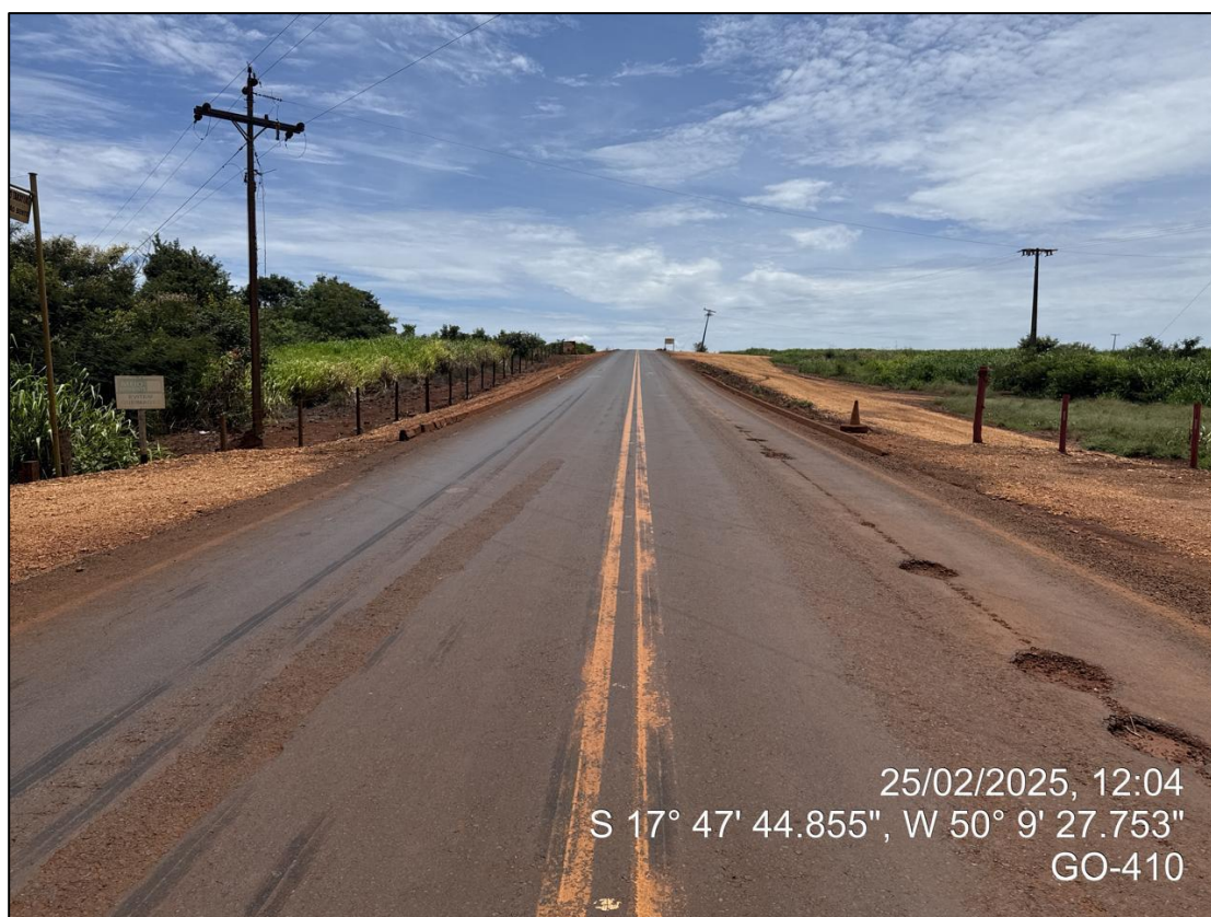
Figura 15: Pavimento com panelas
