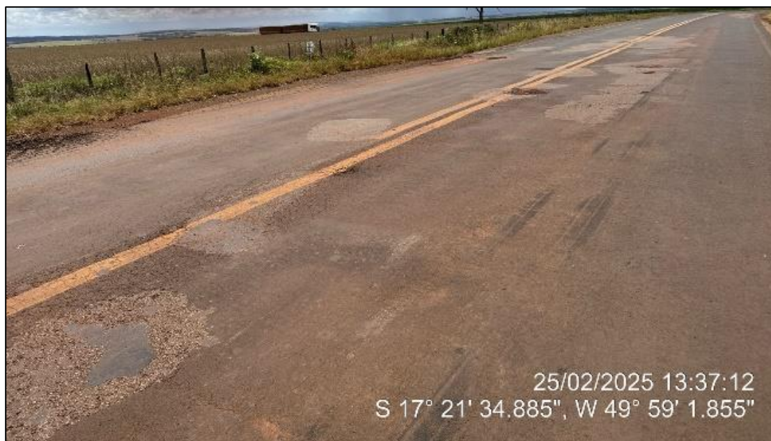
Figura 11: Afundamentos e remendos
