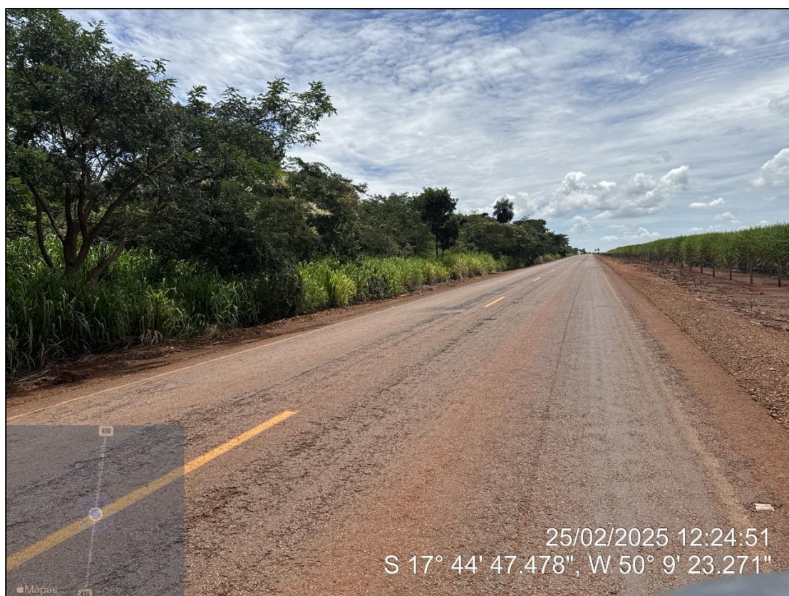
Figura 5: Desgaste e acúmulo de material nos bordos
