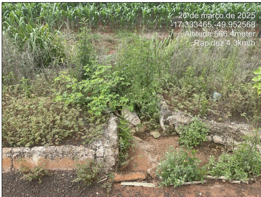
Figura 13: Descida obstruída
