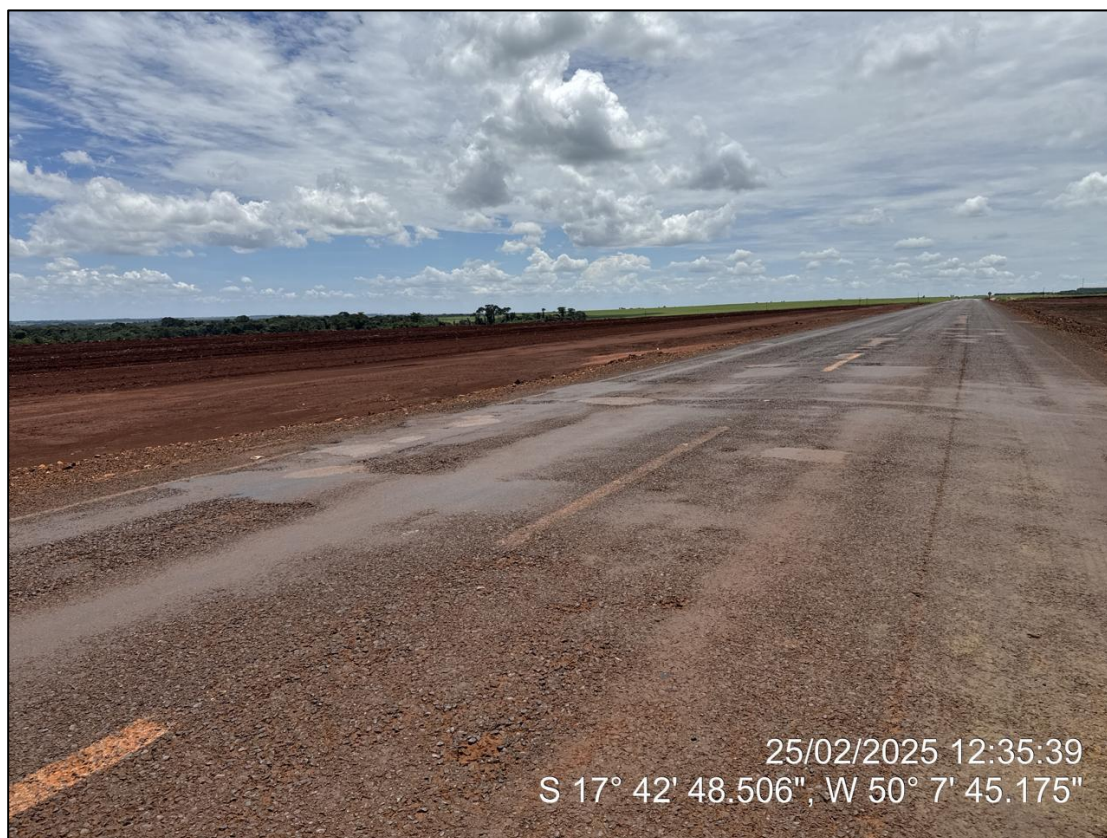
Figura 7: Buracos e afundamentos
