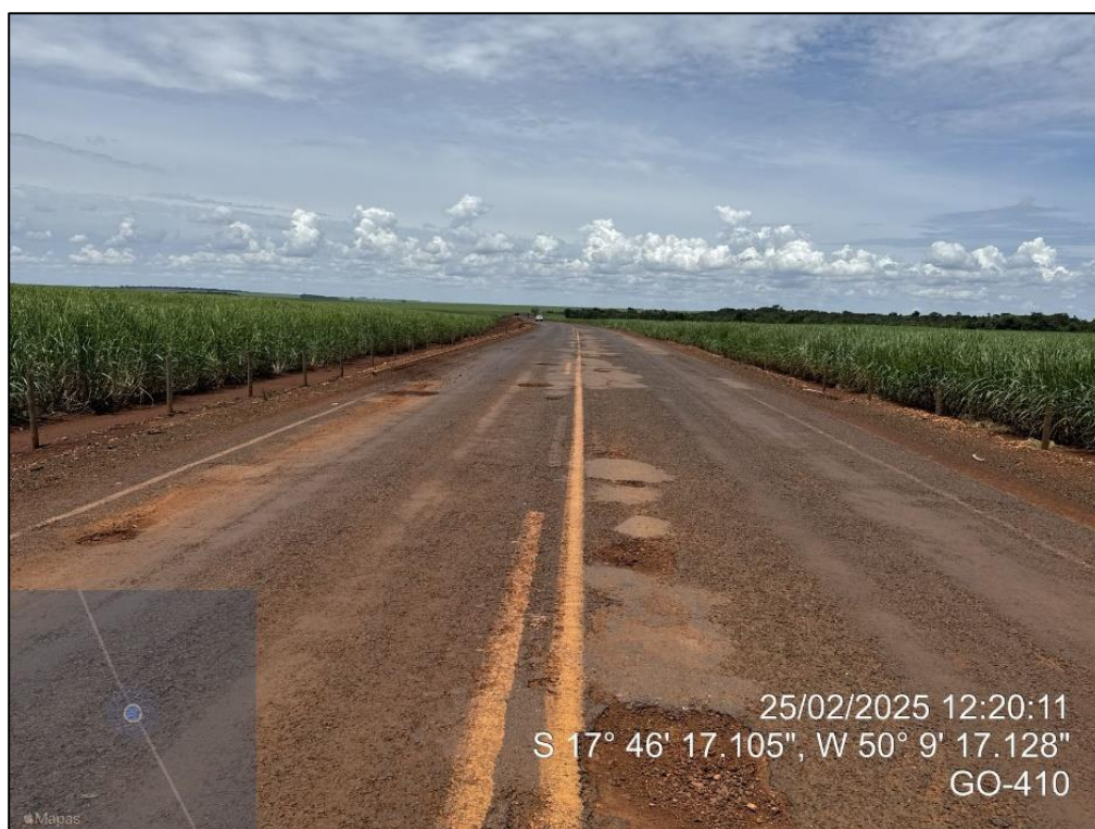
Figura 3: Buracos e remendos
