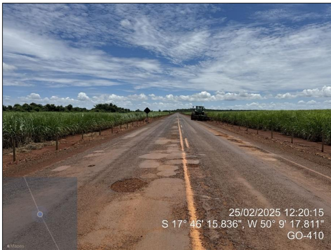
Figura 5: Desgaste e acúmulo de material nos bordos
