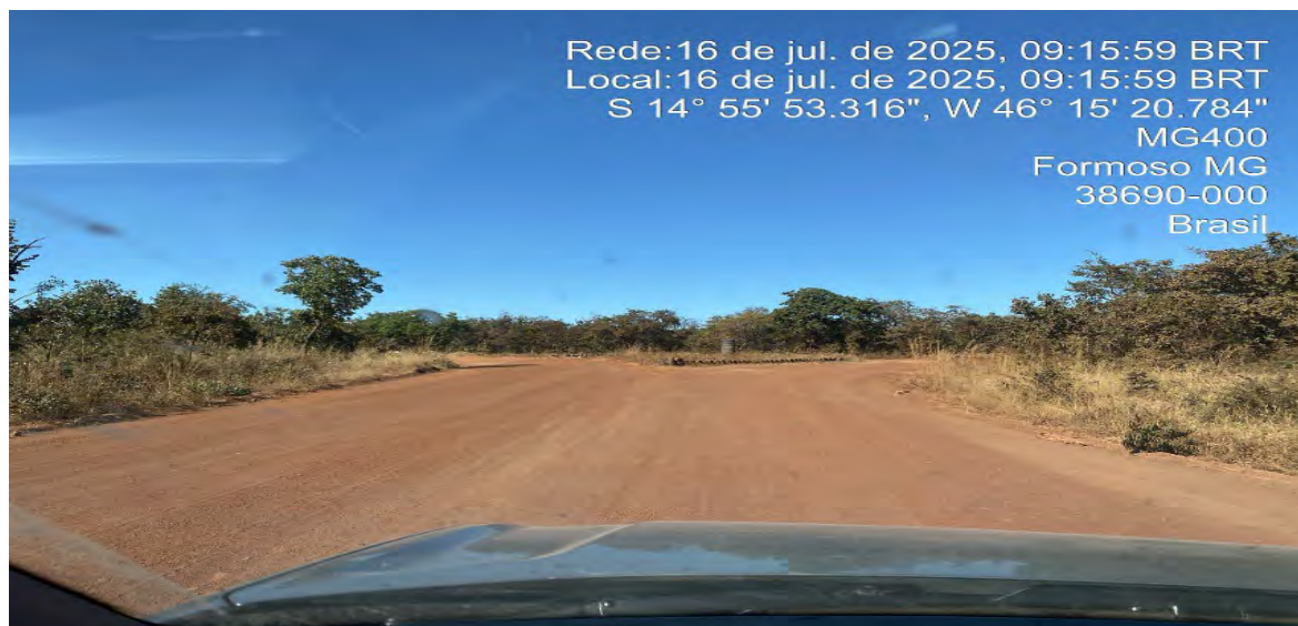
FOTO 2: Final do trecho
