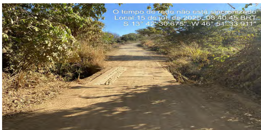
FOTO 4 – Rodovia implantada em “greide rolado”
