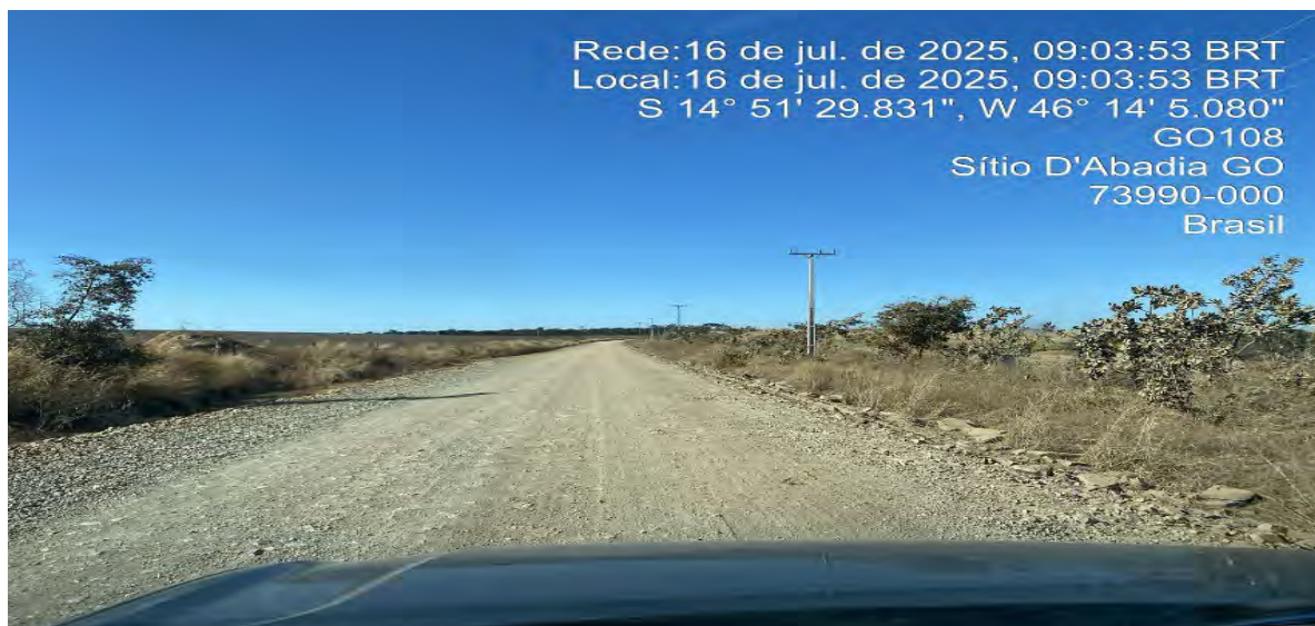
FOTO 5 – Revestimento primário com material segregado nos bordos
