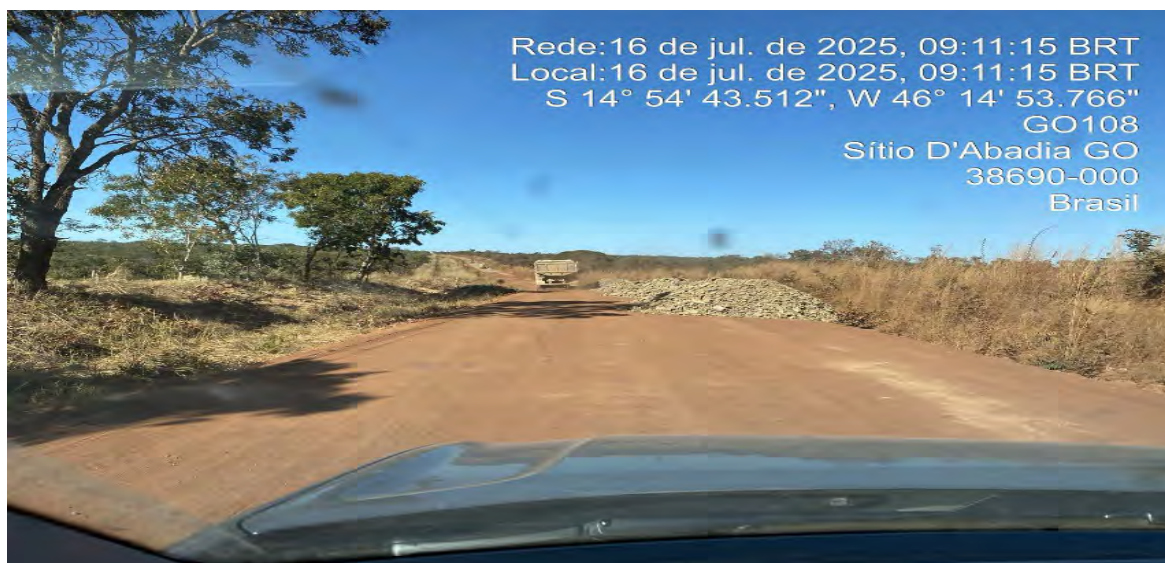
FOTO 6 – Manutenção do revestimento primário
