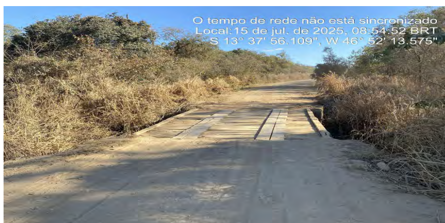
FOTO 5 – Pontilhão de madeira
