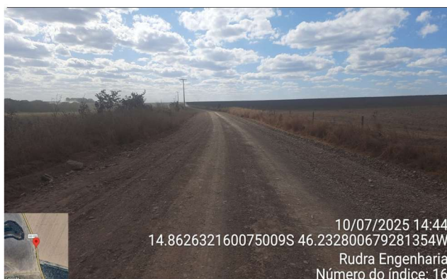
FOTO 16: km 7,15 - Vista sentido contrário
