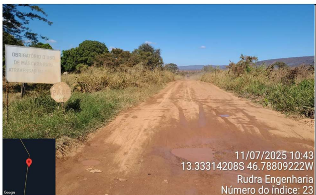
FOTO 23: km 34,3 - Vista sentido balsa
