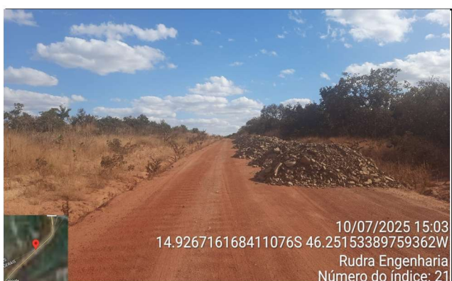
FOTO 21: km 15,03 - Material na pista (largura 8,8m)
