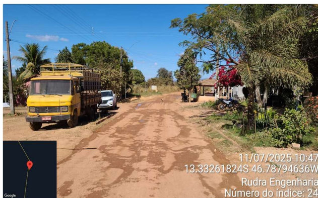
FOTO 24: km 34,3 - Final do Trecho
