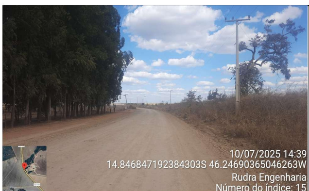
FOTO 15: km 4,79 - Linha de postes LD (pista com 9,2m)
