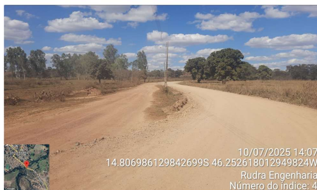
FOTO 4: km 0,045 - Início do trecho
