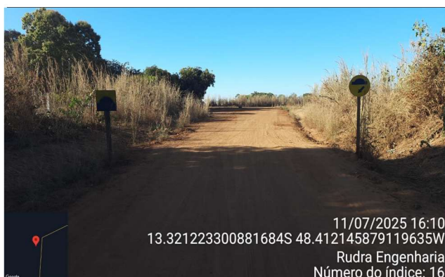
FOTO 16: km 23,57 - Placas de lombada - Largura da pista 5,50m
