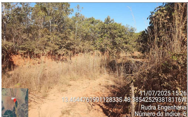
FOTO 7: km 7,01 - Vista - Largura da pista 7,00m
