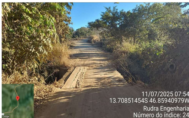
FOTO 24: km 4,78 - Ponte de madeira
