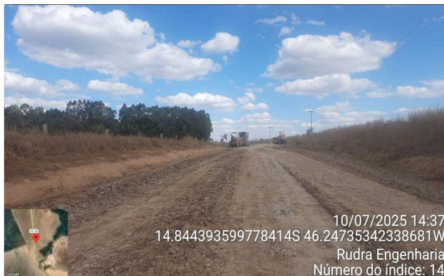
FOTO 14: km 4,50 - Máquinas na pista
