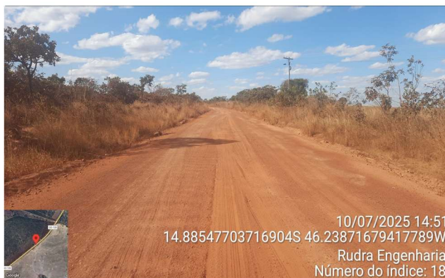
FOTO 18: km 9,90 - Linha de transmissão cruzando a pista
