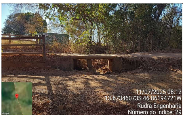
FOTO 29: km 9,07 - Ponte de madeira (vista lateral)
