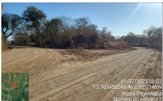
FOTO 27: km 5,55 Interseção PE e acesso PD
