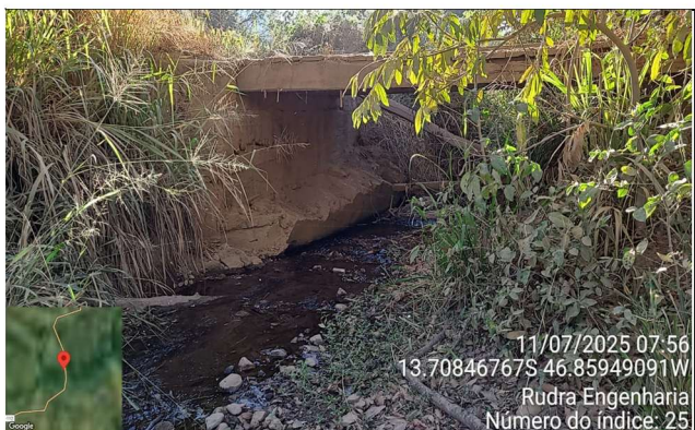
FOTO 25: km 4,78 - Ponte de madeira
