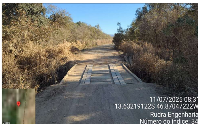
FOTO 34: km 13,83 - Ponte de madeira
