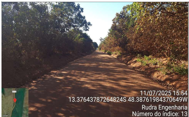
FOTO 13: km 16,10- Vista - Largura da pista 6,30m
