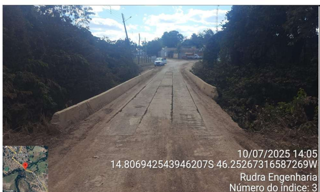
FOTO 3: km 0,04 - Ponte (vista sentido contrário)
