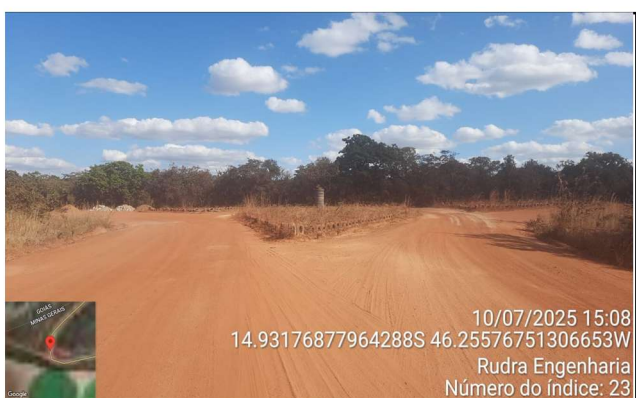
FOTO 23: km 15,80 - Final do trecho
