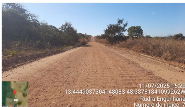
FOTO 6: km 5,90 - Caixa de empréstimo - LD
