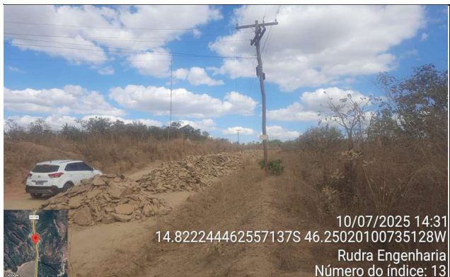
FOTO 13: km 2,00 - Linha de baixa tensão
