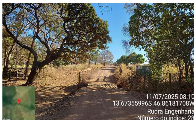
FOTO 28: km 9,07 - Ponte de madeira
