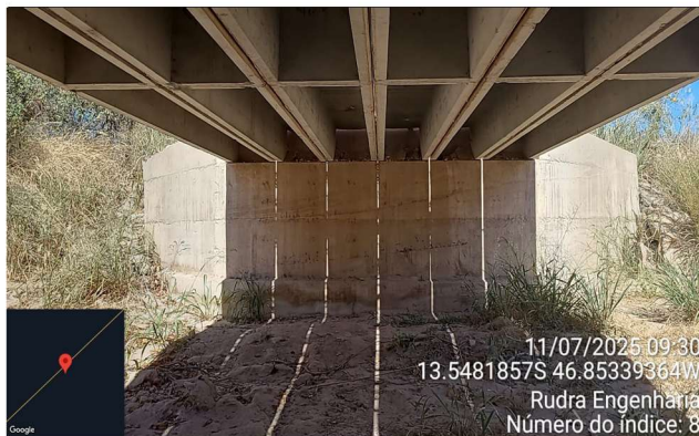
FOTO 8: km 6,4 - PPM 12,00x6,00m - Nascente do Rio São Domingos - MD
