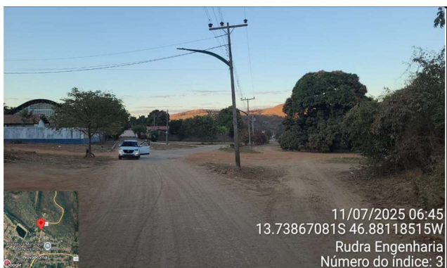
FOTO 3: km 0,019 - Início do Trecho
