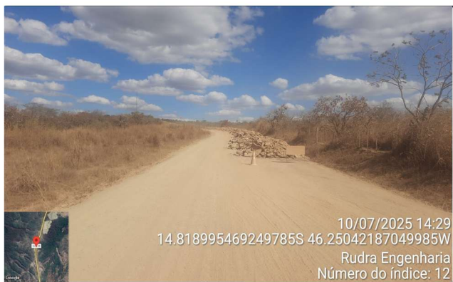
FOTO 12: km 1,65 - Material depositado na PD até o km 3,9
