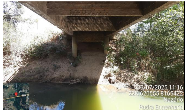
FOTO 16: km 18,80 - Ponte sobre o Rio dos Bois
