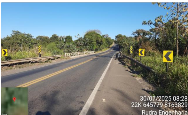
FOTO 19: km 13,70 - Ponte Terra Podre
