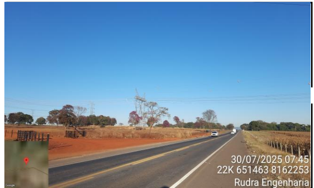
FOTO 9: km 7,10 - Linha de Alta Tensão
