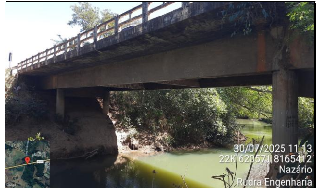
FOTO 14: km 18,80 - Ponte sobre o Rio dos Bois
