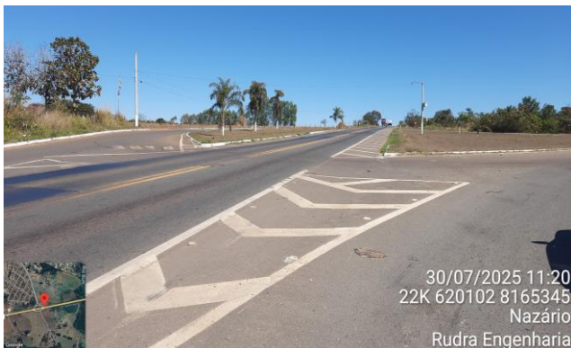
FOTO 17: km 19,30 - Início do Perímetro Urbano - Nazário
