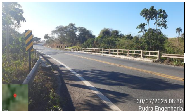
FOTO 20: km 13,70 - Ponte Terra Podre - (Sentido Sta. Bárbara/Trindade)
