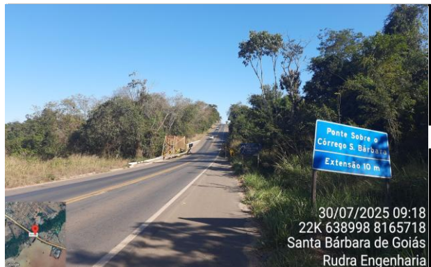
FOTO 28: km 21,00 - Ponte Córrego Santa Bárbara e Passarela
