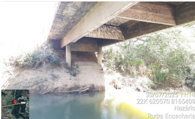
FOTO 15: km 18,80 - Ponte sobre o Rio dos Bois
