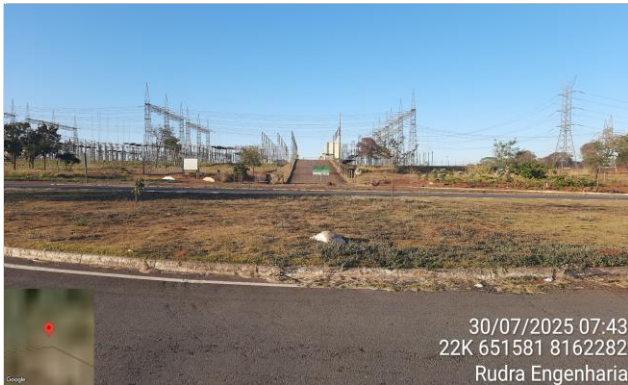
FOTO 8: km 7,00 - Trevo (Substação Energia)
