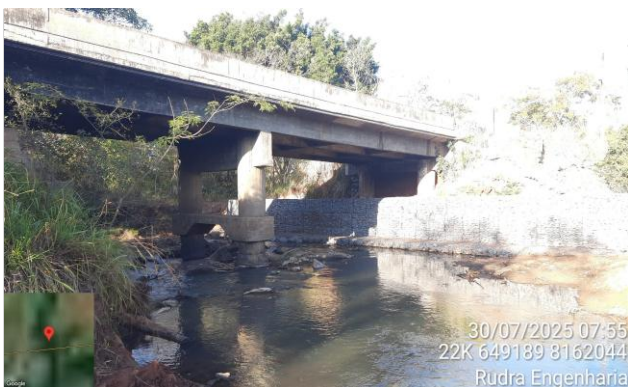
FOTO 12: km 9,60 - Ponte Córrego Fazendinha - MD
