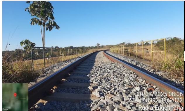
FOTO 15: km 9,90 - Ferrovia (Vão livre \pm 2.00m)
