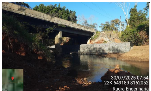
FOTO 11: km 9,60 - Ponte Córrego Fazendinha - MD
