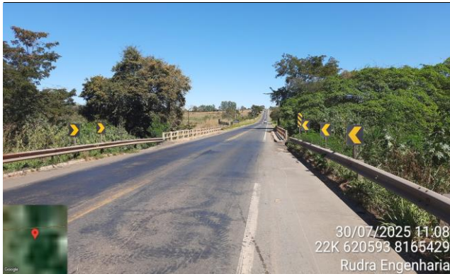
FOTO 13: km 18,80 - Ponte sobre o Rio dos Bois
