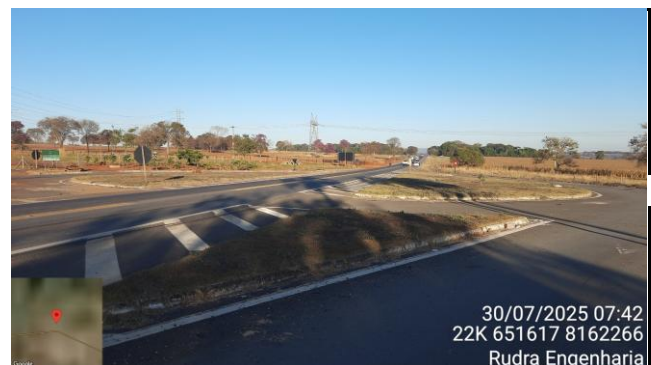
FOTO 7: km 6,50 - Rede de Alta Tensão
