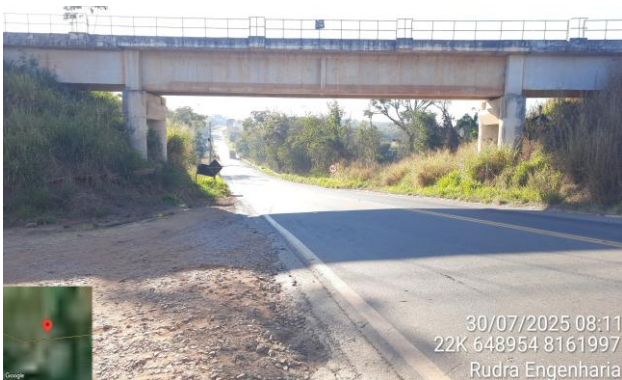
FOTO 17: km 9,90 - Ferrovia (Vão livre \pm 2.00m)
