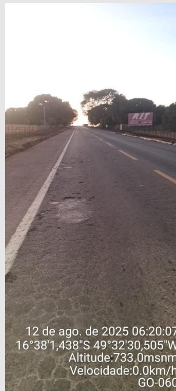
FOTO 02: Couro de Jacaré com remendo
