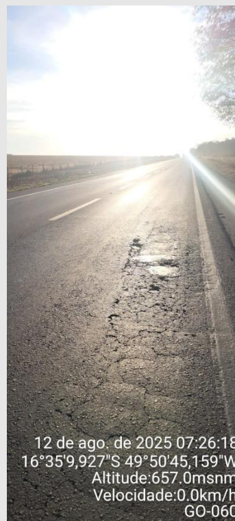
FOTO 02: Couro de Jacaré com remendo
