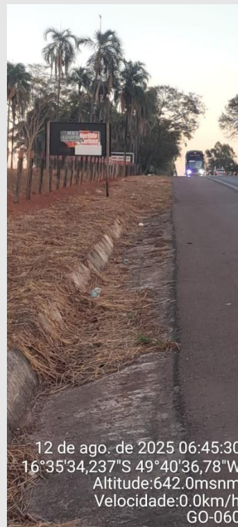
FOTO 06: Sistema de Drenagem Obstruído
