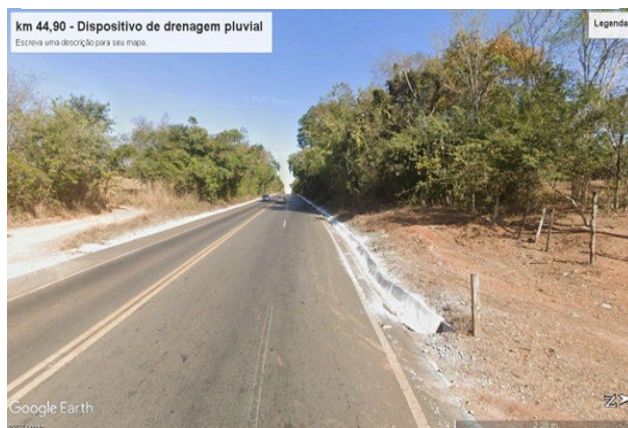
Foto 5 – km 44,90 – Dispositivo de drenagem pluvial
