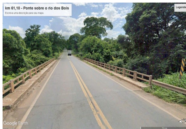
Foto 4 – Ponte sobre o córrego dos Bois
