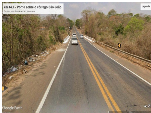
Foto 3 – Ponte sobre o córrego São João
