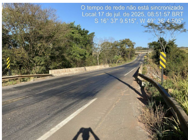
Foto 7 – Proximidade entre ponte rodoviária e viaduto ferroviário
