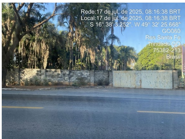
Foto 15 – Edificação lindeira no bordo da rodovia
