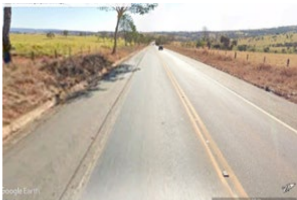
Foto 1: Rodovia em “greide colado”
