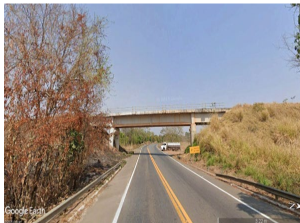
Foto 8 – Viaduto Ferrovia Norte Sul
