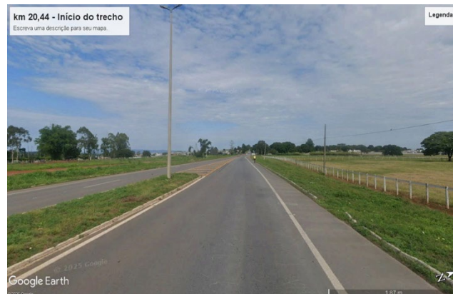
Foto 2: Início do trecho
