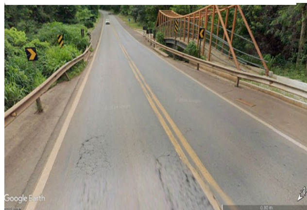
Foto 6 – Ponte sobre o córrego Santa Bárbara
