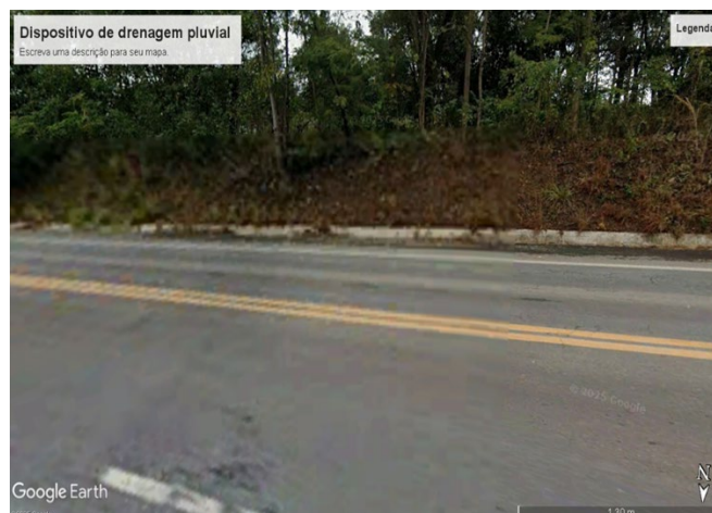
Foto 12 – Dispositivo de drenagem pluvial
