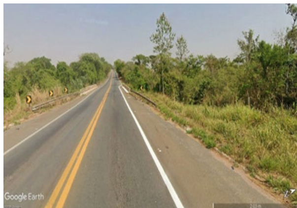
Foto 5 – Ponte sobre o córrego Barreiro/Terra Podre
