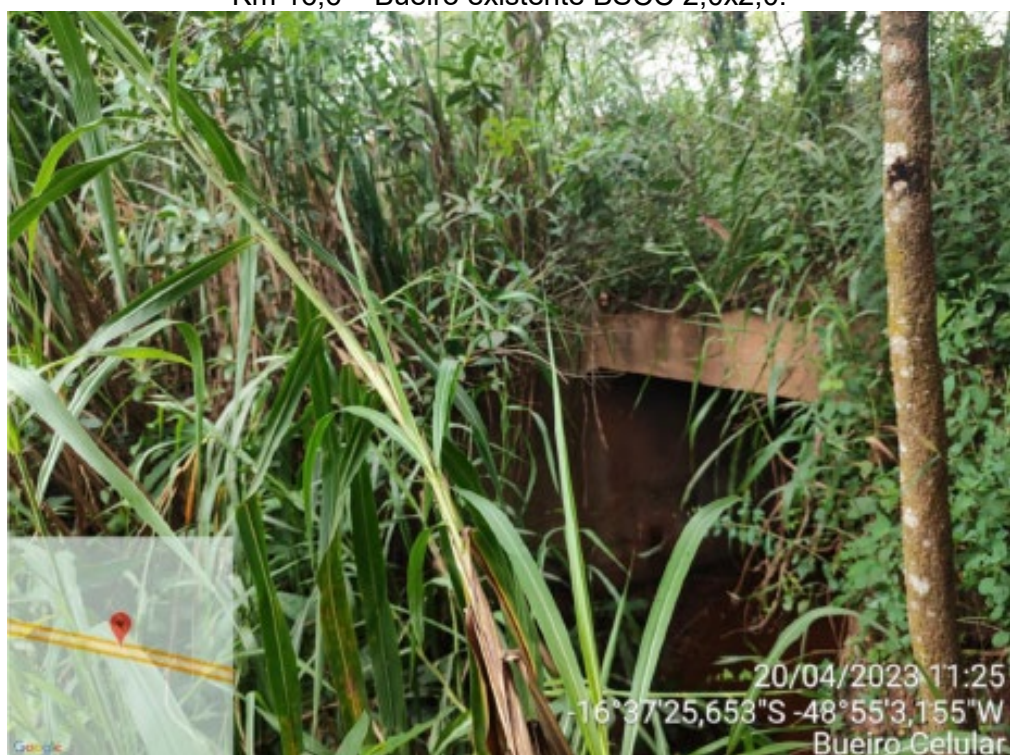
Km 18,6 – Bueiro existente BSCC 3,0x3,0.
