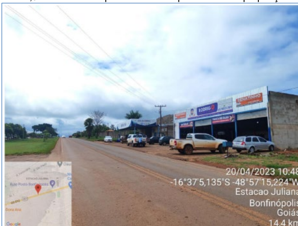
Km 14,4 – Pista com largura de 24,10 metros.
