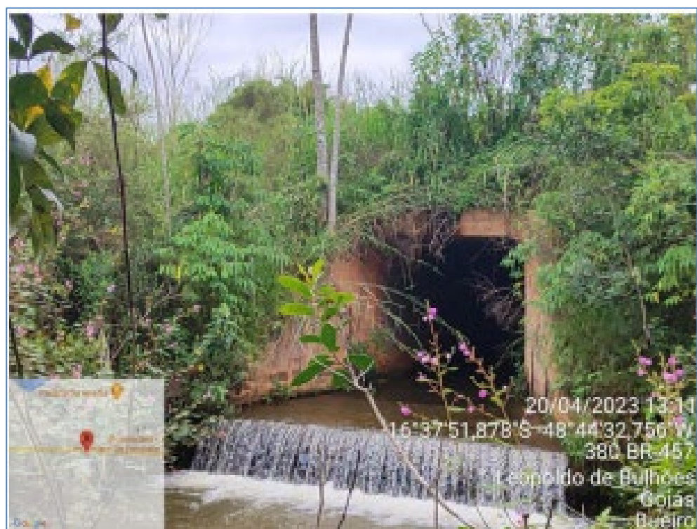
Km 38,1 - Bueiro existente BSCC 2,0x2,0.
