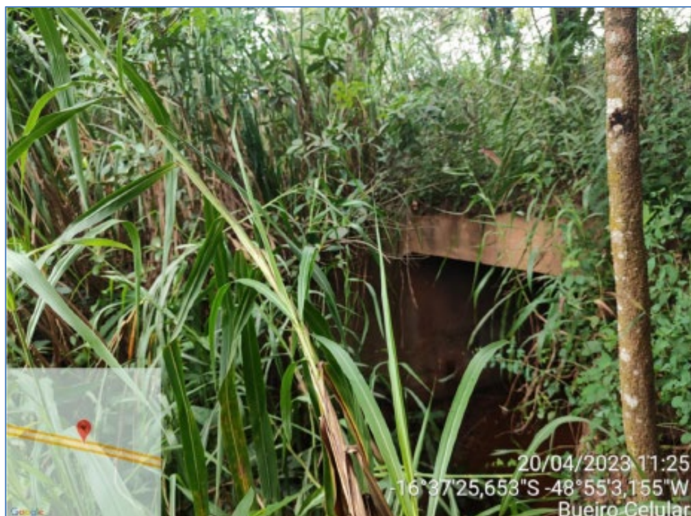
Km 18,6 – Bueiro existente BSCC 3,0x3,0.
