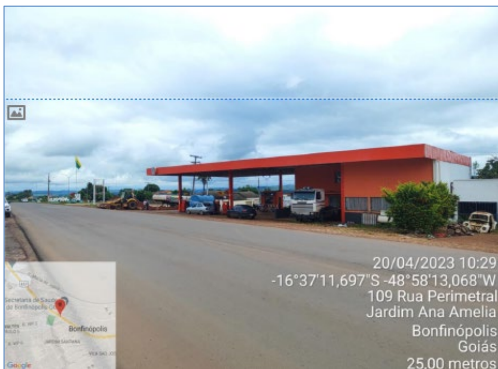
Km 12,5 – Largura da pista 25,00 metros.
