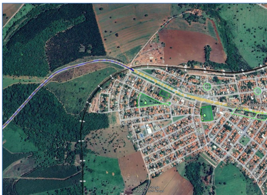
Final - Ferrovia Centro Atlântica (FCA) Ferrovia Norte Sul, início do perímetro urbano de Bonfinópolis.
