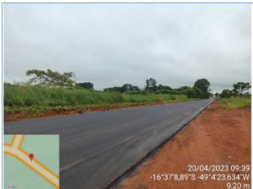
Km 0,40 - Largura da pista existente 9,20 metros, recém restaurada.
