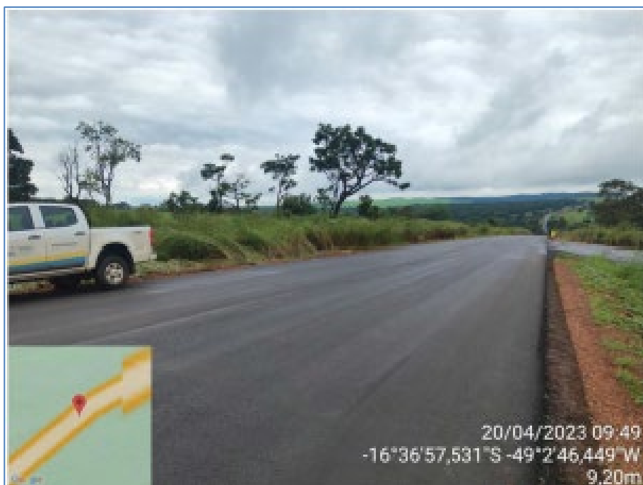
Km 3,8 - Largura da pista existente 9,20 metros, recém restaurada.
