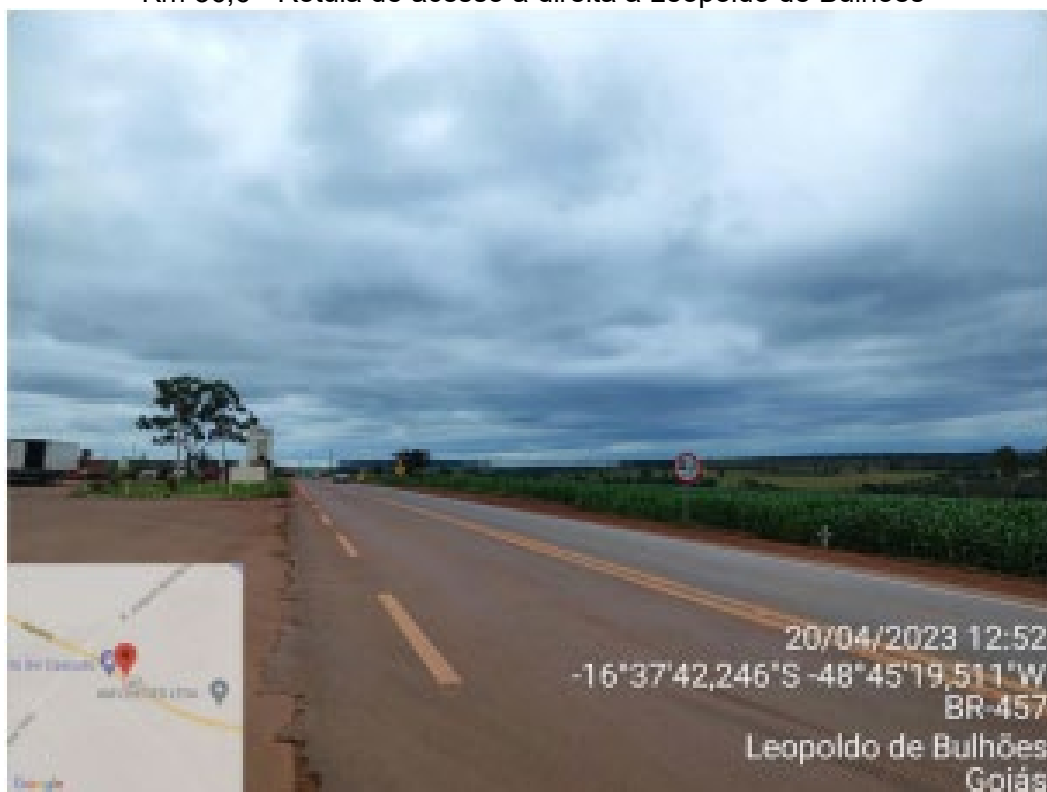
Km 36,9 - Largura da pista 9,30 m.
