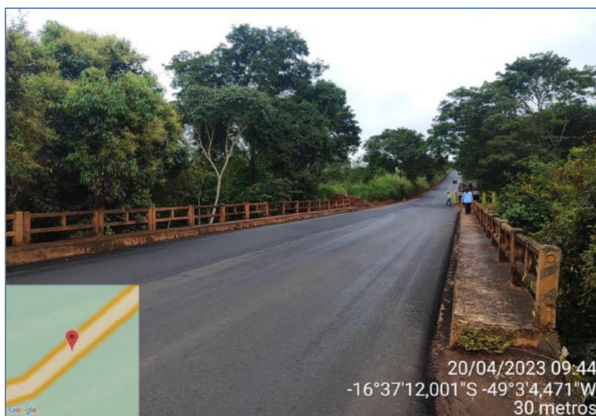
Km 3,1 – Km Ponte sobre o Córrego - 2 irmãos.
