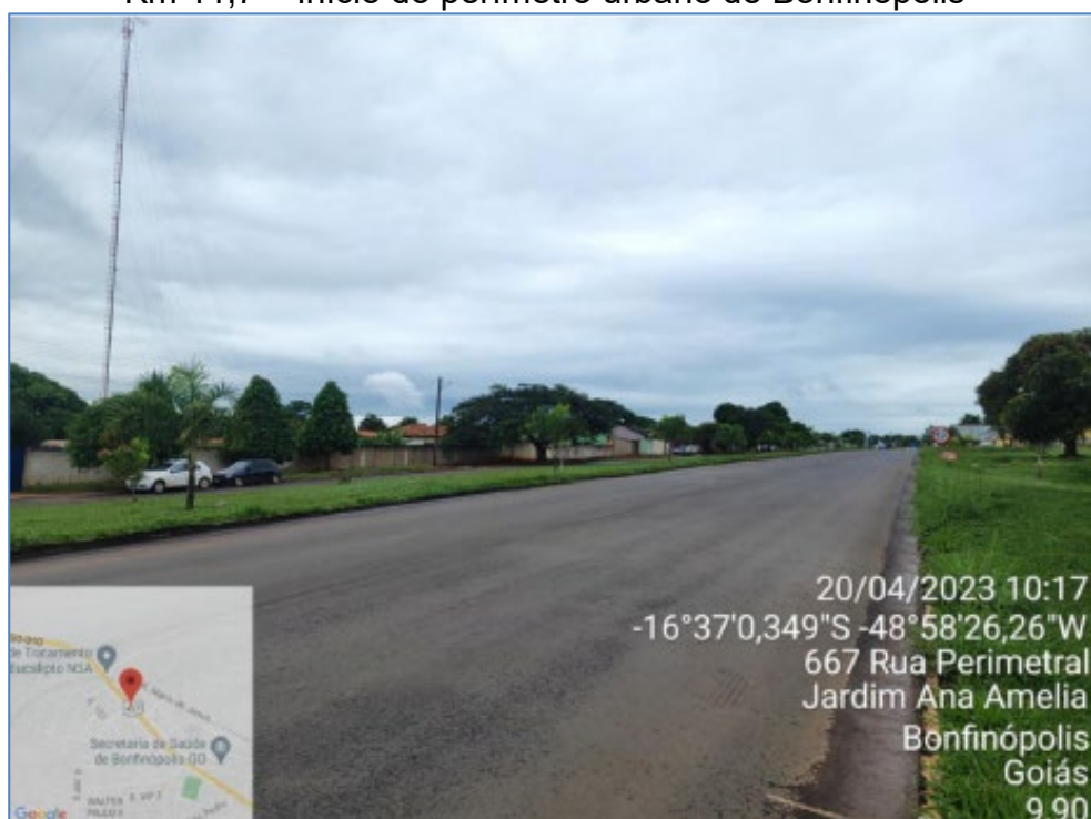
Km 12,5 – Largura da pista 9,90 metros existente recém restaurada.
