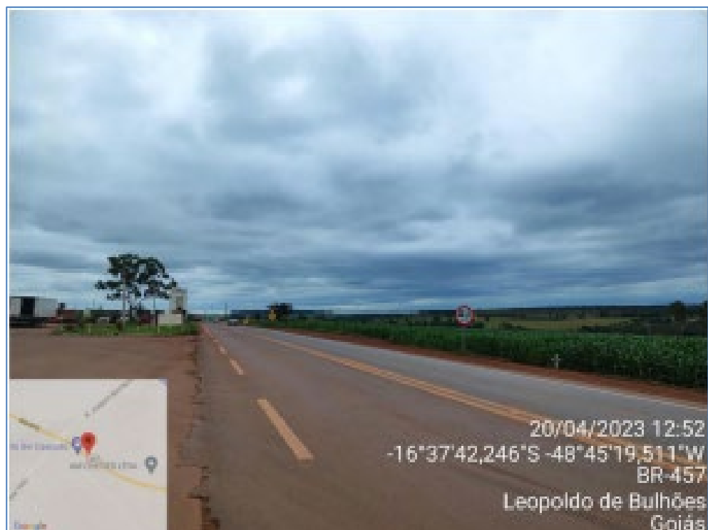
Km 36,9 - Largura da pista 9,30 m.
