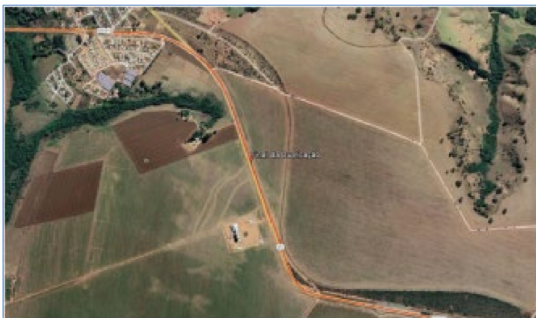
Localização do final do Trecho 04 da GO-010, final da duplicação da GO-010.
