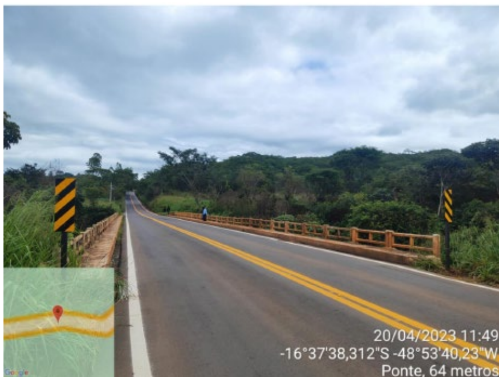
Km 21,2 – Ponte de Concreto Armado com 64 metros.
