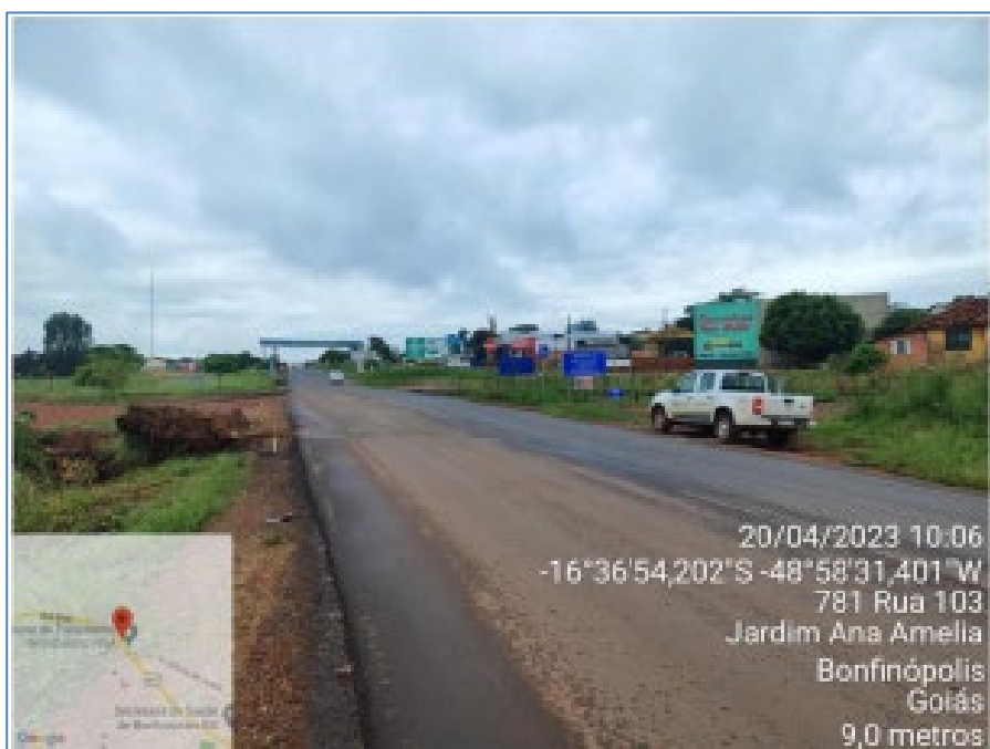
Km 11, 7 - Ferrovia Centro Atlântica (FCA) Ferrovia Norte Sul, início do perímetro urbano de Bonfinópolis.
