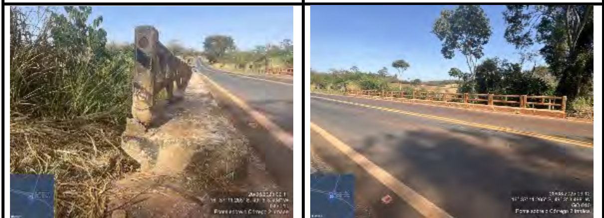
Figura 31. PONTE SOBRE O CÓRREGO DOIS IRMÃOS
