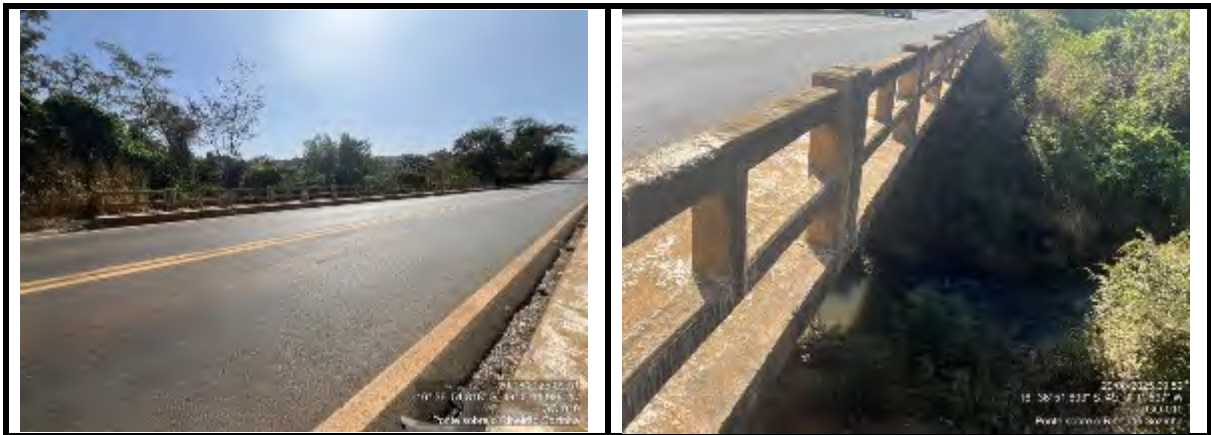
Figura 36. PONTE SOBRE O RIBEIRÃO SOZINHA
