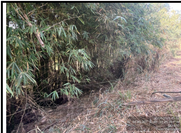
Figura 23. ACESSO AO BUEIRO (BSCC 2x2)
