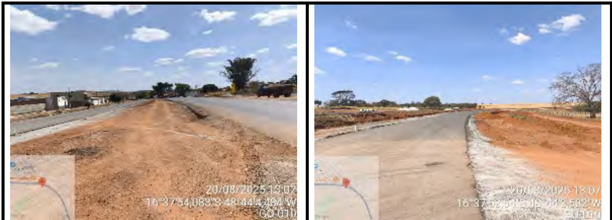
Figura 28. OBRA EM EXECUÇÃO – CONSTRUÇÃO DE TREVO NO FINAL DO PERÍMETRO URBANO DE LEOPOLDO DE BULHÕES
