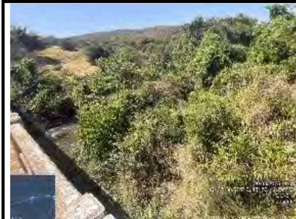
Figura 48. PONTE SOBRE O RIO CALDAS (TRECHO BONFINÓPOLIS / LEOPOLDO DE BULHÕES) JUSANTE
