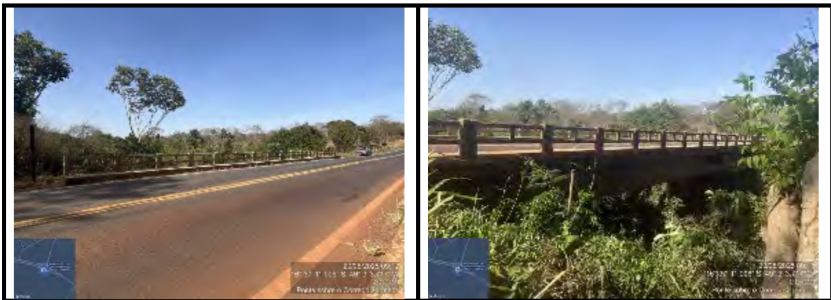
Figura 32. PONTE SOBRE O CÓRREGO DOIS IRMÃOS
