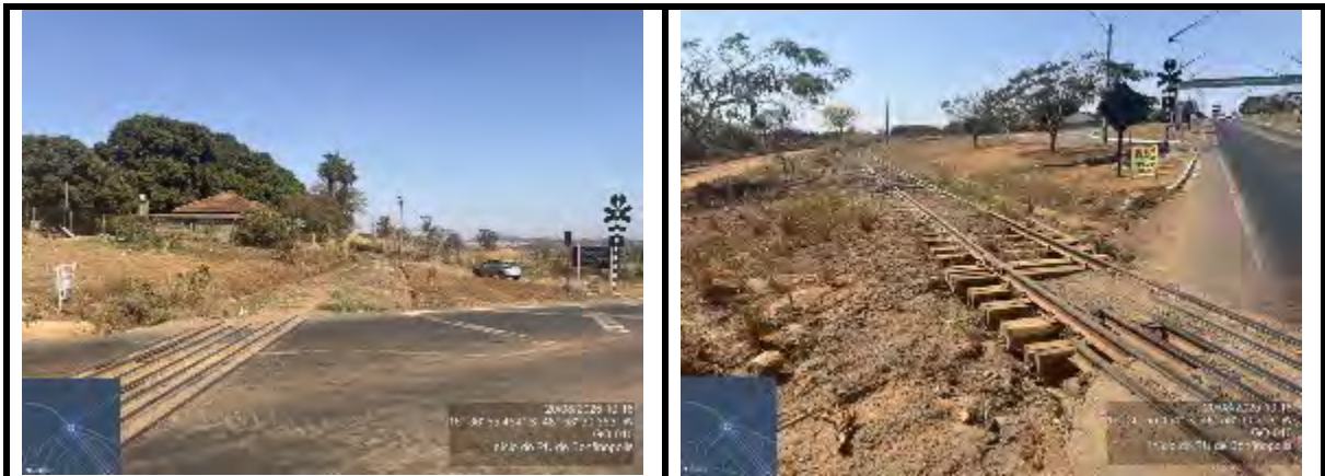
Figura 7. LINHA FÉRREA CRUZAMENTO EM NÍVEL
