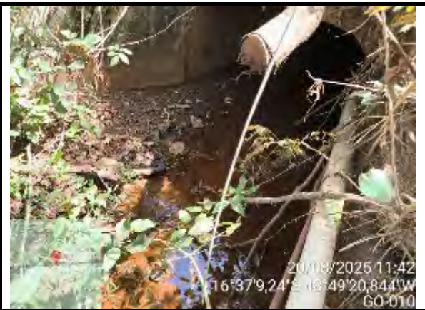
Figura 43. BUEIRO SIMPLES CELULAR DE CONCRETO NO PADRÃO 2 X 2 VISTA INTERNA
