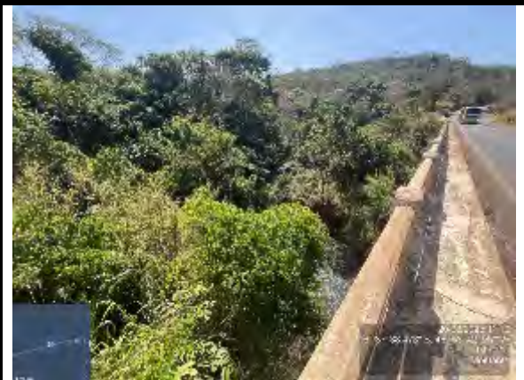
Figura 49. PONTE SOBRE O RIO CALDAS (TRECHO BONFINÓPOLIS / LEOPOLDO DE BULHÕES) MONTANTE.
