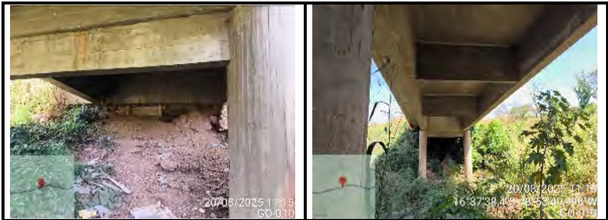
Figura 47. PONTE SOBRE O RIO CALDAS (TRECHO BONFINÓPOLIS / LEOPOLDO DE BULHÕES) VISTA INFERIOR
