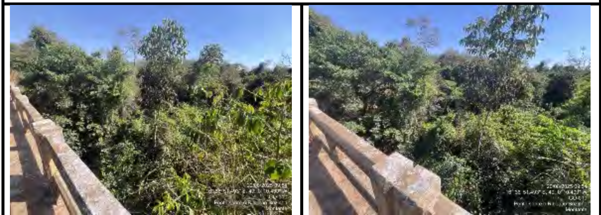
Figura 38. PONTE SOBRE O RIBEIRÃO SOZINHA (MONTANTE)
