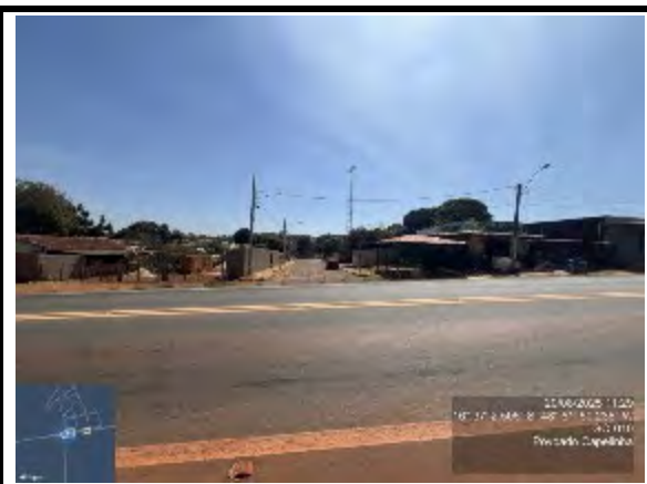
Figura 22. TRAVESSIA IRREGULAR DE PEDESTRE
