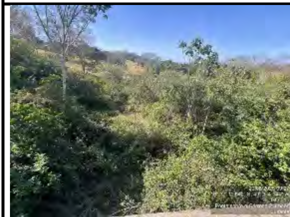
Figura 33. PONTE SOBRE O CORRÉGO DOIS IRMÃO (JUSANTE)
