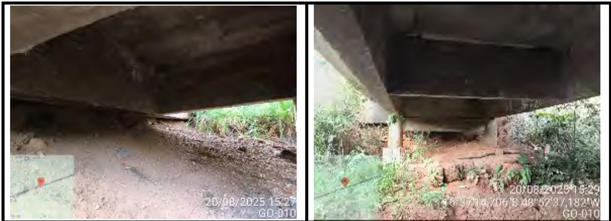
Figura 51. PONTE PROXIMA AO POVOADO DE CAPELINHA VISTA DA PARTE INFERIOR DA PONTE.
