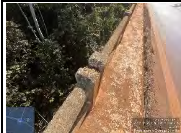
Figura 35. PONTE SOBRE O CORRÉGO DOIS IRMÃO PPRESENÇA DE FISSURAS ENTRE A OAE E O ENCABEÇAMENTO NOS QUATRO CANTOS.
