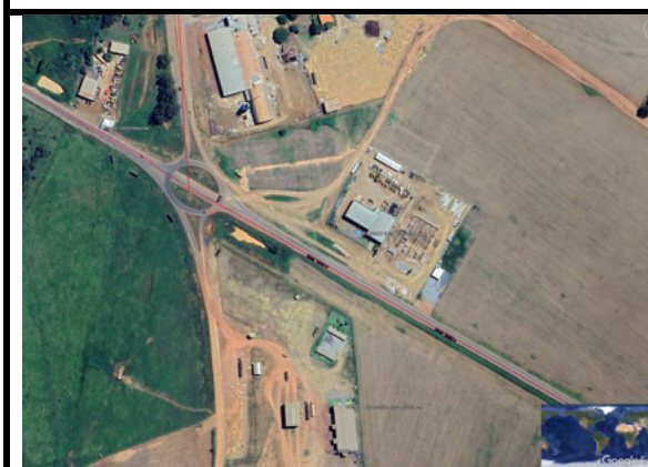
Figura 12. DO PONTO DE VISTA DE ENGENHARIA VIÁRIA, A GEOMETRIA ATUAL DA ROTATÓRIA ABERTA NÃO ATENDE PLENAMENTE À DEMANDA DO TRÁFEGO PESADO E AO CRESCIMENTO DO USO DA REGIÃO.
