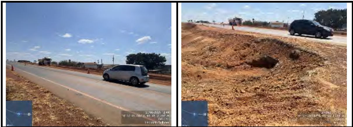
Figura 25. OBRA EM EXECUÇÃO NO PU DE LEOPOLDO DE BULHÕES
