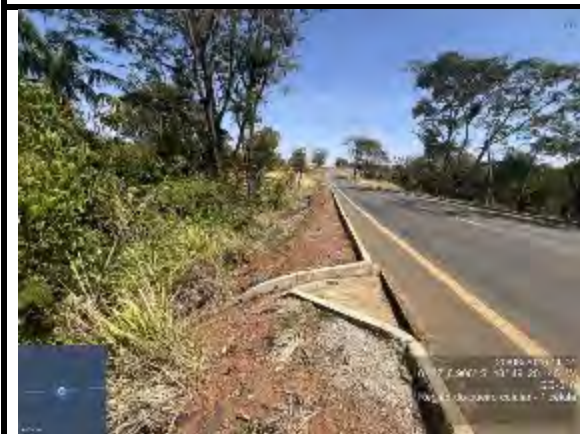
Figura 41. BUEIRO SIMPLES CELULAR DE CONCRETO NO PADRÃO 2 X 2 VISTA EXTERNA RODOVIA
