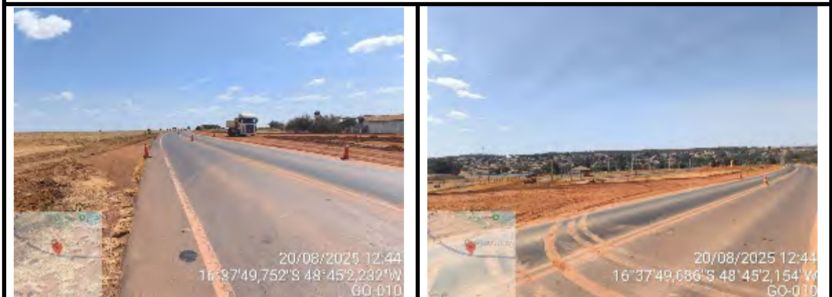
Figura 27. ACESSO A GALPÃO (IDENTIFICADO COMO ARMAZÉM)
