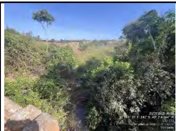
Figura 34. PONTE SOBRE O CORRÉGO DOIS IRMÃO (MONTANTE)
