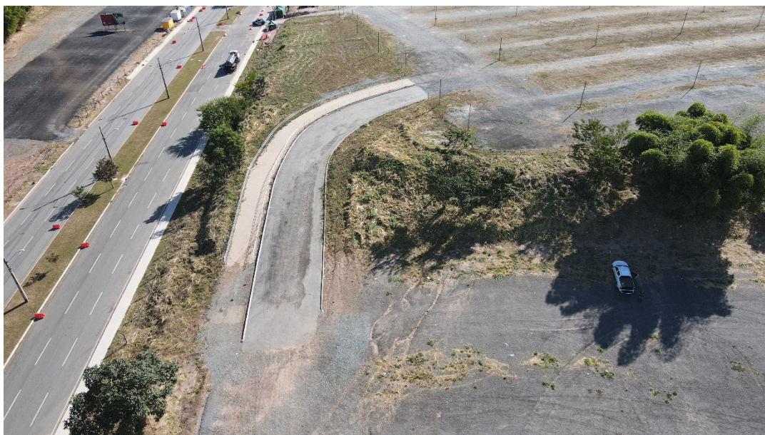
Imagem 9. RAMPA – Interligação da Área 01 e 02.
