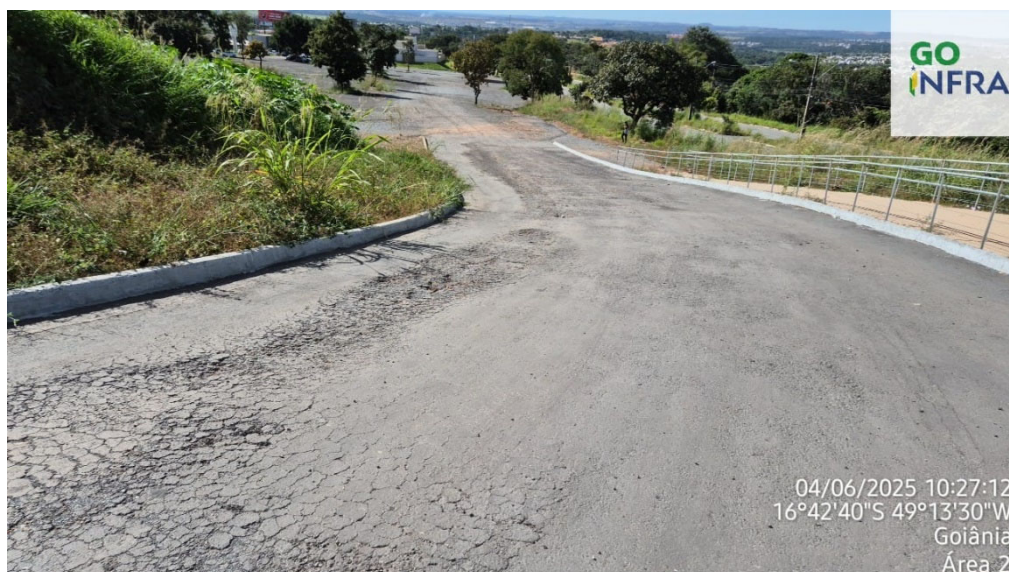
Imagem 15. Rampa da ÁREA 01
