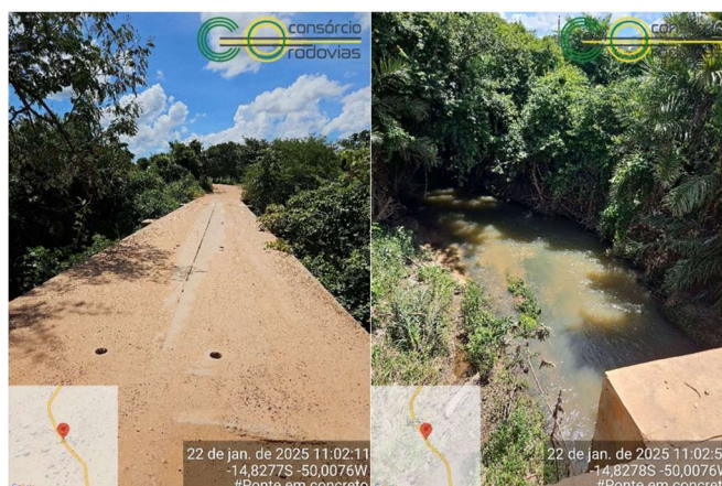
Figura 8 Ponte de Concreto existente 40 m de extensão.
