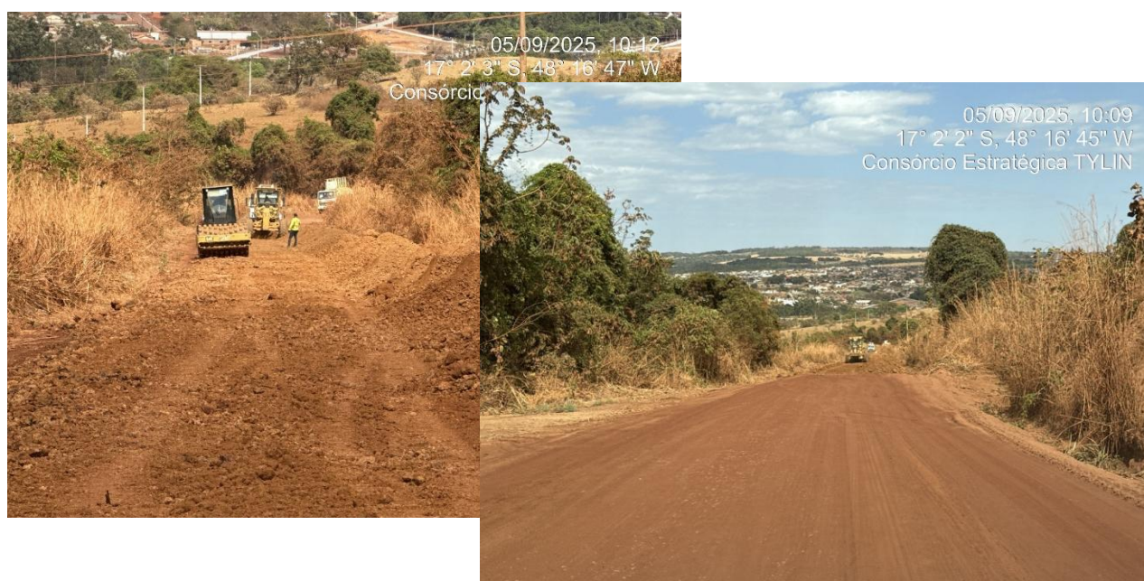
Figura 8 — Trecho do Lote I da GO-219, com trabalhos de manutenção
