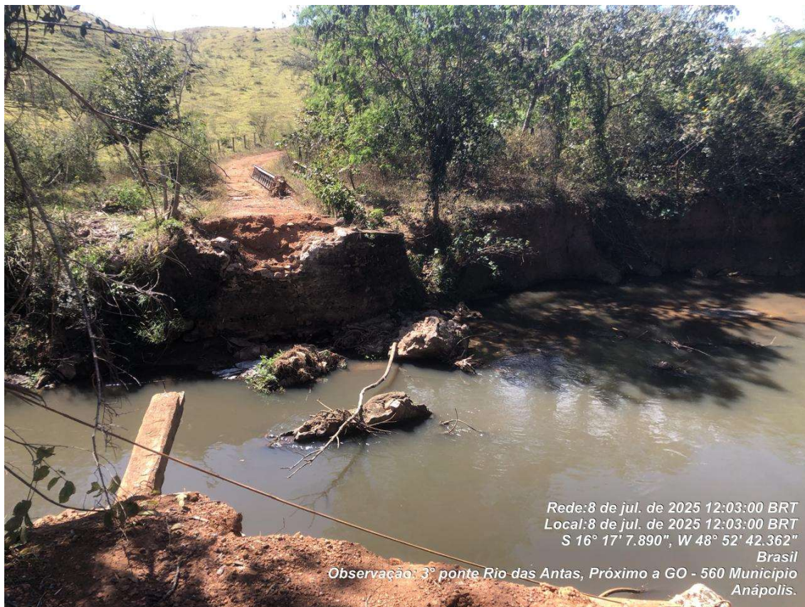
Figura 2 – Vistoria na Ponte sobre o Rio das Antas
