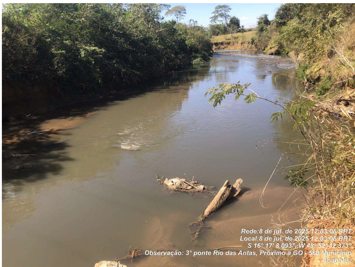
Figura 3 – Vistoria na Ponte sobre o Rio das Antas
