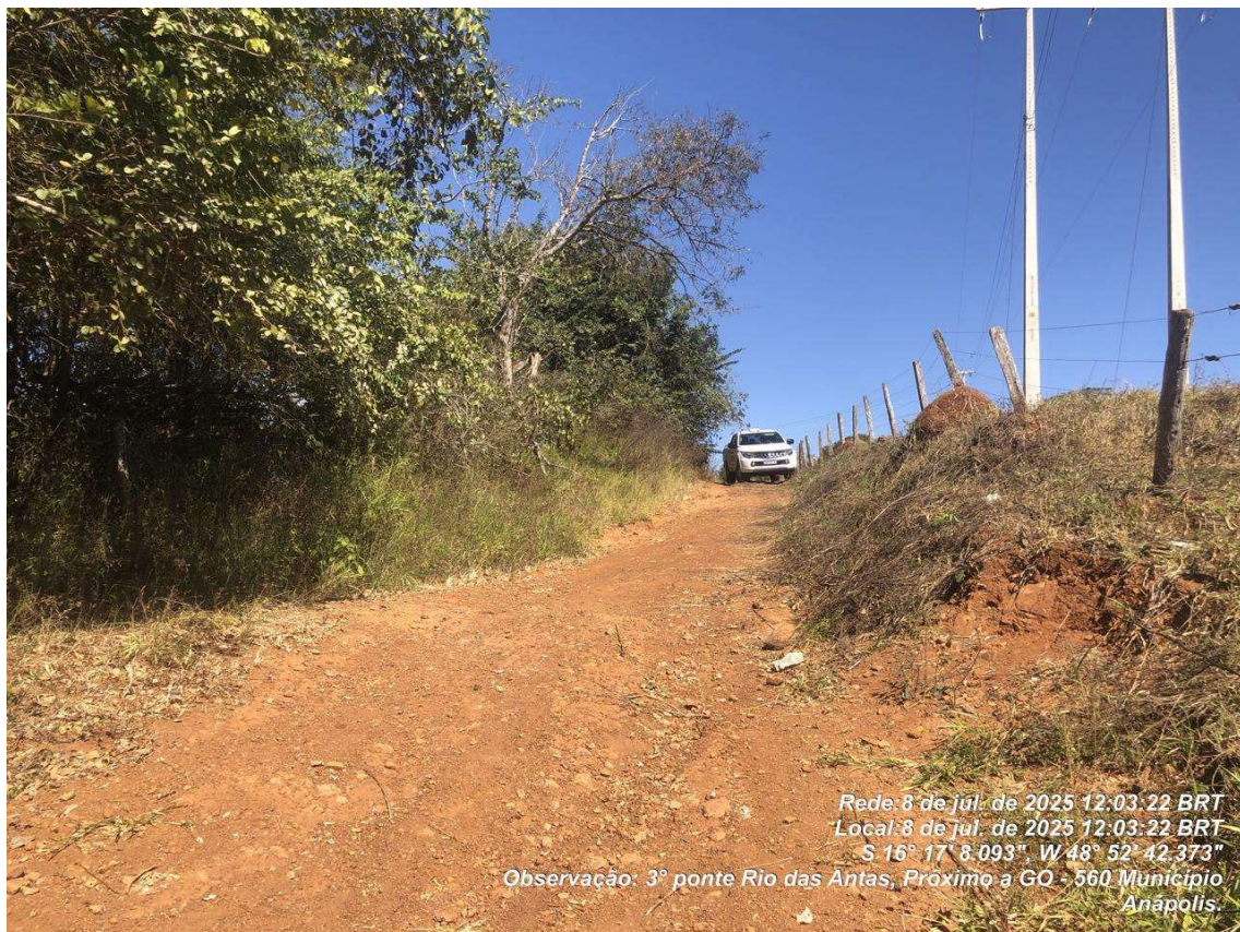
Figura 4 – Vistoria na Ponte sobre o Rio das Antas
