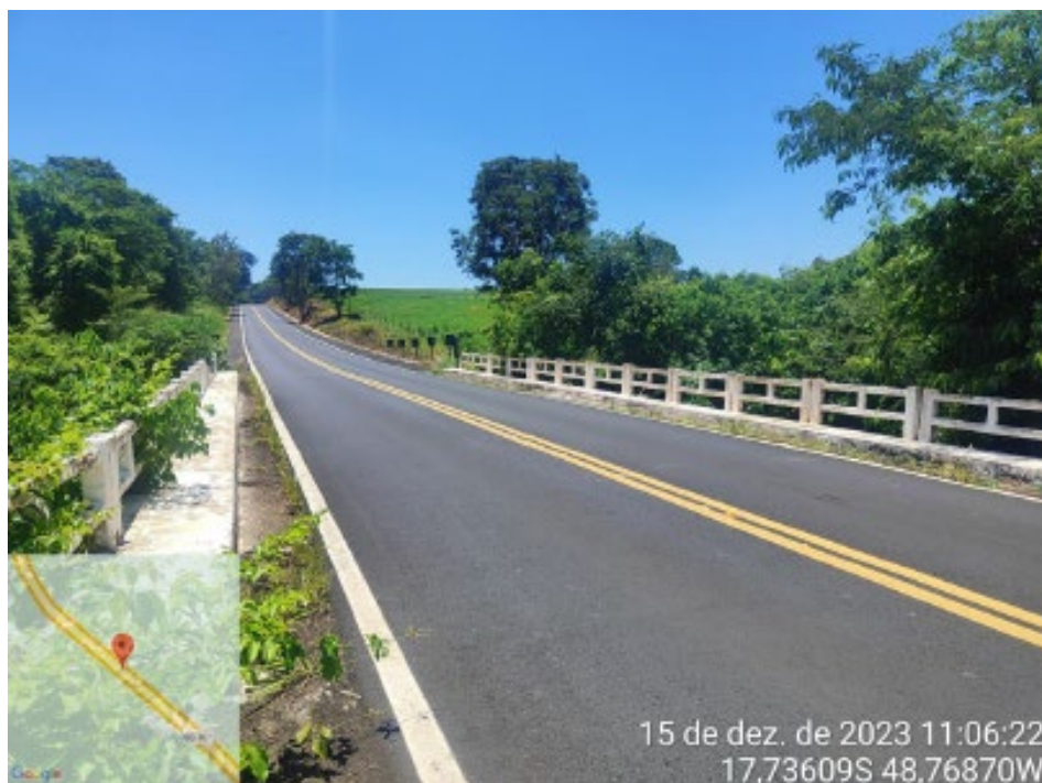
Km 10,00 – Ponte em Concreto Armado – 27,00 x 8,10m. Km 11,60
