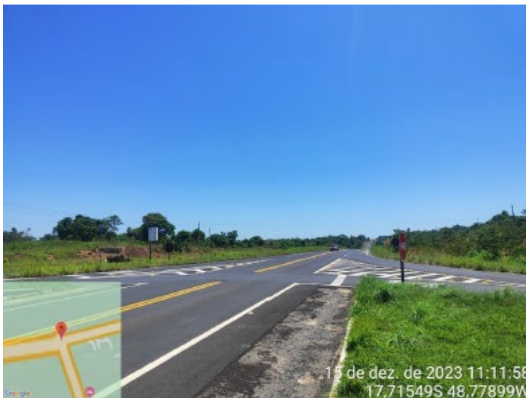
Km 12,60 – Fim - GO-507, Trecho: Fim do Perímetro Urbano (Rio Quente) - Entr. Br-490/ GO-213.
