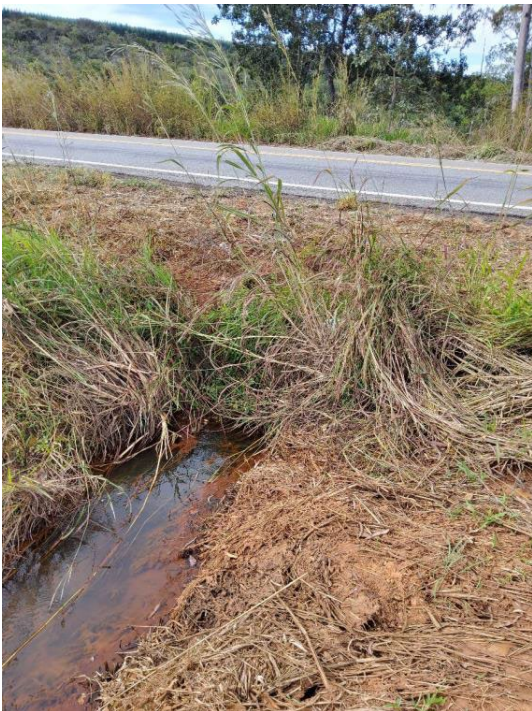
km 15.8 – Bueiro tubular.
