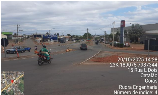
FOTO 1: km 0,00 - Início do Trecho
