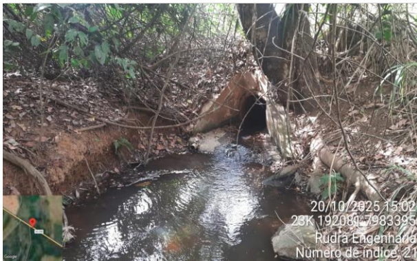
FOTO 9: km 5,38 - Jusante Bueiro BSTC Ø0,60
