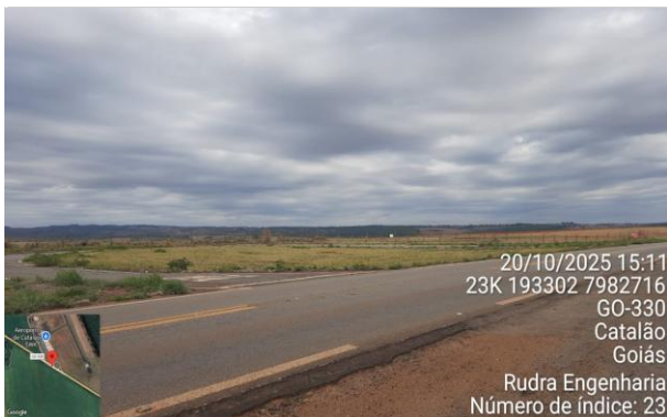
FOTO 11: km 6,60 - Acesso à Pista de Pouso (LE)
