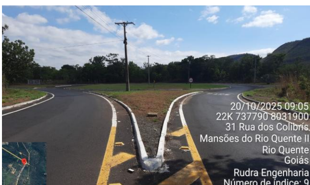
FOTO 11: km 1,60 - Rotatória 01 - Poste no centro da ilha
