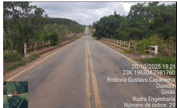
FOTO 14: km 9,90 - PCA - C=40,00m / L=7,00m / H=8,00m / Guarda Corpo 0,75m - Ribeirão Ouvidor
