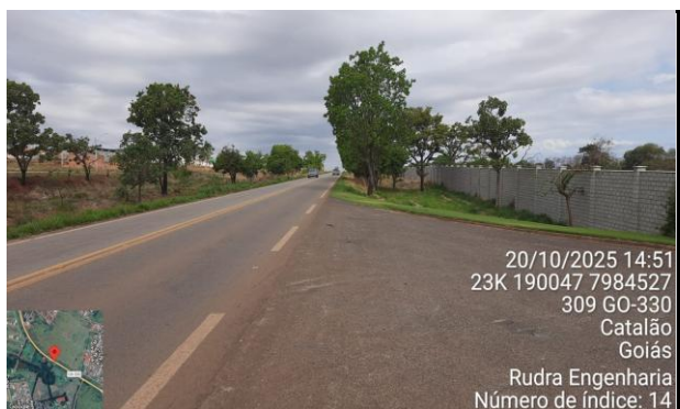
FOTO 6: km 2,90 - Entrada Condomínio Haras BBF - Km 309
