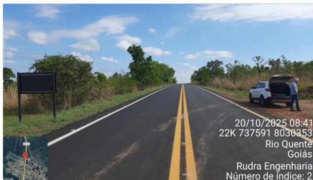
FOTO 2: km 0,00 - Vista - Pista: 7,40m / Acostamento 0,80m
