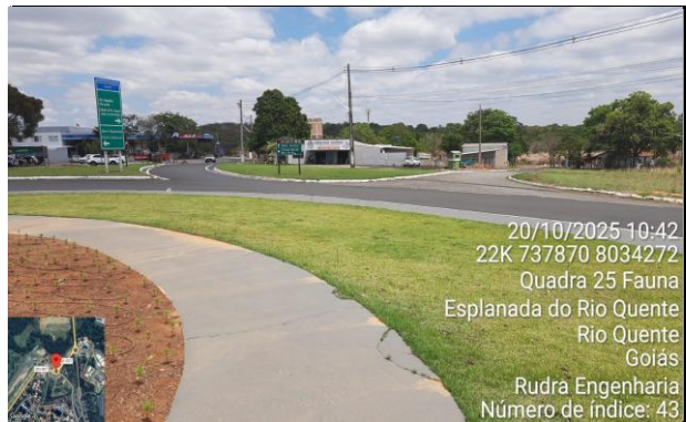
FOTO 33: km 5,05 - Rotatória 04 - Entrada para pista de pouso
