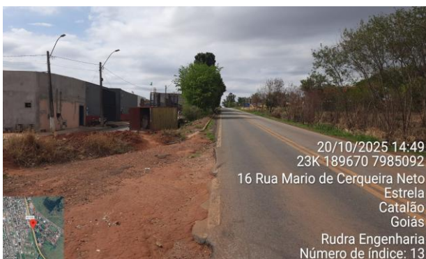
FOTO 5: km 2,30 - Vista Sentido: Catalão - Final Marginal Direita
