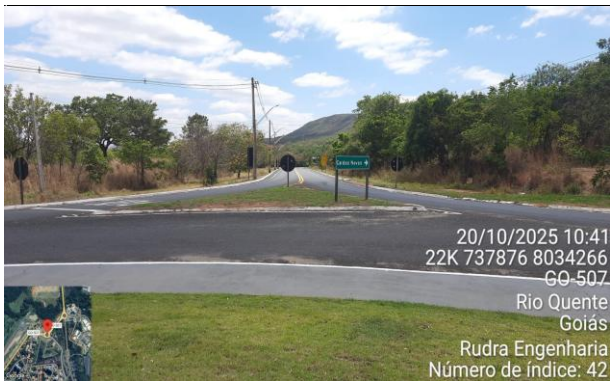
FOTO 32: km 5,05 - Rotatória 04 - Vista Sentido: Caldas Novas
