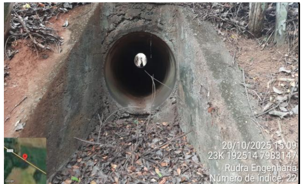
FOTO 10: km 5,80 - Bueiro BSTC Ø0,80
