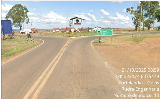
FOTO 13: km 4,10 - Vista - Interseção BR-364
