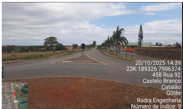
FOTO 4: km 0,95 - Vista Sentido: Catalão
