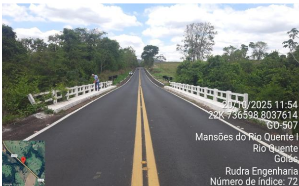
FOTO 46: km 8,90 - PCA (Comp.27,00m x Larg. 10,00m x Alt.10,00m)
