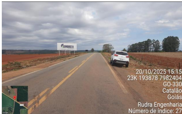
FOTO 13: km 7,30 - Vista - GO-330 - Pista 7,00m / Acostamento 0,80m
