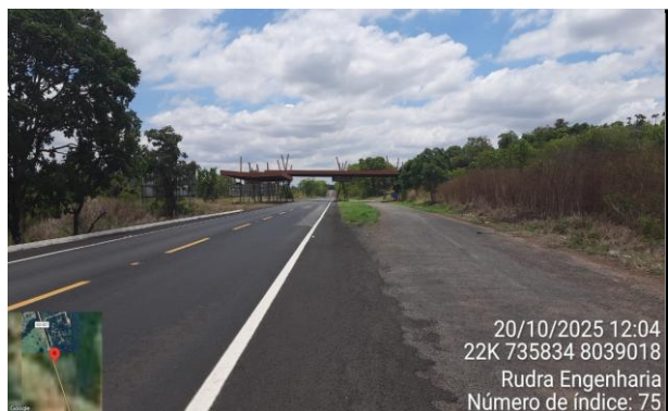
FOTO 49: km 10,70 - Pórtico Metálico - Portal Pousada do Rio Quente
