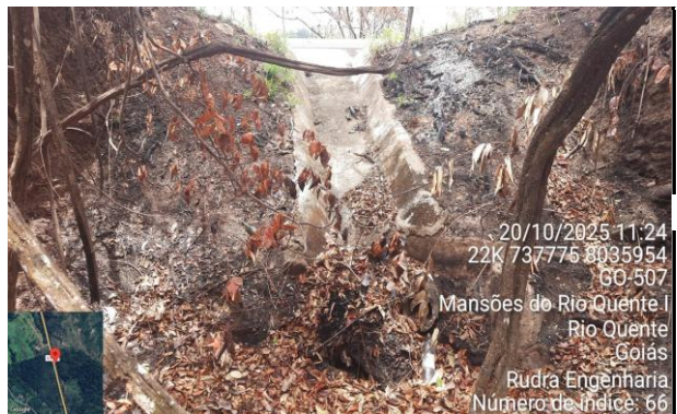
FOTO 41: km 6,87 - BSTC Ø0,60m - MD (Entupido)
