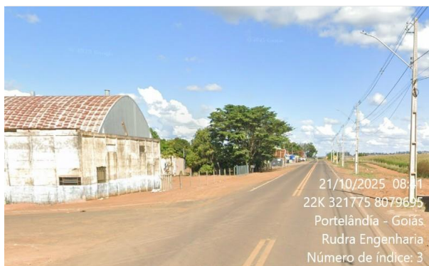
FOTO 3: km 0,10 - Galpão-Silo (LE) / Rede Elétrica (LD)
