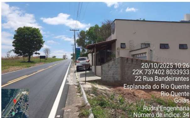
FOTO 28: km 4,50 - Empório / Casa (LD)
