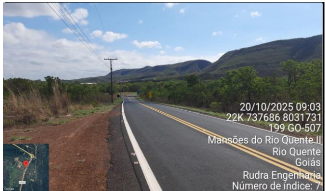
FOTO 8: km 1,30 - Vista - Rede elétrica LE
