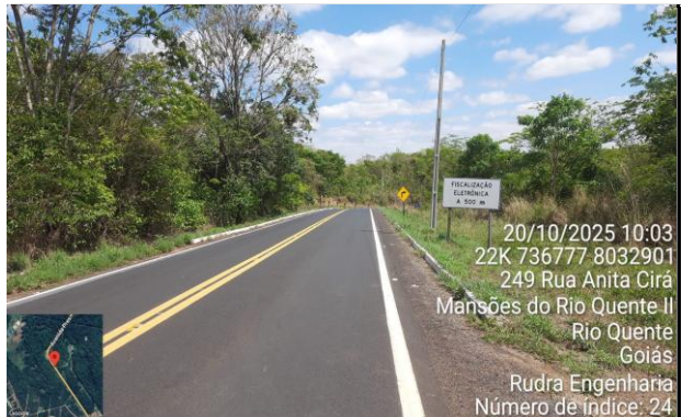
FOTO 21: km 3,10 - Vista - Linha de transmissão (LD)
