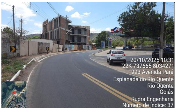
FOTO 29: km 4,90 - Posto de Combustível (LD)
