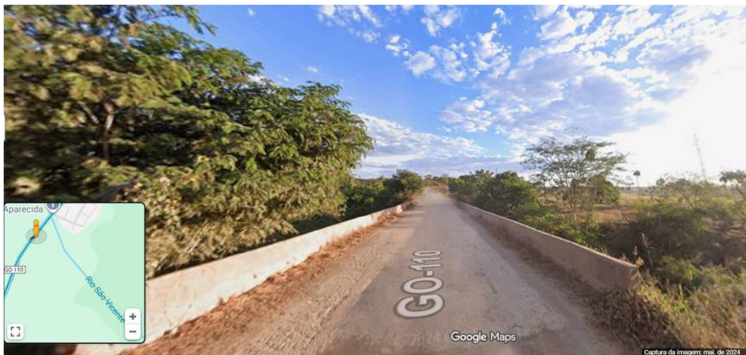
Figura 2: Imagem Street View Google Earth, mai/2024 – Ponte existente sobre o Rio São Vicente.
