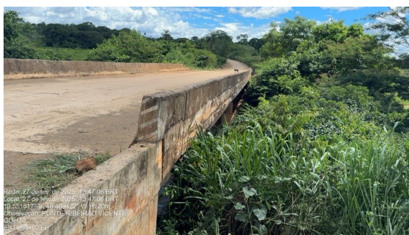
Figura 65 – Vista do tabuleiro, encontro e Ney Jersey na Estaca 904+02 LE.
