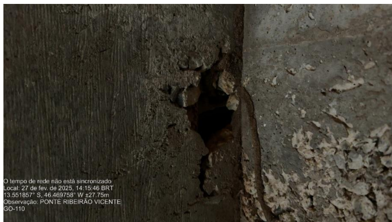
Figura 95 – Junção da Viga longarina 01 e Encontro 01.
