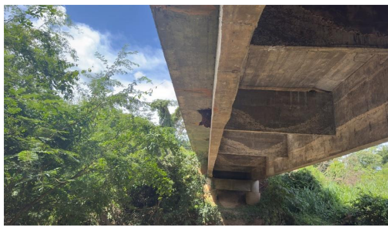
Figura 10 – Vista Ampla da parte inferior da ponte.
