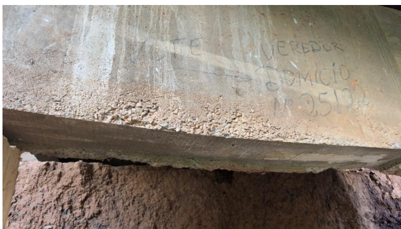
Figura 45 – Nichos de concretagem na Viga Travessa 01.
