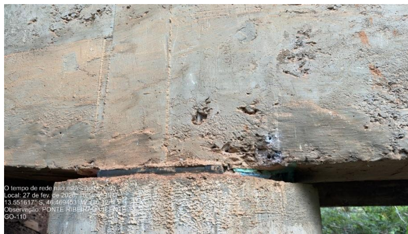
Figura 102 – Nichos de concretagem na viga longarina 01 próximo ao Pilar 01.
