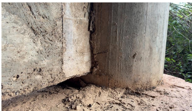
Figura 14 – Encontro da Viga Travessa 02 com o Pilar 03.
