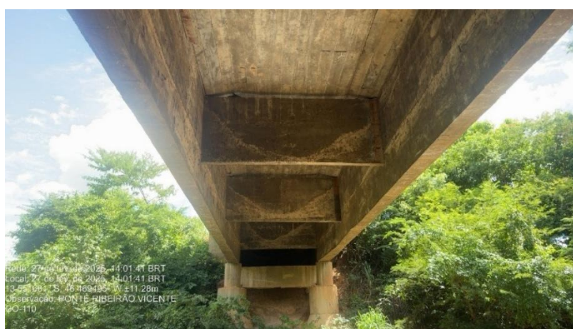
Figura 84 – Vista das Transversinas 03, 02 e 01.
