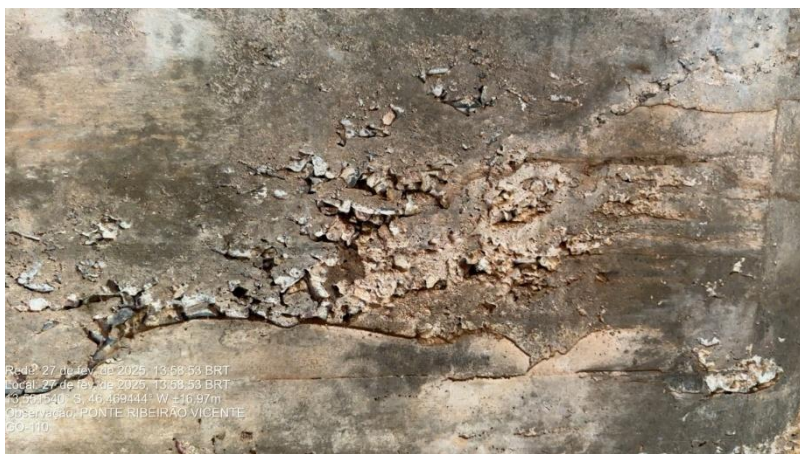
Figura 80 – Detalhes dos nichos de concretagem do Encontro 02.
