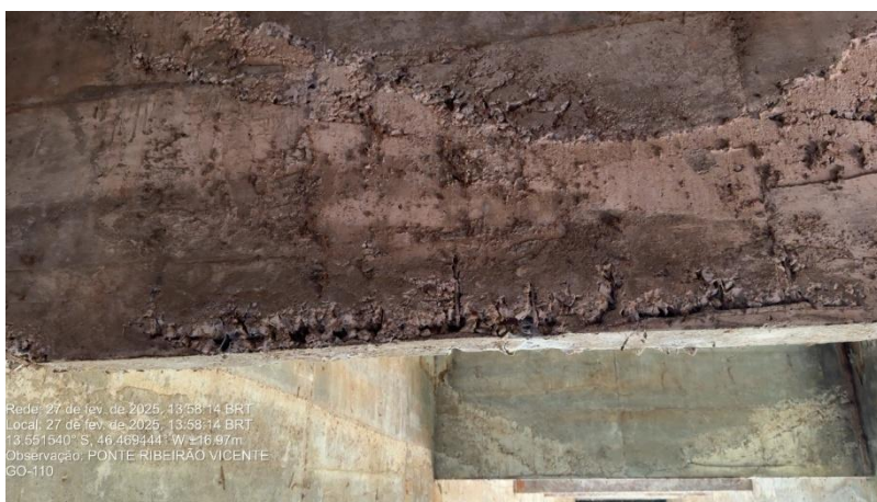
Figura 76 – Vista detalhada dos nichos de concretagem da Transversina 06.
