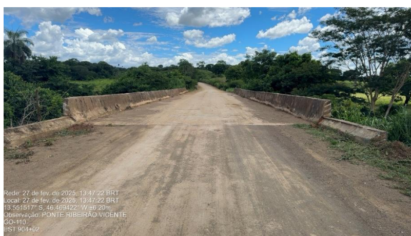
Figura 66 – Vista ampla da ponte Rio São Vicente Estaca. 904+02.
