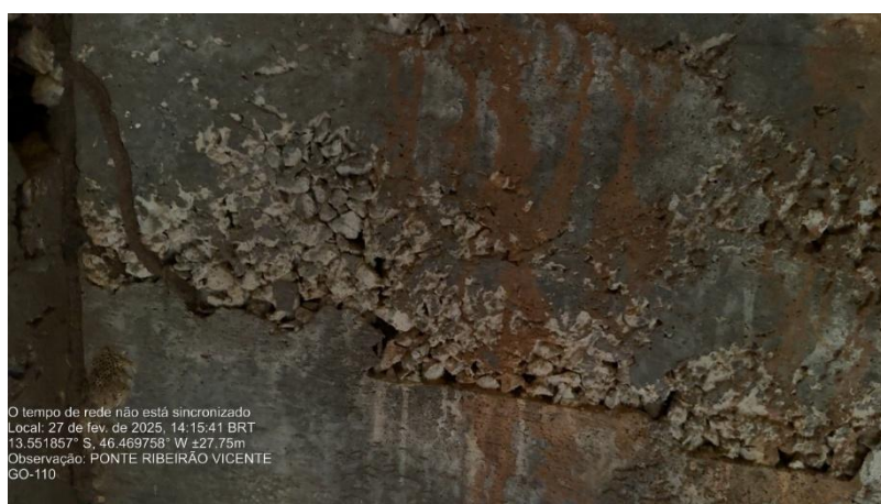
Figura 94 – Detalhes dos nichos de concretagem do Encontro 01.
