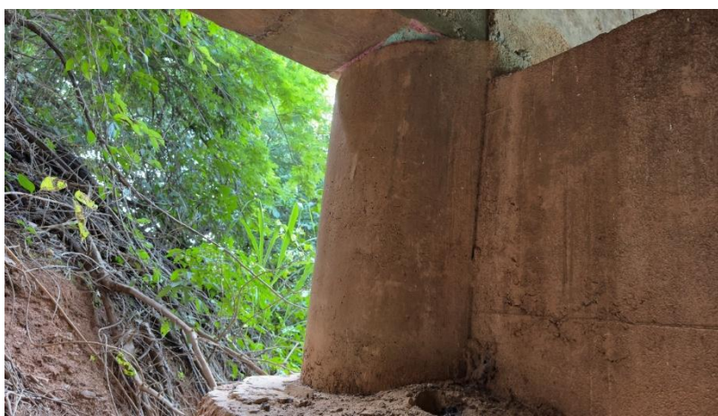
Figura 28 – Vista Ampla do Pilar 2.
