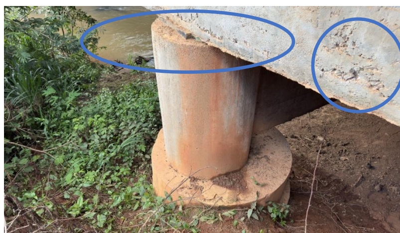
Figura 12 – Vista do Pilar 3 e Longarina 01.
