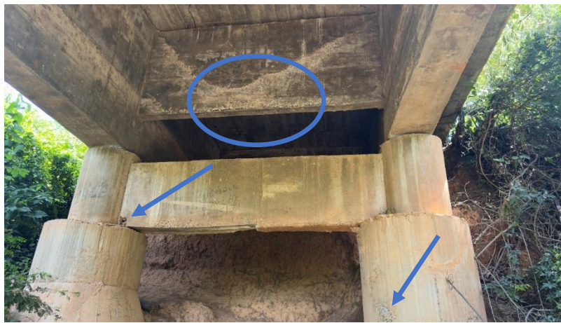
Figura 9 – Vista ampla dos Pilares 1 e 2, viga travessa 1 e transversina 1.
