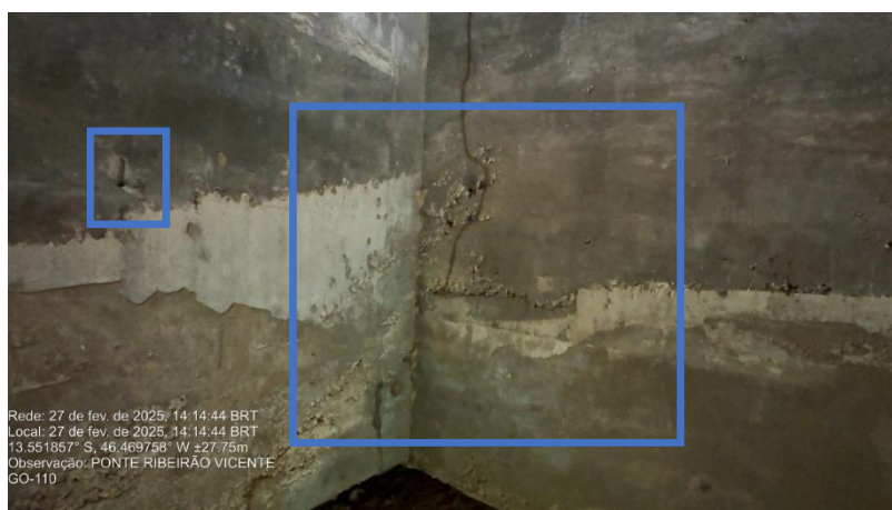
Figura 90 – Nichos de concretagem na Viga Longarina 02 e Encontro 01.
