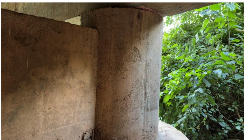
Figura 33 – Vista ampla do Pilar 1.
