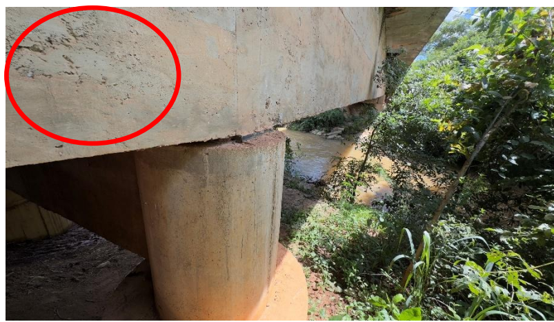
Figura 7 – Vista do Pilar 4 e longarina 2.
