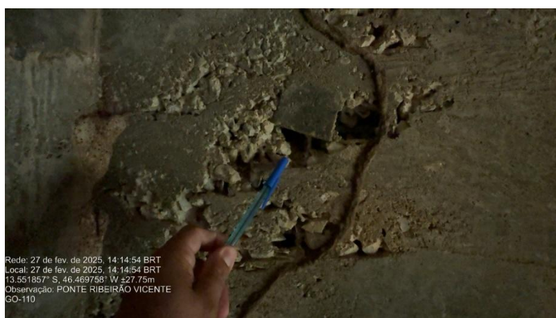
Figura 91 – Detalhes dos nichos de concretagem da Viga Longarina 02.
