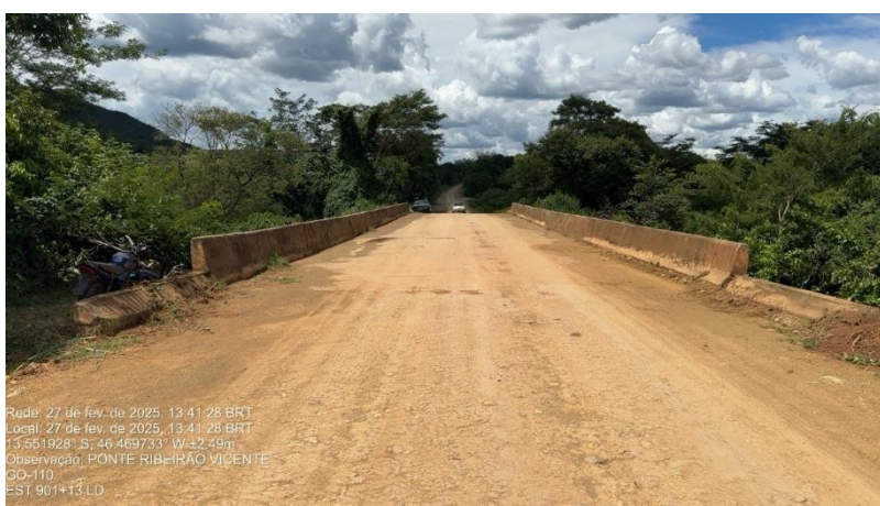
Figura 53 – Vista da ponte Estaca 901+13.
