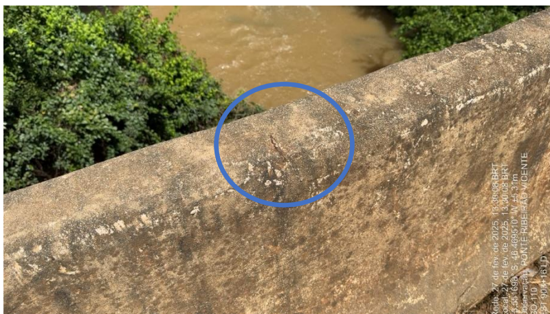
Figura 49 – New Jersey da ponte Estaca 903+16 LD.
