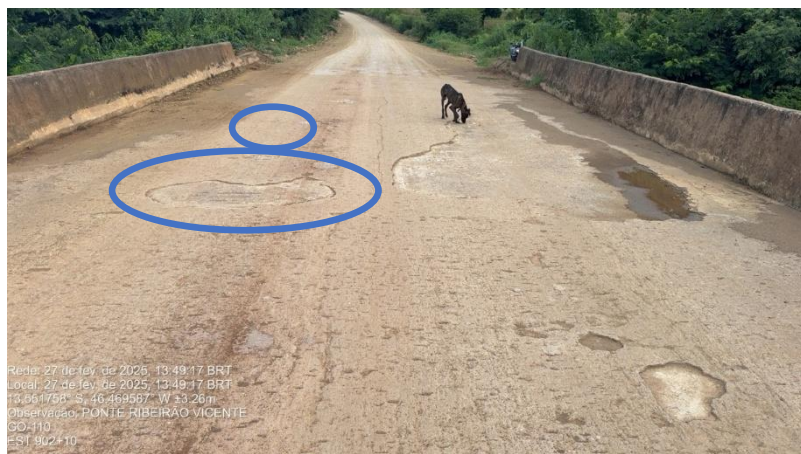
Figura 69 – Laje da ponte estaca 902+10.
