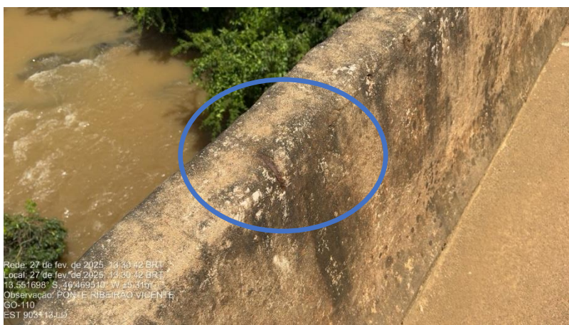
Figura 50 – New Jersey da ponte Estaca 903+13 LD.
