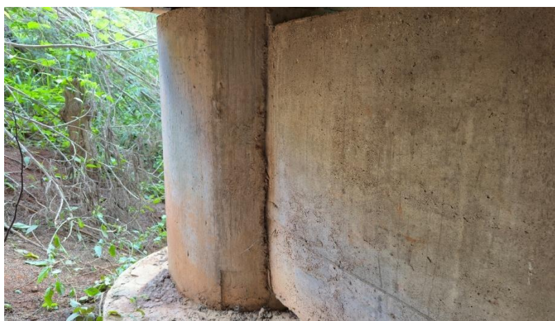
Figura 15 – Encontro da Viga Travessa 2 com o Pilar 4.
