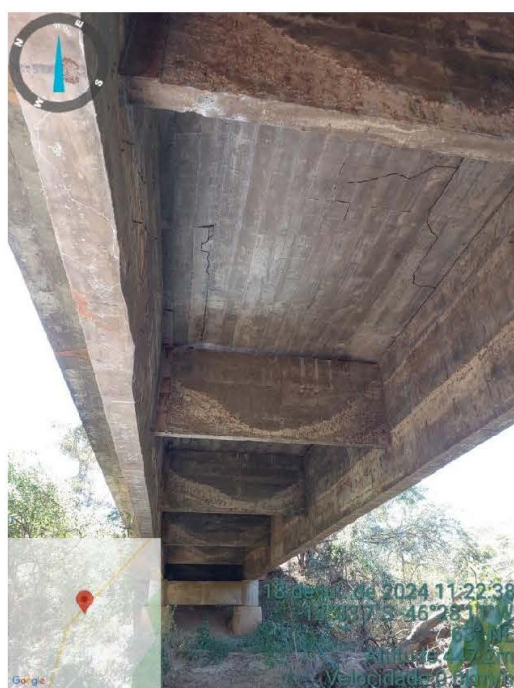
Figura 8 - Laje inferior do tabuleiro da ponte.
