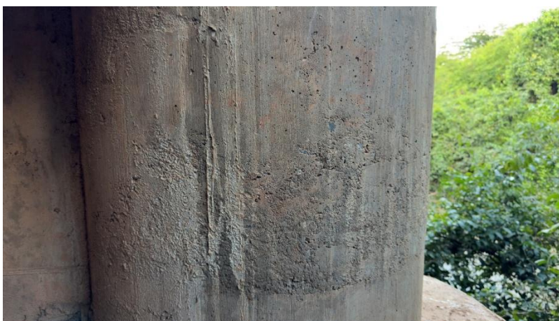
Figura 35 – Vista do Pilar 01.
