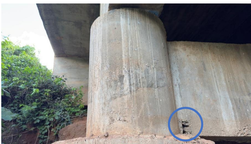
Figura 32 – Vista ampla do Pilar 1 e viga travessa 1.
