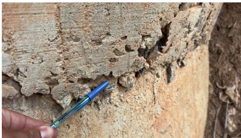
Figura 27 – Detalhes dos nichos de concretagem do Pilar 2.
