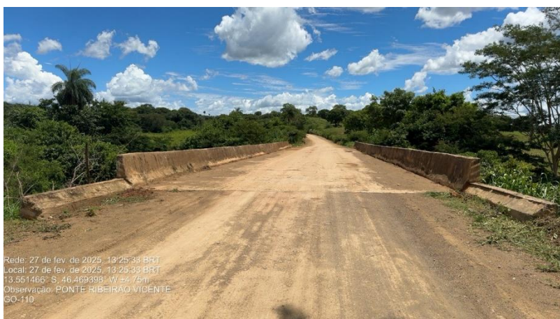
Figura 46 – Vista do tabuleiro da ponte.
