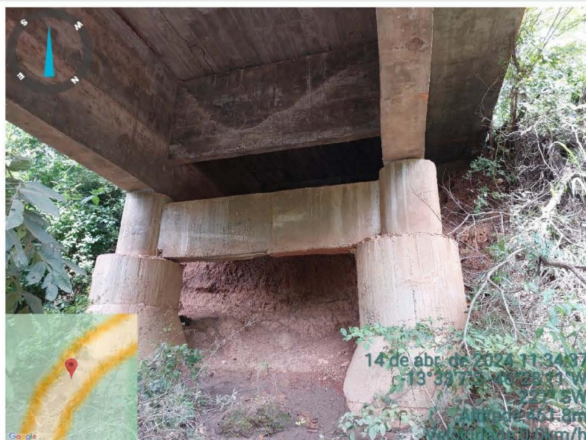
Figura 5 - Foto da infraestrutura da ponte existente.
