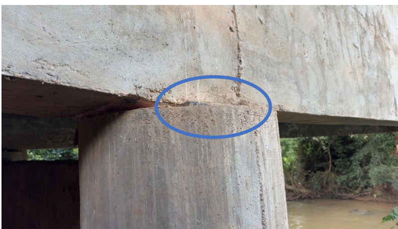
Figura 37 – Vista da manta de Neoprene do encontro Pilar 01 com a viga Longarina 01.
