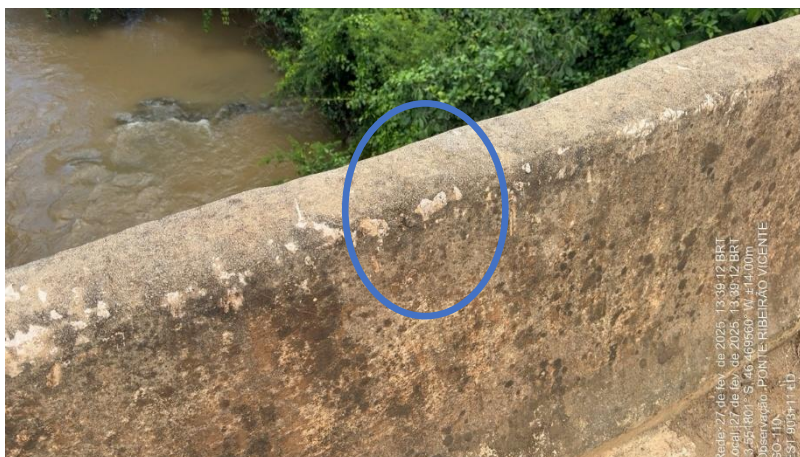
Figura 51 – New Jersey da ponte Estaca 903+11 LD.
