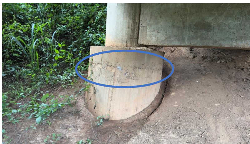
Figura 22 – Vista frontal do tubulão que faz parte do Pilar 4.
