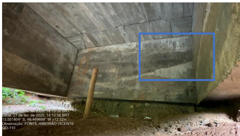
Figura 89 – Encontro 01 apresentando nichos de concretagem.
