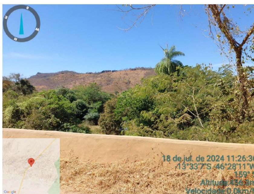
Figura 10 – Barreira de concreto da ponte.
