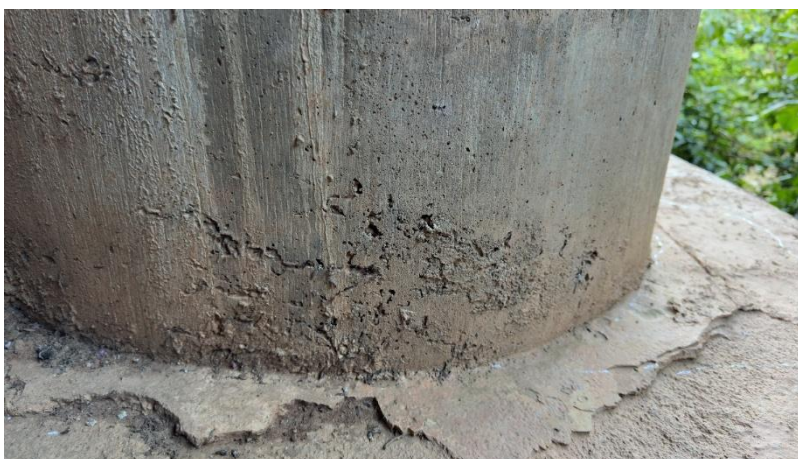
Figura 34 – Detalhes para os nichos de concretagem no Pilar 1.
