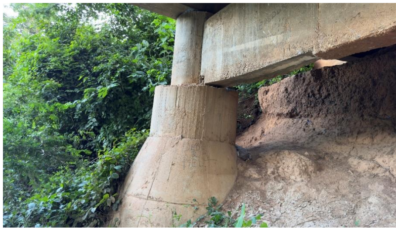
Figura 30 – Vista ampla do Pilar 1 e do tubulão.
