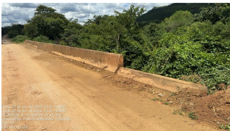
Figura 52 – Vista do tabuleiro, New Jersey e encontro Lado direito.
