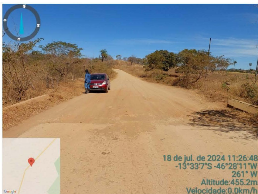
Figura 12 - Encontro da ponte com a via existente.
