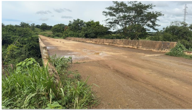
Figura 6 – Vista Ampla da ponte.
