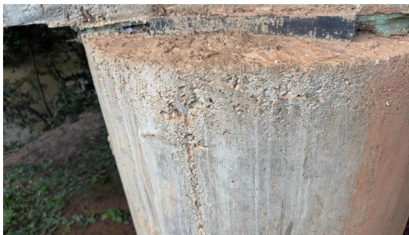
Figura 13 – Vista ampla do Pilar 01 e a manta de Neoprene.
