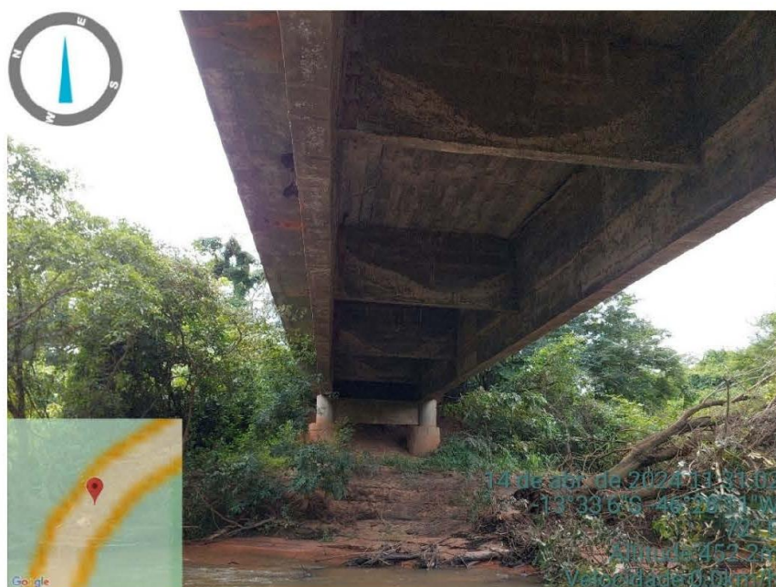
Figura 6 - Foto da margem esquerda do rio sobre a ponte existente.
