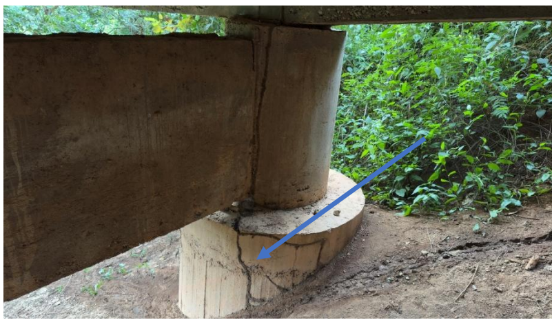
Figura 17 – Vista da Viga Travessa 2 e do Pilar 4.
