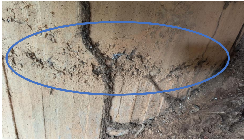
Figura 18 – Detalhes do nicho de concretagem no tubulão abaixo do Pilar 4.
