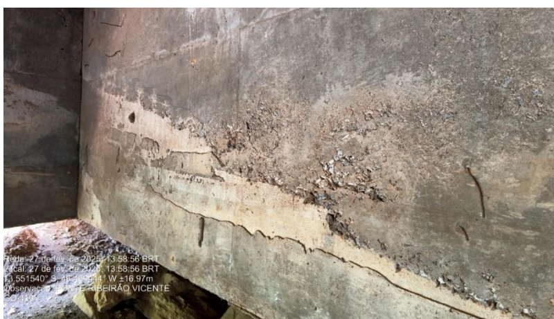
Figura 81 – Detalhes dos nichos de concretagem da Encontro 02.
