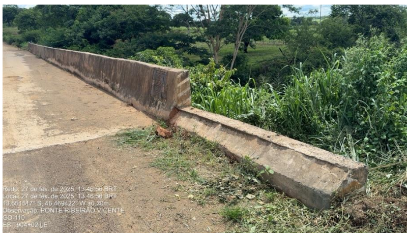
Figura 63 – Vista ampla do New Jersey Estaca 904+02 LE.
