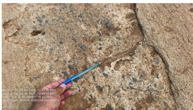
Figura 71 – Laje de concreto da ponte, Estaca 902+10.
