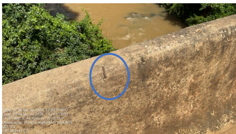
Figura 48 – New Jersey da ponte Estaca 903+17 LD.
