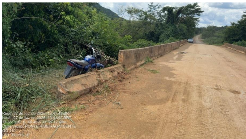
Figura 54 – Vista do tabuleiro, New Jersey e encontro lado esquerdo.
