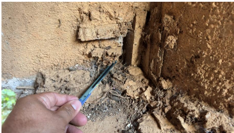
Figura 44 – Encontro da viga Travessa 01 com o Pilar 01.
