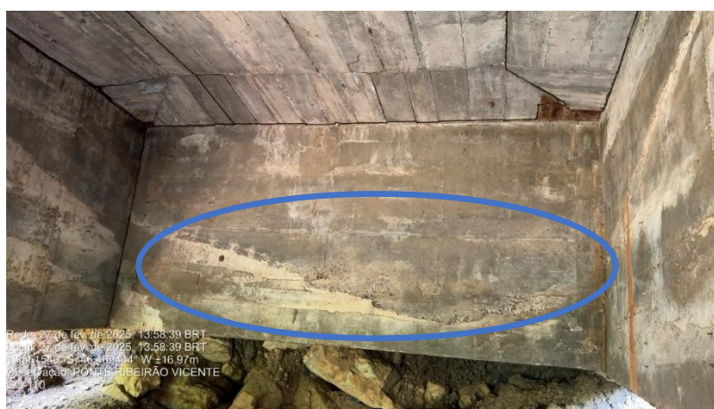
Figura 79 – Vista ampla do Encontro 02 apresentando nichos de concreto.
