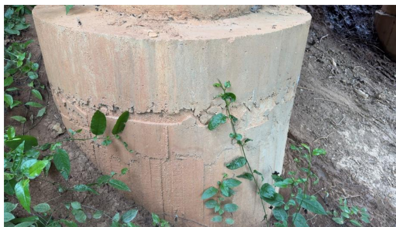
Figura 20 – Tubulão do Pilar 4.
