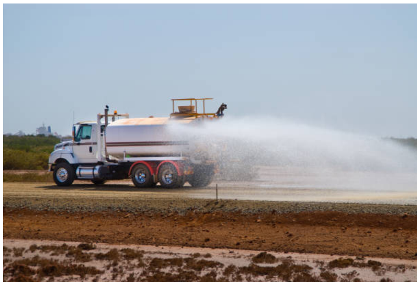
Figura 39. Umidificação da rodovia para o controle de emissão de poeira. Fonte: iStock.
