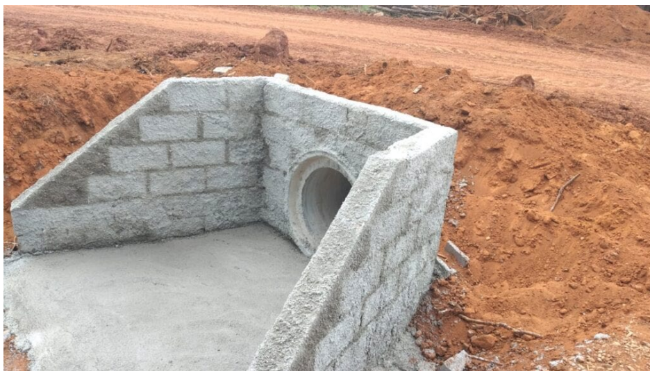
Figura 35. Exemplo de bueiro simples tubular de concreto.
