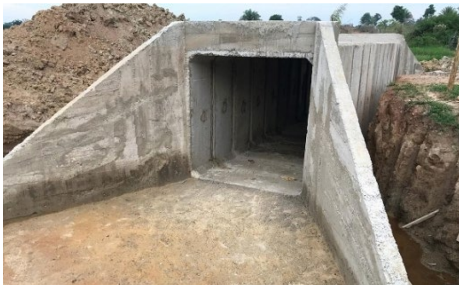
Figura 37. Exemplo de bueiro simples celular de concreto.
