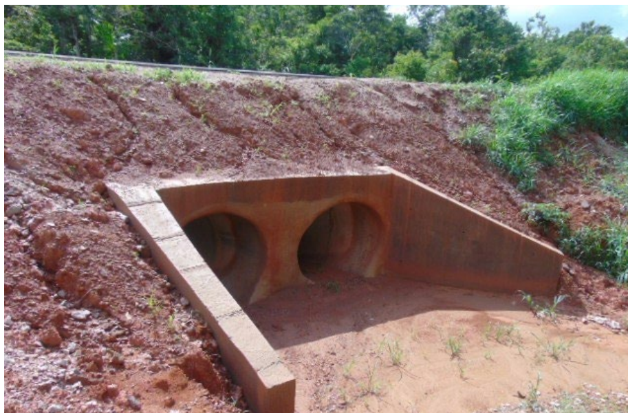
Figura 36. Exemplo de bueiro duplo tubular de concreto.
