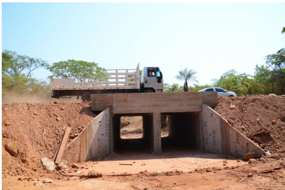
Figura 38. Exemplo bueiro duplo celular de concreto.
