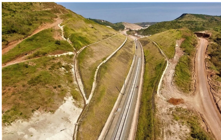
Figura 34. Aplicação de barreiras vegetais em traçado ferroviário.
