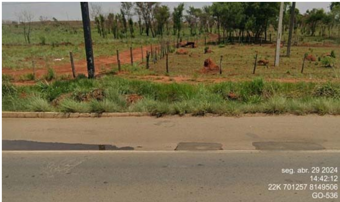
EST. 151 CERCA/POSTE LADO ESQUERDO
