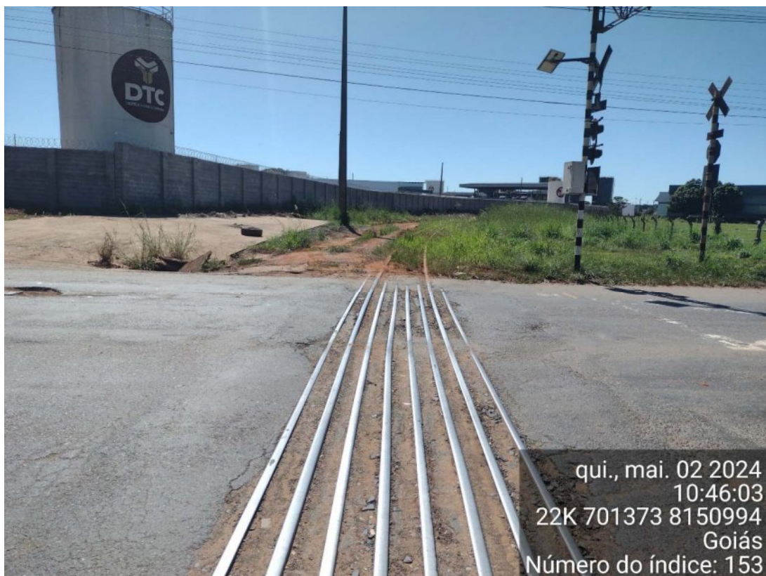
EST. 240+03 CRUZAMENTO FERROVIÁRIO LADO DIREITO
