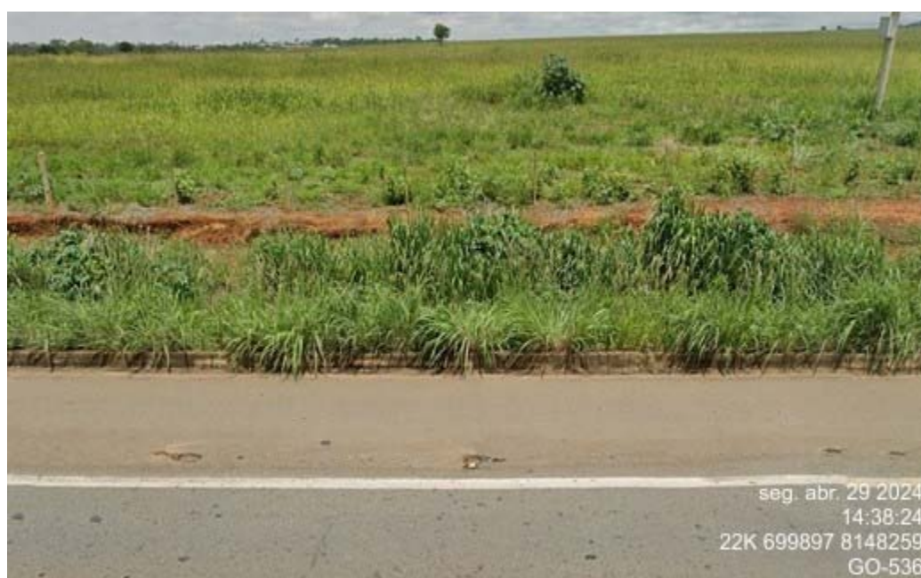
EST. 57 CERCA/POSTE LADO ESQUERDO
