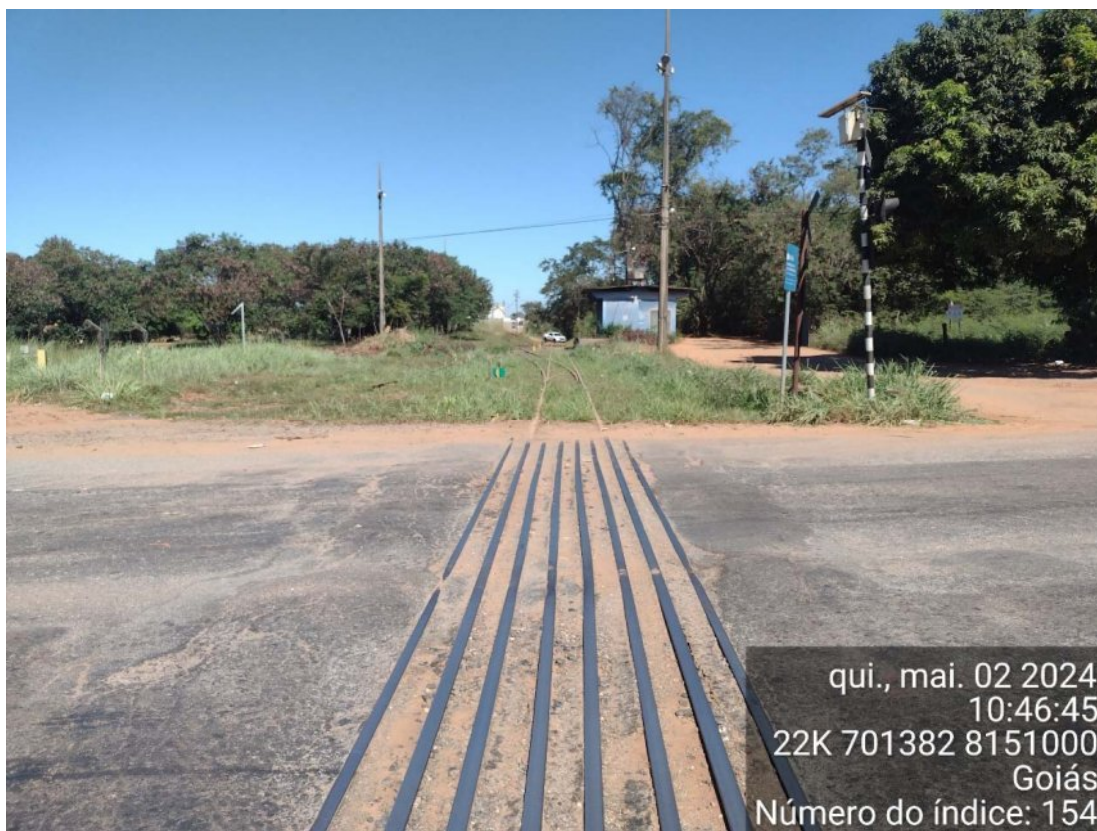
EST. 240+03 CRUZAMENTO FERROVIÁRIO LADO ESQUERDO
